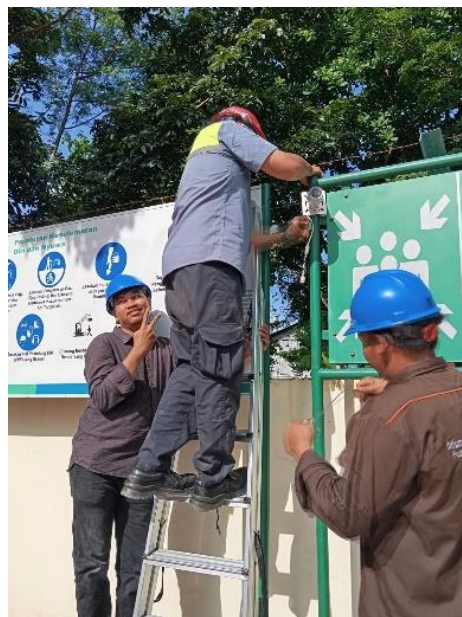
Gambar 3. 8 Install Unit CCRV di PT KLK
