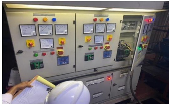
Gambar 2.31 Perbaikan control panel
