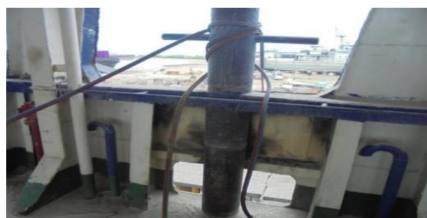
Gambar 2.25 Penyambungan cardeck bagian kiri
