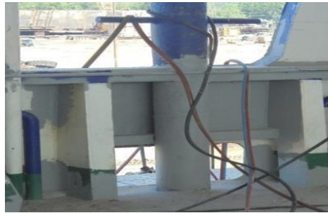
Gambar 2.28 Pengecatan cardeck bagian kiri
