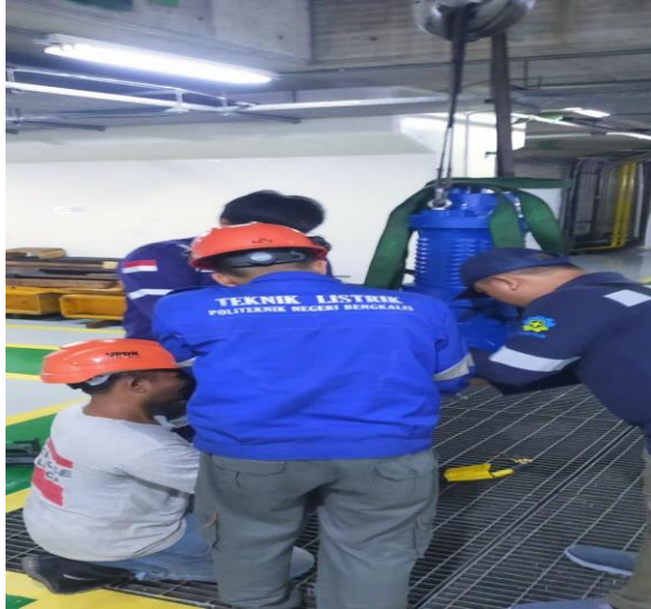
Gambar 3.41 Pemindahan pompa drainase
