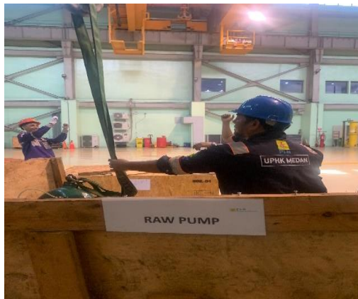
Gambar 3.56 Pemindahan motor raw water
