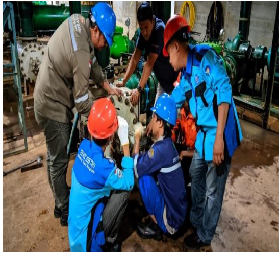
Gambar 3.24 Pembersihan pada filter stainer
