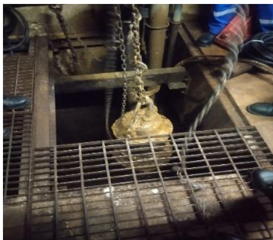
Gambar 3.42 Pengakatan pompa drainase
