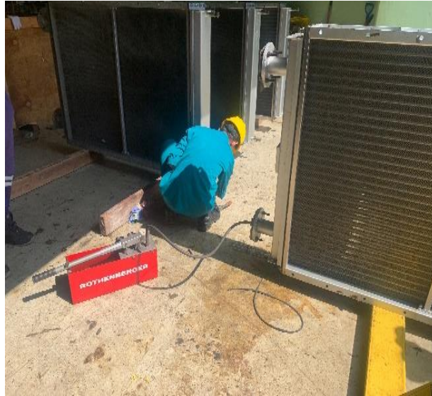
Gambar 3.75 Pembongkaran pada air culler
