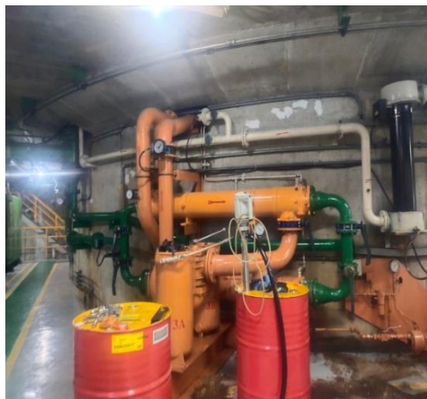
Gambar 3.51 Pengecekan pada oil vapor
