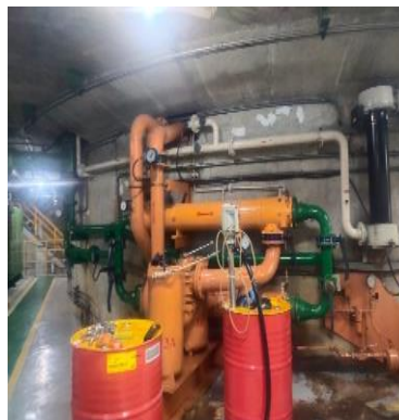
Gambar 3.60 pengecekan oli vapor
