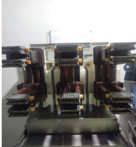
Gambar 3.81 Pembongkaran kontak utama
