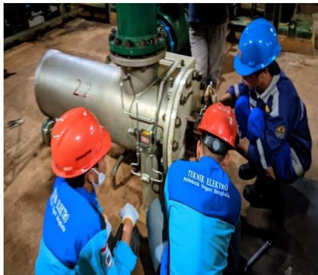
Gambar 3.25 Pembersihan pada filter stainer
