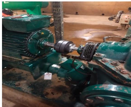
Gambar 3.62 Pembersihan pompa dan kopling
