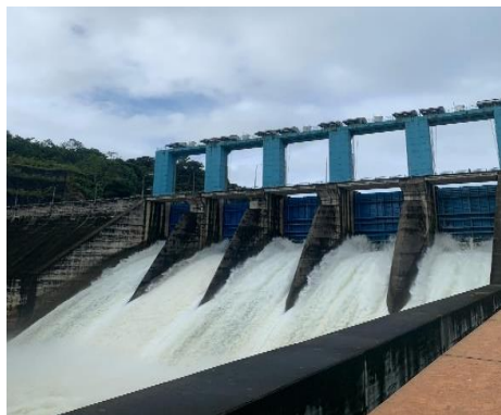
Gambar 3.19 Pembersihan limbah dan pembukaan pintu spill way
