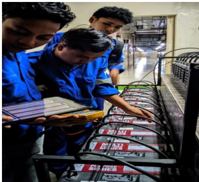
Gambar 3.7 melakukan pengukuran tegangan. (Sumber: dokemntasi penulis 2025)
