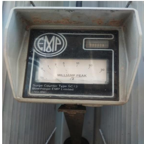
Gambar 3.65 Pengecekan skala di trafo
