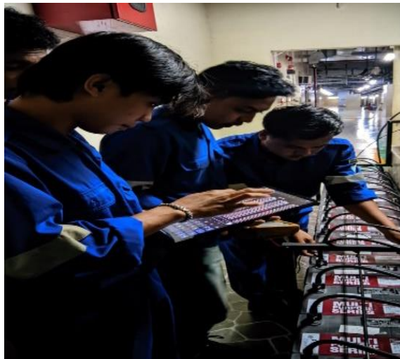
Gambar 3.34 Pengukuran tegangan batrai
