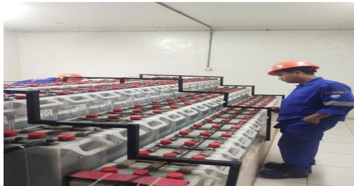
Gambar 4.1 Gambar baterai 110 volt vdc
