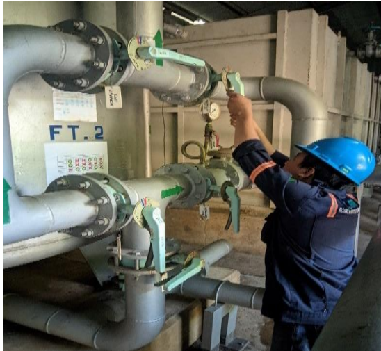
Gambar 3.95 Pembukaan valve di wtp
