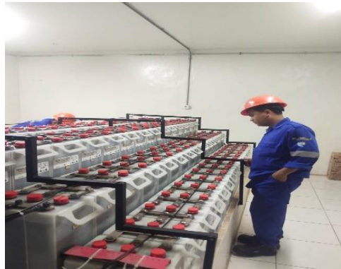
Gambar 3.63 Mengecek batrai basah dan batrai kering
