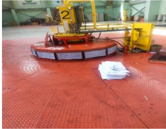
Gambar 3.38 Membersihkan di area slip ring (Sumber: dokemntasi penulis 2025)
