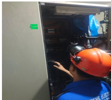
Gambar 3.70 Pengecekan di panel inverter
