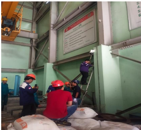
Gambar 3.98 Pemasangan cctc di lantai 1
