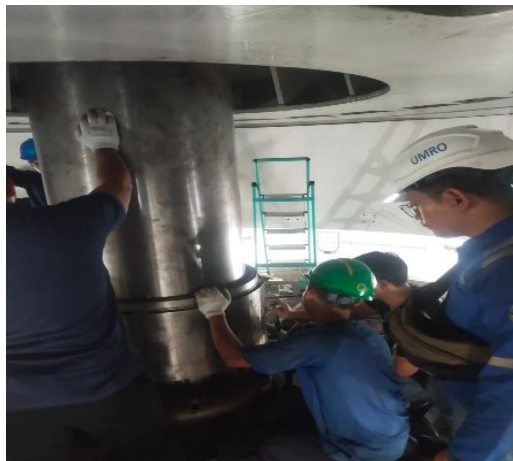
Gambar 3.90 Penurunan trans bering
