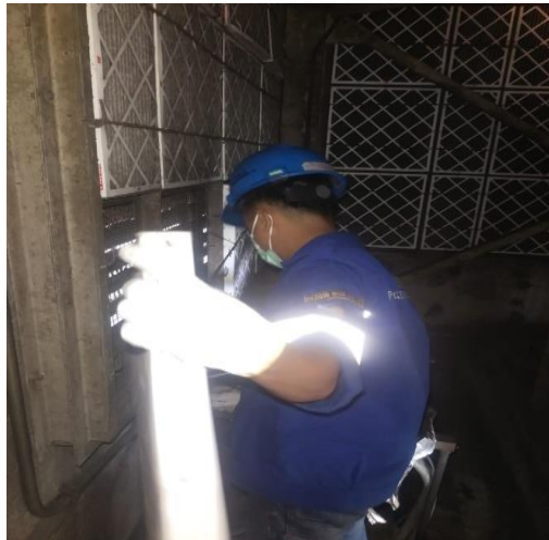
Gambar 3.44 Mengantikan filter udara
