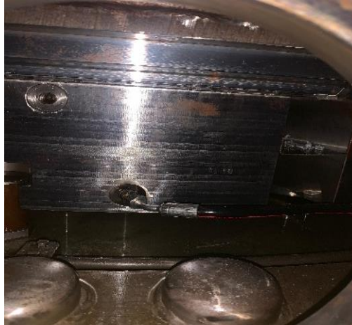
Gambar 3.85 Pengecekan pada bering
