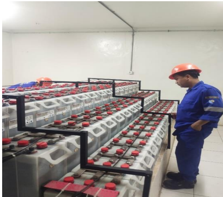
Gambar 4.10 Pemeliharaan baterai 110 vdc
