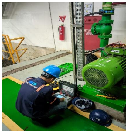
Gambar 3.76 Pengukuran nilai tahanan isolasi
