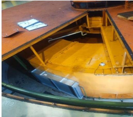
Gambar 3.73 Pembongkaran kabin generator
