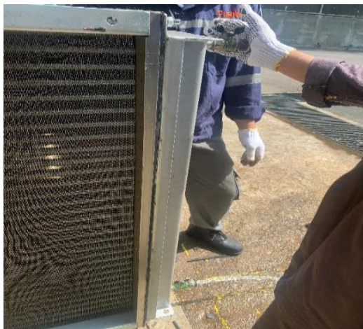
Gambar 3.74 Pembongkaran pada air culler
