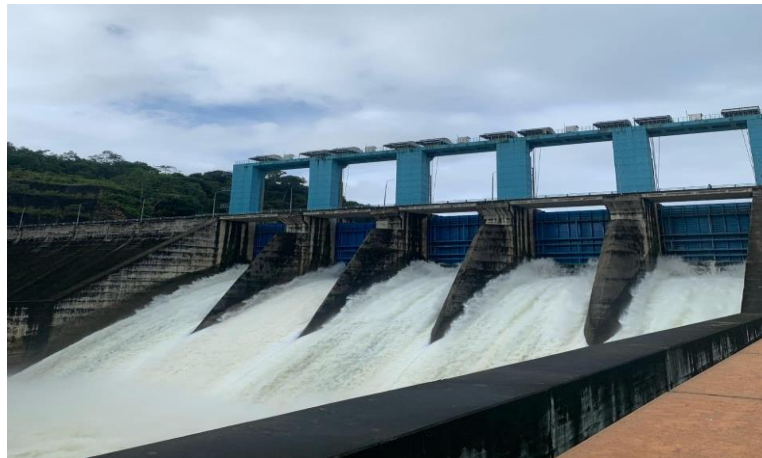
Gambar 3.20 Pembersihan limbah dan pembukaan pintu spill wayy
