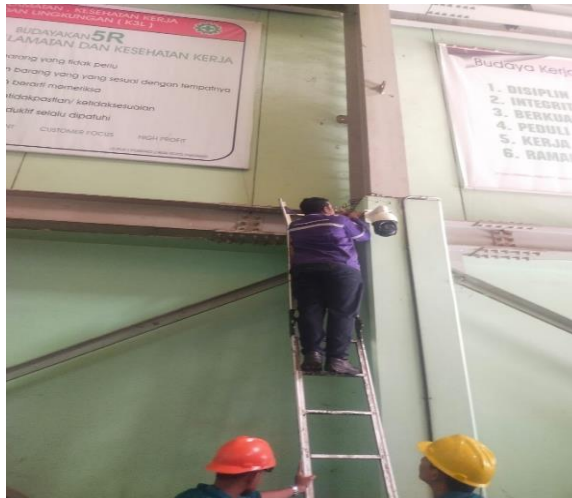
Gambar 3.101 Pemasangan cctc di lantai 1
