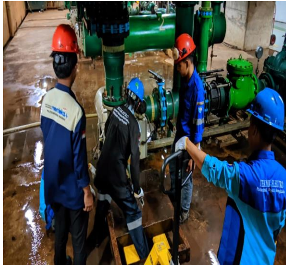
Gambar 3.29 Pembersihan pada filter stainer
