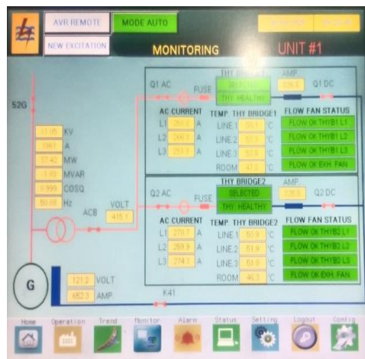
Gambar 3.54 Pengecekan pada nilai panel mcc
