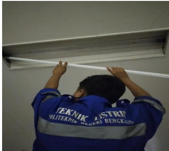
Gambar 3.32 Pergantian lampu di hr atas/bawah (Sumber: dokemntasi penulis 2025)
