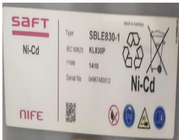
Gambar 4.15 Spesifikasi baterai (Sumber: dokemntasi penulis 2025)
