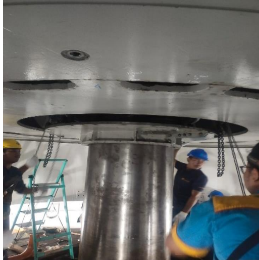
Gambar 3.91 Penurunan trans bering
