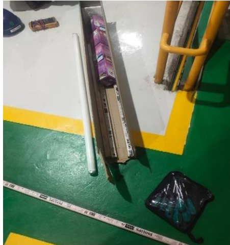
Gambar 3.69 Mengantikan lampu di B1
