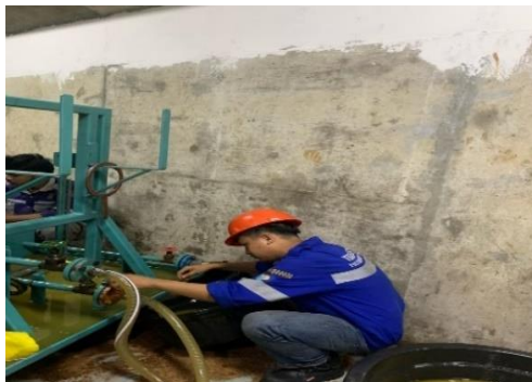
Gambar 3.31 Pergantian komponen di sperator (Sumber: dokumentasi penulis 2025)
