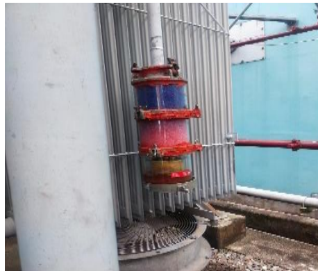
Gambar 3.66 Pengecekan selicajel
