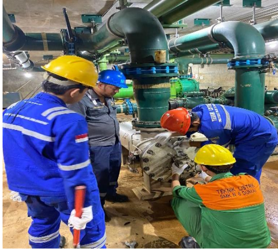
Gambar 3.93 Pencucian pada stainer
