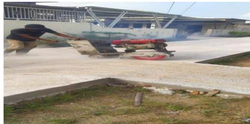
**Gambar 3. 41** Pekerjaan Pemotongan Beton (*Cutting*)
