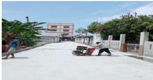
**Gambar 3. 37** Pekerjaan Pemotongan Beton (*Cutting*)
