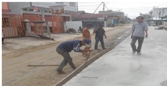
**Gambar 3. 29** Pembongkaran Bekisting (cetakan)
