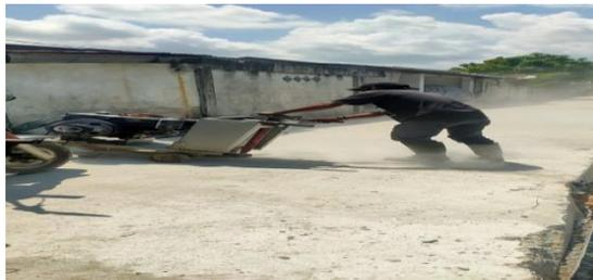
**Gambar 3. 20** Pekerjaan Pemotongan Beton (*cutting*)
