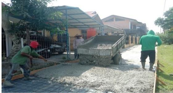
**Gambar 3. 12** Pengecoran Beton
