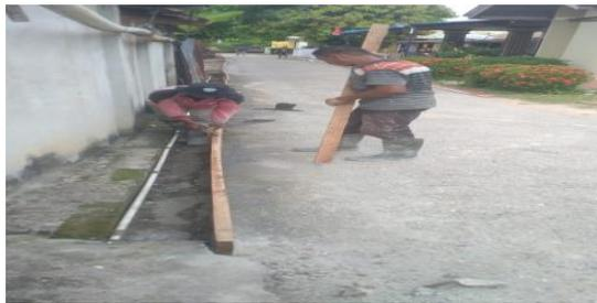
**Gambar 3. 32** Pemasangan Bekisting (Cetakan)
