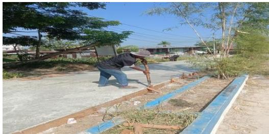
**Gambar 3. 13** Pembongkaran Bekisting (*curing*)
