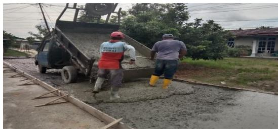
**Gambar 3. 18** Pekerjaan Pengecoran
