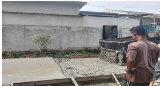
**Gambar 3. 39** Pengecoran Beton
