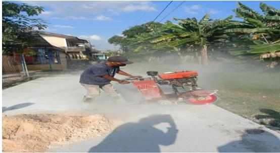
**Gambar 3. 14** Pekerjaan Pemotongan Beton (*Cutting*)
