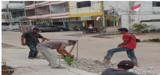
**Gambar 3. 22** Pembobokan Beton
