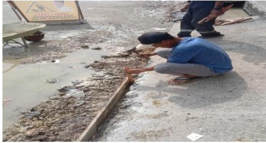
**Gambar 3. 24** Pemasangan Bekisting (cetakan)
