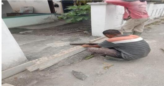
**Gambar 3. 16** Pemasangan Bekisting (cetakan)
