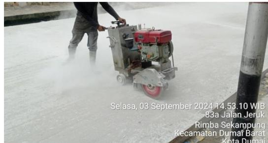
**Gambar 3. 30** Pekerjaan Pemotongan Beton (*Cutting*)
