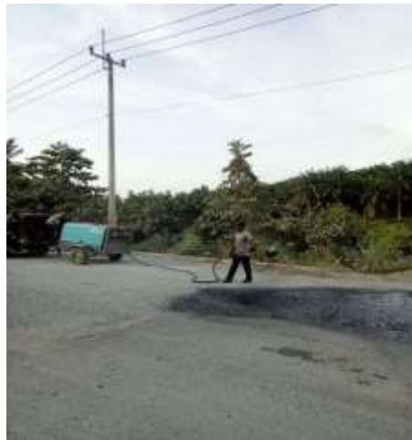
Gambar 3.26 Penyemprotan Prime Coat
