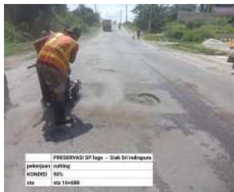
Gambar 3.19 Pekerjaan Cutting Aspal
