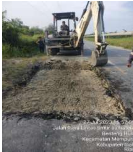
Gambar 3.20 Pembongkaran Permukaan Aspal
