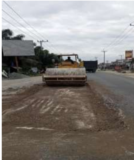
Gambar 3.22 Pekerjaan Pemadatan Galian Patching
