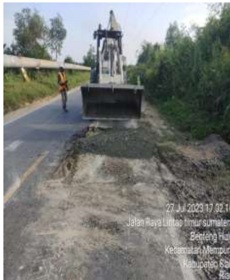
Gambar 3.23 Penghamparan Base A Pada Patching
