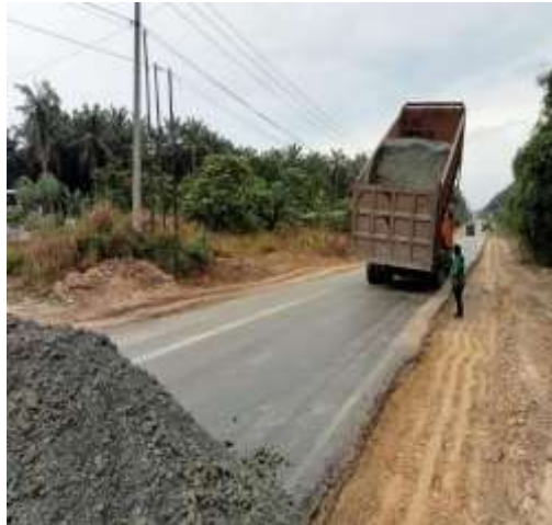
Gambar 4.11 Penuangan Base A Ke Lokasi
