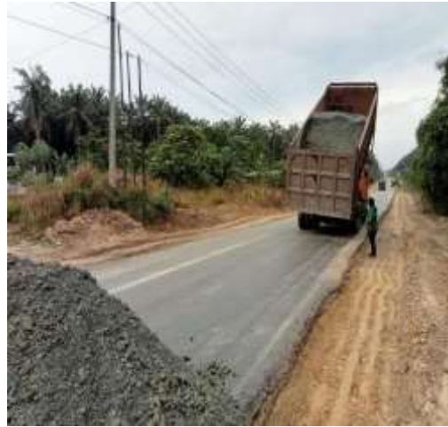
Gambar 3.16 Penuangan Material Agregat Kelas A
