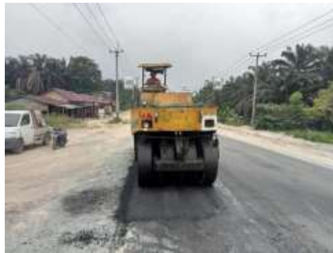
Gambar 3.29 Pemadatan CAP
