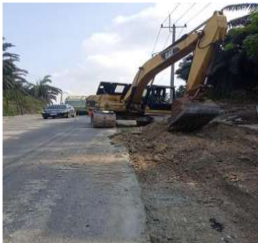
Gambar 3.13 Penggalian tanah pelebaran jalan
