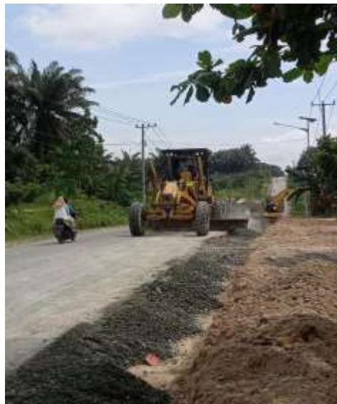
Gambar 3.17 Penghamparan Material Agregat Kelas A
