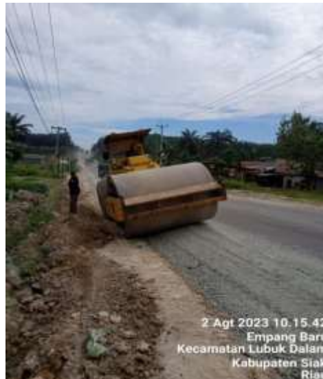
Gambar 3.18 Pemadatan Timbunan Agregat Kelas A
