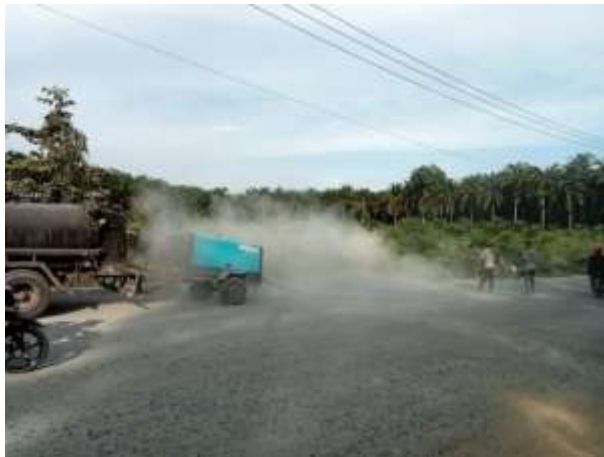
Gambar 3.25 Pembersihan Permukaan Base A
