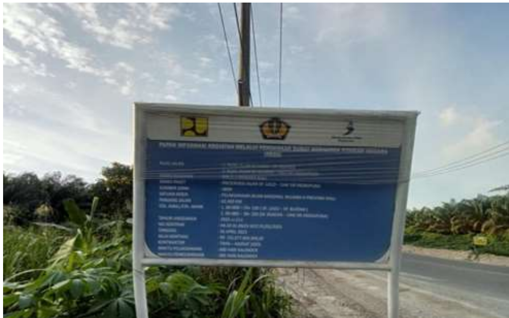
Gambar 2.1 Papan Nama Proyek
