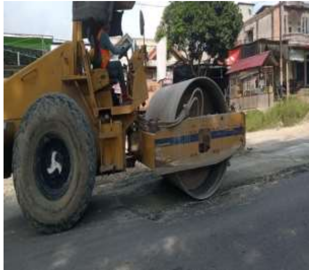
Gambar 3.24 Pemadatan Base A Pada Patching
