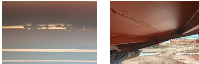
Gambar 3.3 Inspection welding pada sideboard Sumber : Penulis
