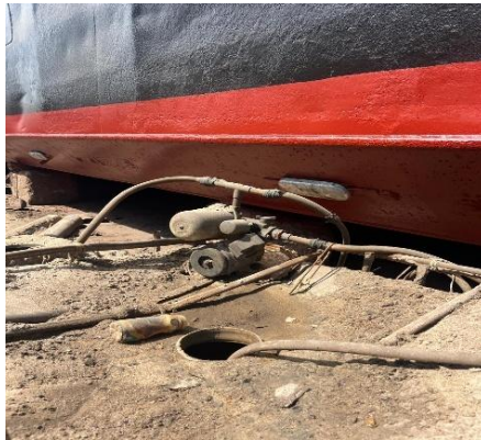
Gambar 4.4 Mesin pompa air dan tabung air
