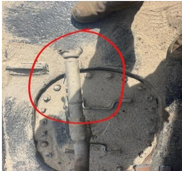
Gambar 4. 10 selang dari compressor koneksi pada flens pipa
