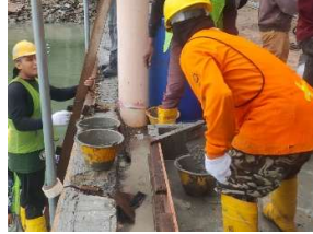
Gambar 3. 54 Membawa adukan beton secara estafet Sumber : Dokumentasi Lapangan, 2025
