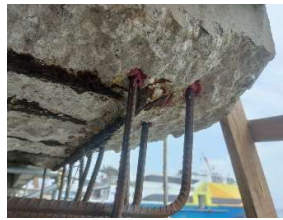
Gambar 3. 42 Hasil pemasangan tulangan baru menggunakan hilti Sumber : Dokumentasi Lapangan, 2025
