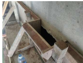
Gambar 3. 49 Jalur penghamparan beton Sumber : Dokumentasi Lapangan, 2025
