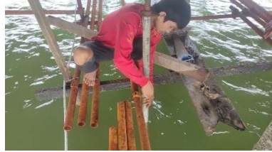
Gambar 3. 44 Pemasangan scaffolding sebagai tumpuan beban Sumber : Dokumentasi Lapangan, 2025
