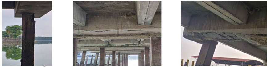
Gambar 3. 2 Kondisi Eksisting balok dan tiang pancang Sumber : Dokumentasi Proyek, 2025
