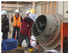
Gambar 3. 53 Memasukkan air kedalam concrete mixer
