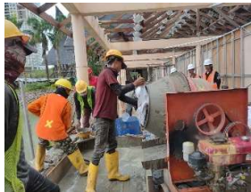
Gambar 3. 52 Memasukkan batu split 10 mm kedalam concrete mixer
