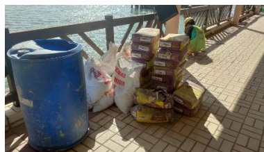
Gambar 3. 50 Material pengecoran Sumber : Dokumentasi Lapangan, 2025
