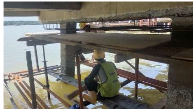
Gambar 3. 46 Pemasangan bekisting bagian bawah Sumber : Dokumentasi Lapangan, 2025
