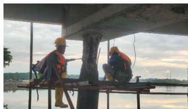
Gambar 3. 40 Pemotongan struktur yang rusak Sumber : Dokumentasi Lapangan, 2025
