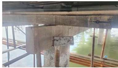
Gambar 3. 45 Pemasangan kayu kaso pada U-head scaffolding Sumber : Dokumentasi Lapangan, 2025
