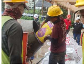
Gambar 3. 51 Memasukkan MU-800 kedalam concrete mixer
