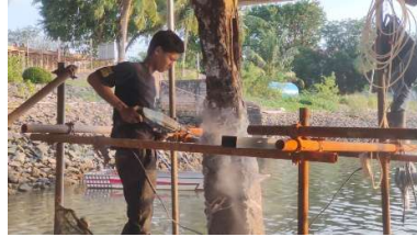
Gambar 3. 41 Pemasangan tulangan baru Sumber : Dokumentasi Lapangan, 2025
