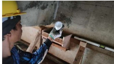
Gambar 3. 55 Penyiraman cairan sika bounding Sumber : Dokumentasi Lapangan, 2025
