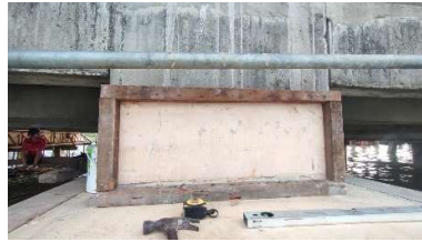
Gambar 3. 47 Pemasangan bekisting bagian dinding Sumber : Dokumentasi Lapangan, 2025
