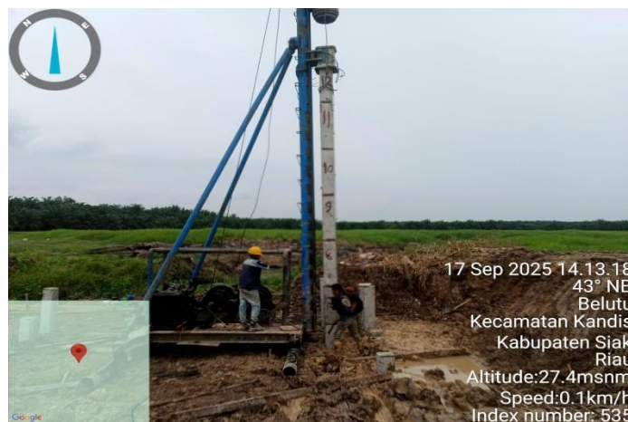
Gambar 3. 10 Proses Pemancangan Tiang Pancang Kedua
