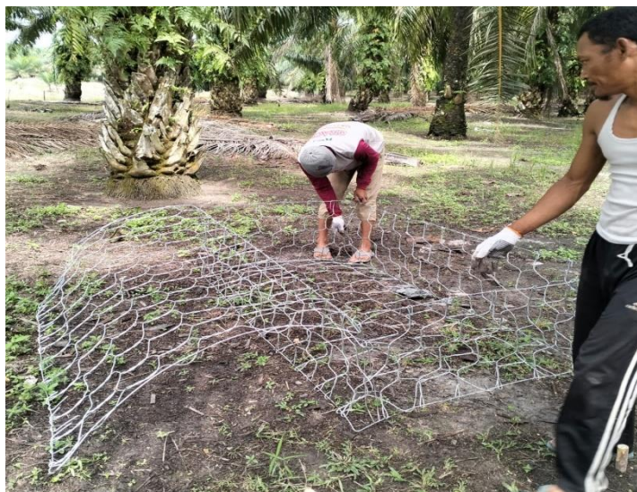
Gambar 3.37 Proses Perakitan Kawat Untuk Batu Beronjong
