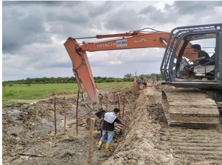
Gambar 3.37 Proses Pemasangan Kayu Cerocok
