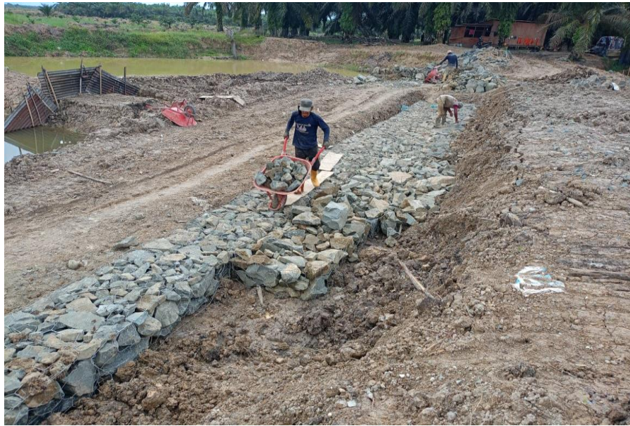
Gambar 3.38 Proses Pemasangan Batu Beronjong
