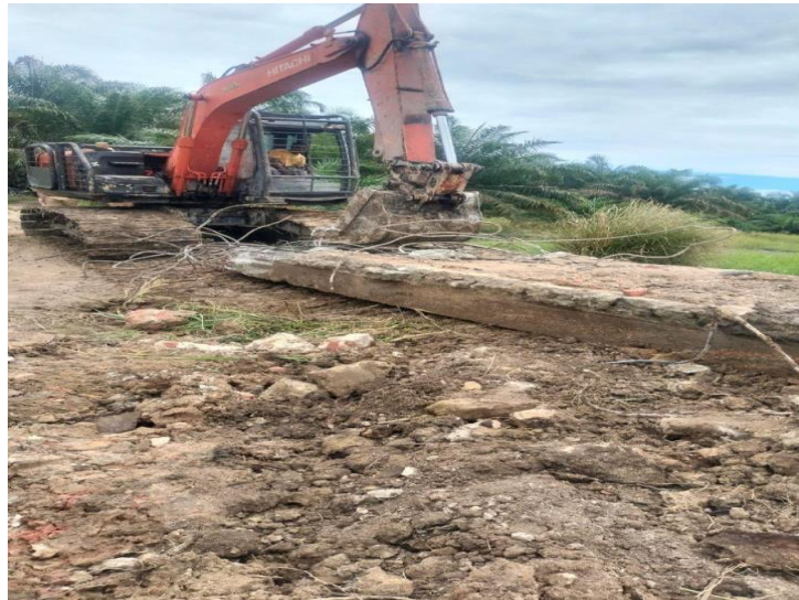
Gambar 3.13 Pembongkaran Jembatan Lama
