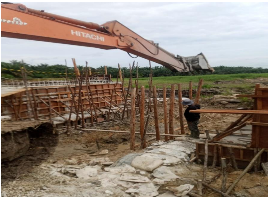
Proses Pemasangan Tiang Perancah Vertical
