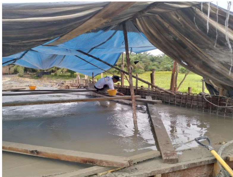
Gambar 3.36 Proses Pengecoran Lantai Jembatan
