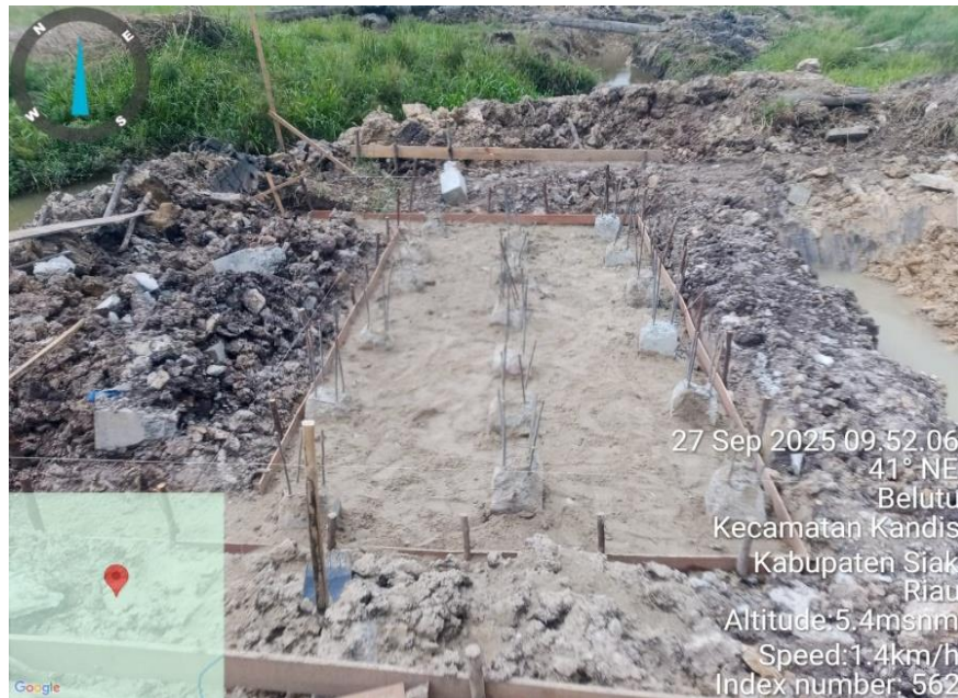
Pengecoran Lantai Kerja
