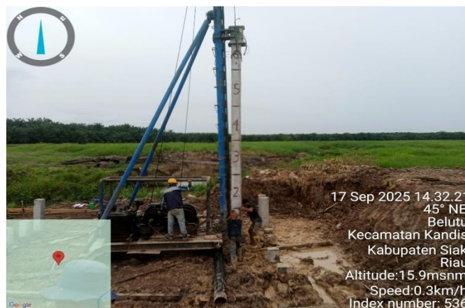
Gambar 3. 8 Pemancangan Tiang Pertama
