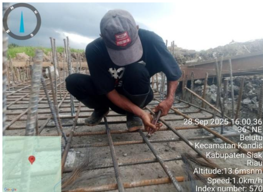
Proses Perakitan Besi Pile Cap
