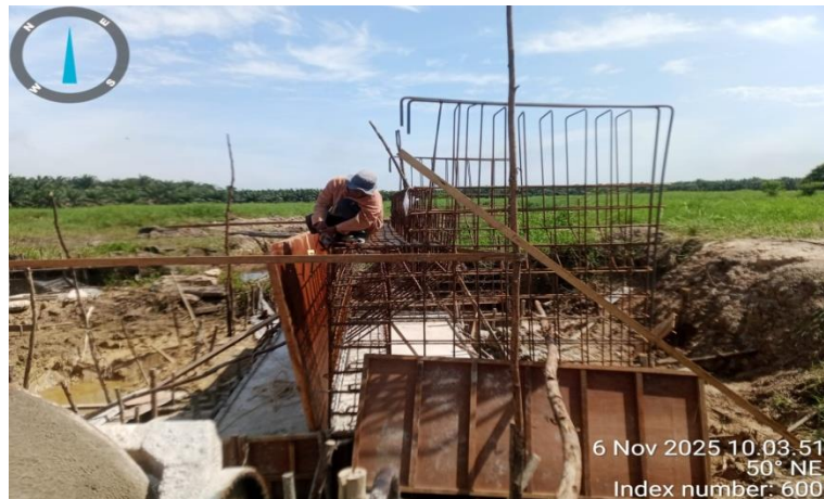
Gambar 3.27 Proses Perakitan Mal Tiang dan Sayap Abutment
