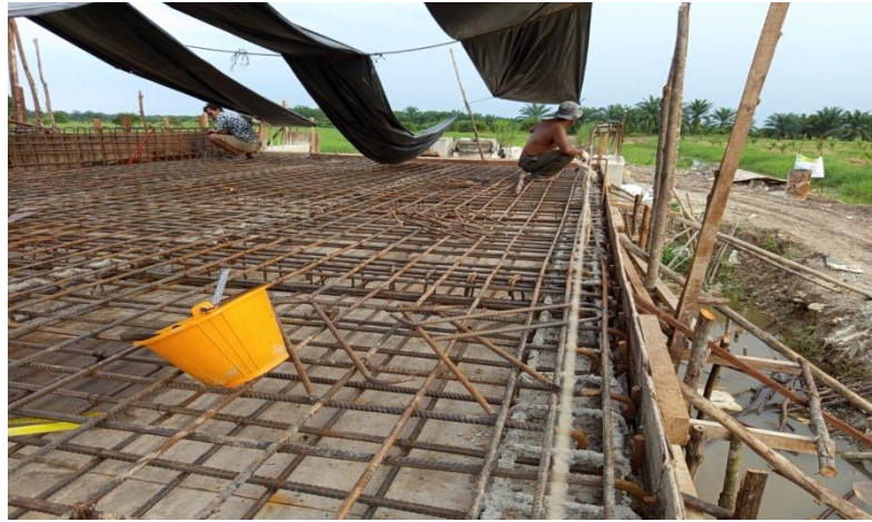
Gambar 3.34 Proses Perakitan Besi Lantai Jembatan
