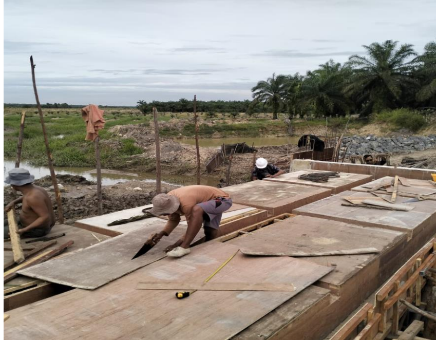
Gambar 3.30 Proses Pemasangan Tiang Perancah
