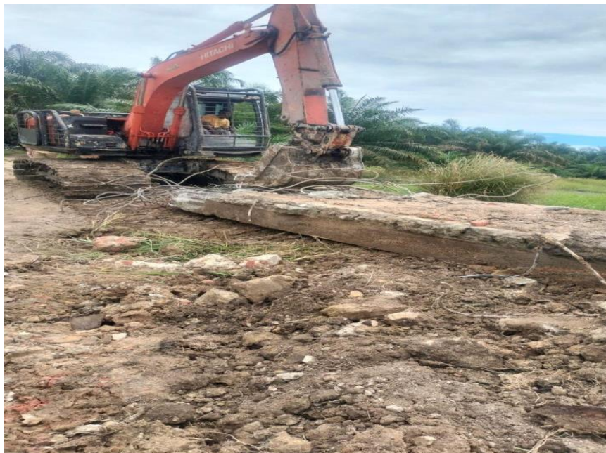
Pembongkaran Jembatan Lama
