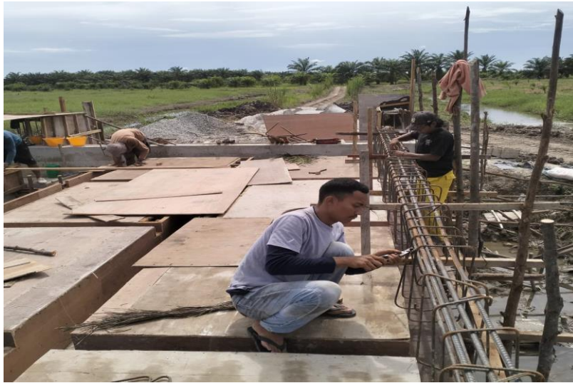
Gambar 3.31 Proses Perakitan Besi Girder Dan Diafragma
