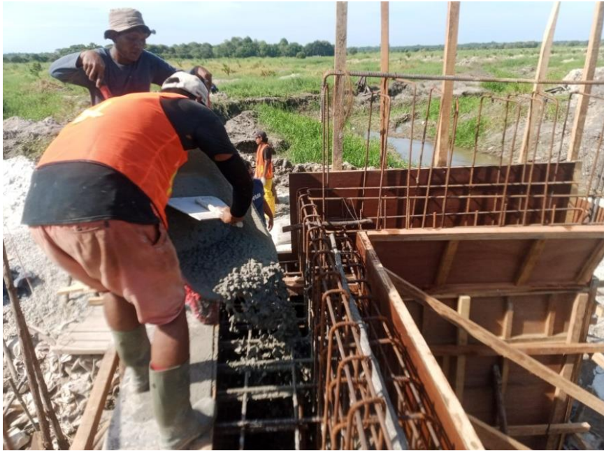
Proses Pengecoran Stem Wall
