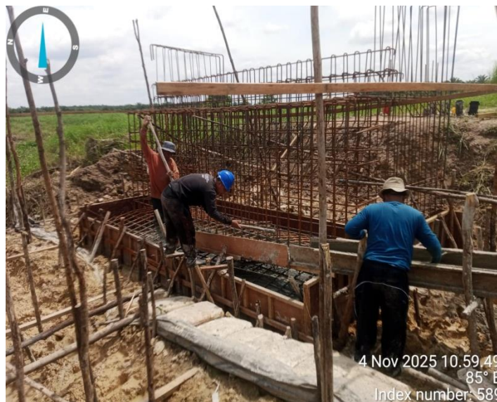
Gambar 3.25 Proses Pengecoran Tapak Abutment Jembatan
