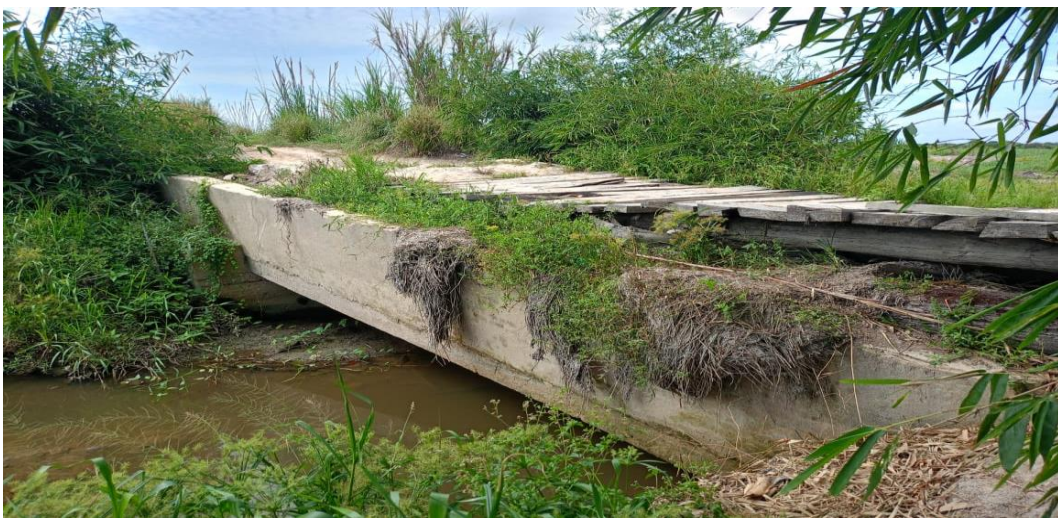
Gambar 3. 4 Kondisi Jembatan Yang Lama
