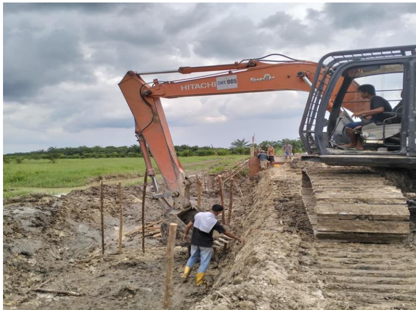
Proses Pemasangan Kayu Cerocok
