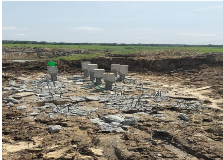
Gambar 3.19 Proses Pembobokan Tiang Pancang
