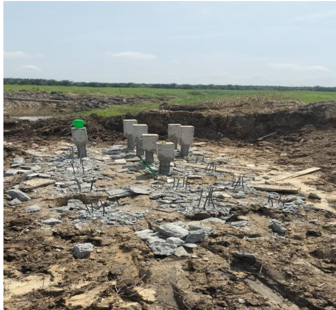
Gambar 3.12 Pekerjaan Pembobokan Sisa Tiang Pancang
