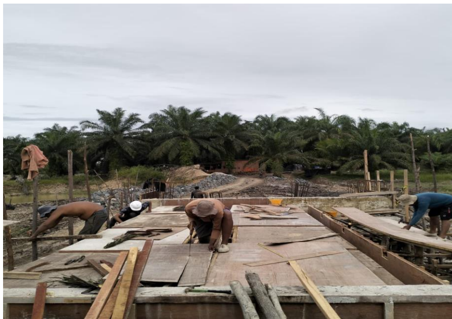
Proses Pembuatan Mal Pelat Lantai Jembatan
