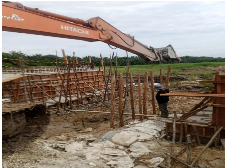
Gambar 3.29 Proses Pemasangan Tiang Perancah
