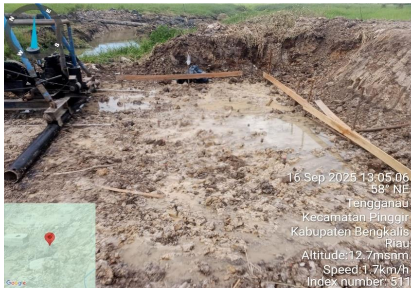
Pembuatan Patok Tiang Pancang
