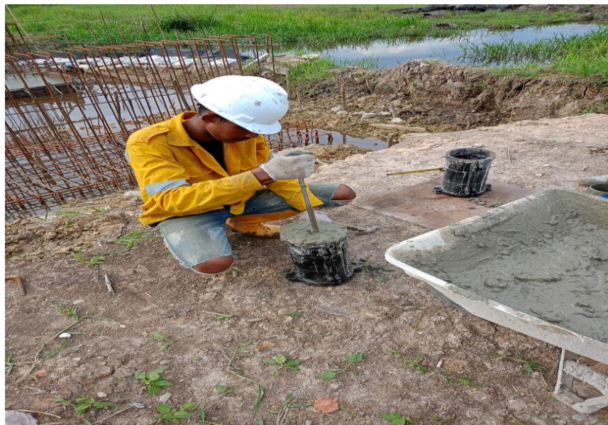
Pembuatan Sample Abutment Jembatan
