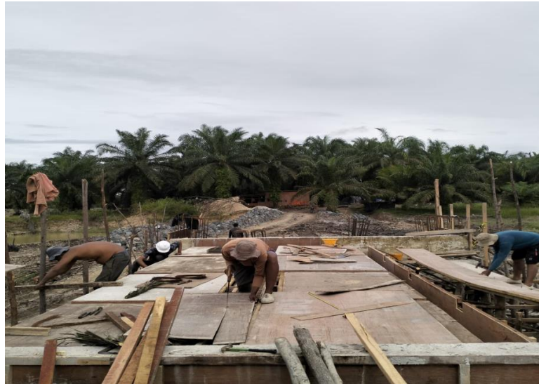
Gambar 3.33 Proses Pembuatan Mal Lantai Jembatan
