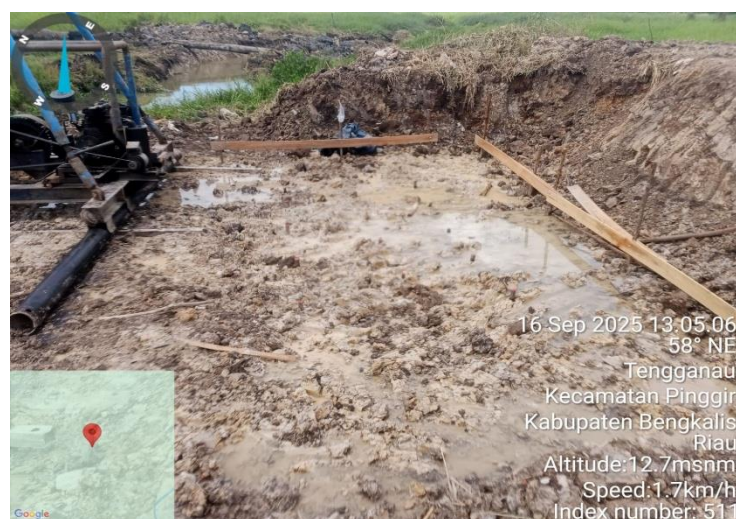
Gambar 3.16 Pembuatan Patok Untuk Tiang Pancang
