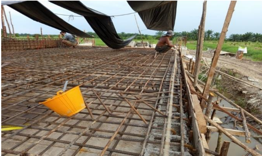
Proses Perakitan Besi Pelat Lantai Jembatan
