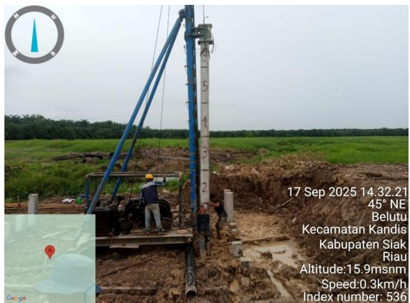
Proses Pemancangan Tiang Pancang
