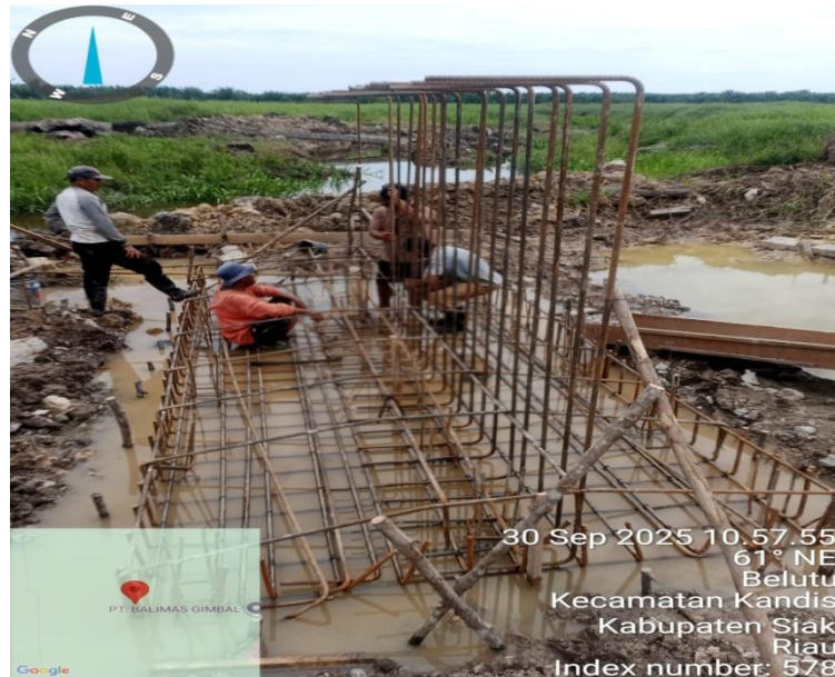
Gambar 3.26 Proses Perakitan Beso Tiang dan Sayap Abutment
