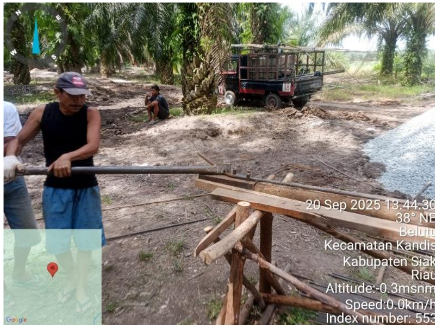
Proses Pembengkokan Besi Pile Cap
