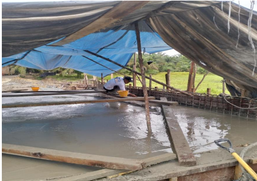
Proses Pengecoran Pelat Lantai Jembatan
