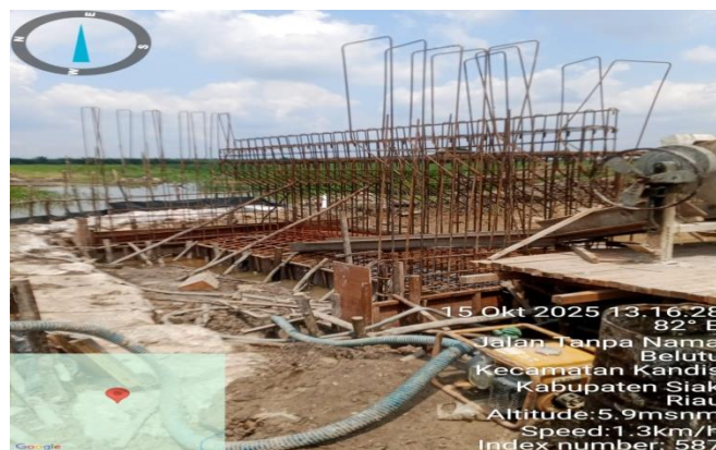
Gambar 3.22 Proses Perakitan Mal Untuk Tapak Abutment
