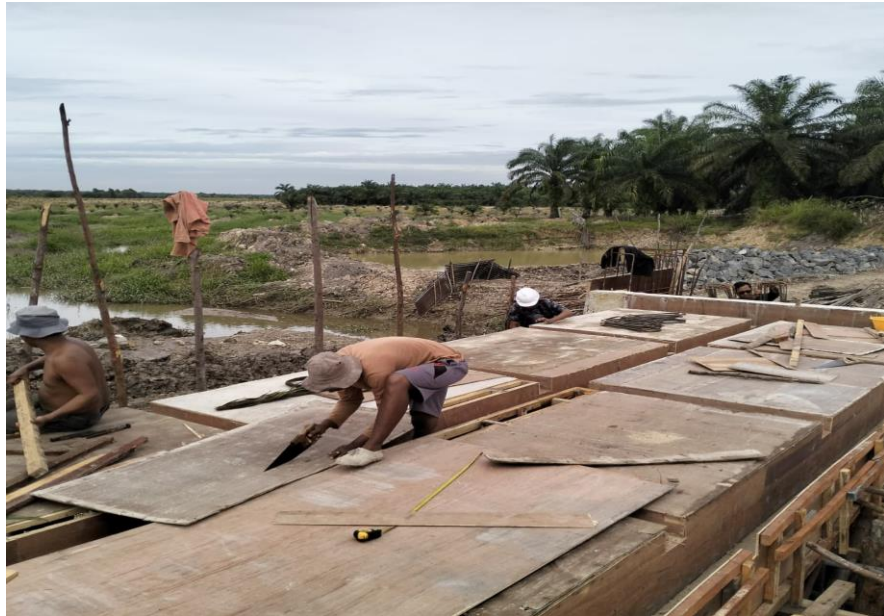
Proses Pemasangan Tiang Perancah Horizontal
