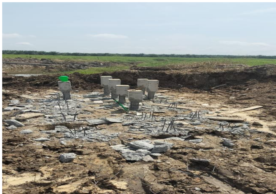
Proses Pembobokan Tiang Pancang
