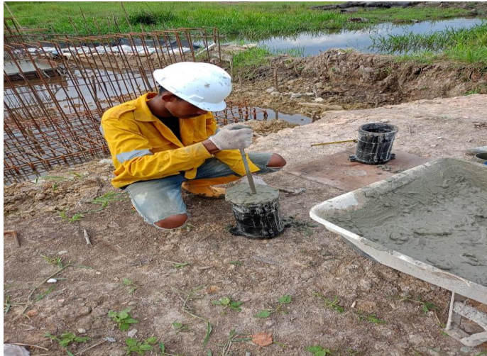
Gambar 3.24 Proses Pembuatan sampel Uji Beton
