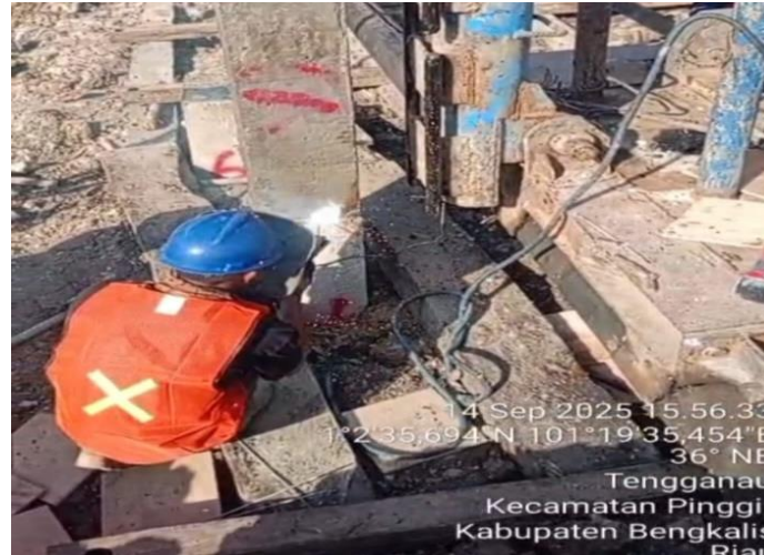
Gambar 3.9 Proses Pengelasan Sambungan Tiang Pancang
