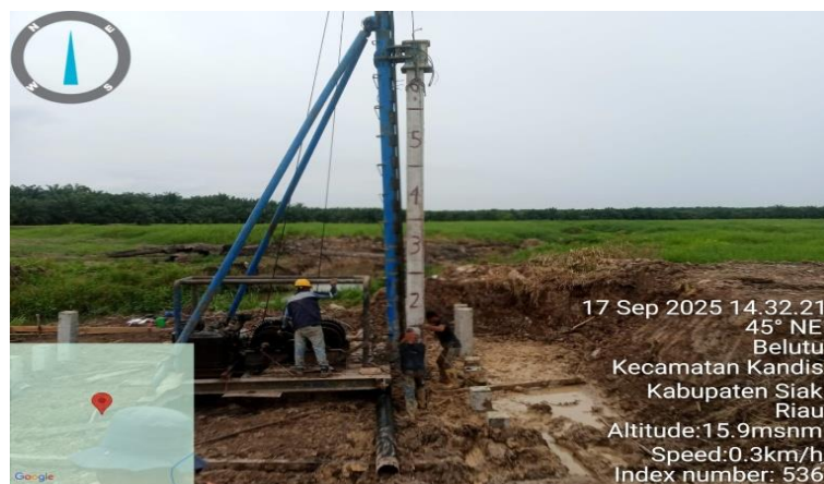
Gambar 3.17 Proses Pemancangan Tiang Pancang
