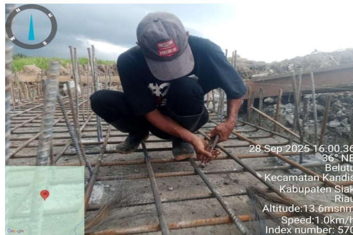
Gambar 3.21 Proses Perakitan Besi Untuk Tapak Abutment
