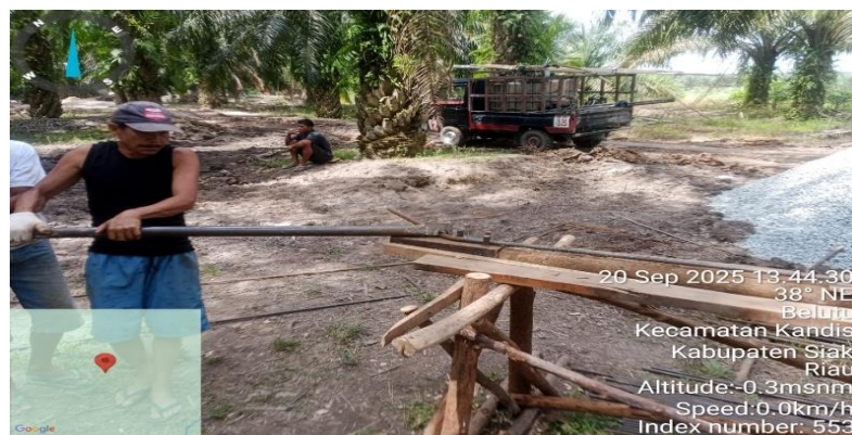
Gambar 3.20 Proses Pembuatan Besi Untuk Tapak Abutment
