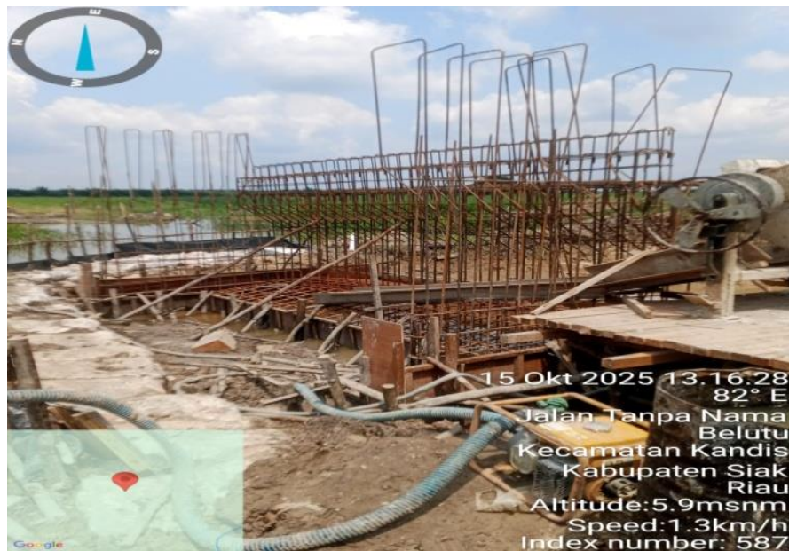
Proses Perakitan Mal Pile Cap
