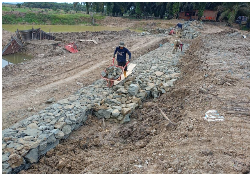
Proses Pemasangan Batu Beronjong
