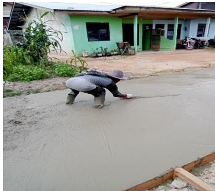
Gambar 3. 13 Perataan Permukaan Beton (Sumber: Dokumentasi KP, 2024)
