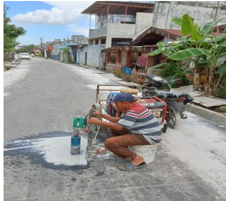
Gambar 3. 81 Pekerjaan Core Drill (Sumber: Dokumentasi KP, 2024)
