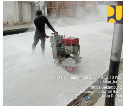
Gambar 3. 61 Pekerjaan Cutting
