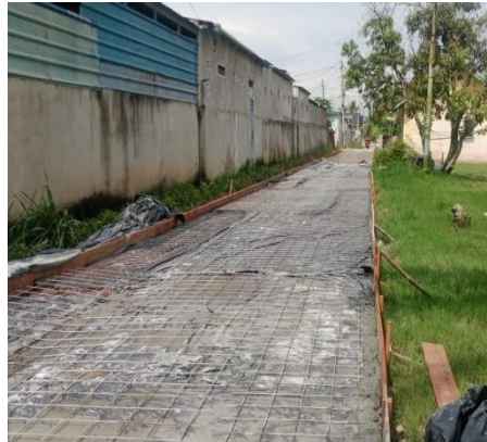
Gambar 3. 89 Pemasangan Bekisting (Sumber: Dokumentasi KP, 2024)
