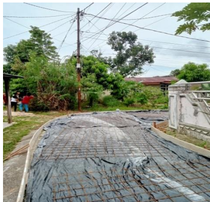
Gambar 3. 28 Pemasangan Plastik Cor (Sumber: Dokumentasi KP, 2024)
