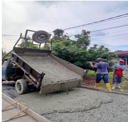
Gambar 3. 31 Penuangan Ready Mix (Sumber: Dokumentasi KP, 2024)
