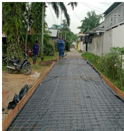
Gambar 3. 90 Pemasangan Plastik Co (Sumber: Dokumentasi KP, 2024)
