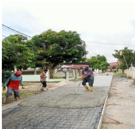
Gambar 3. 32 Pemadatan Beton (Sumber: Dokumentasi KP, 2024)
