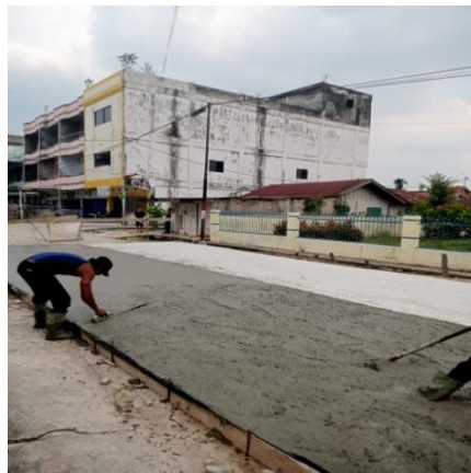
Gambar 3. 57 Perataan Permukaan Bton
