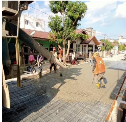
Gambar 3. 74 Penuangan Ready Mix (Sumber: Dokumentasi KP, 2024)
