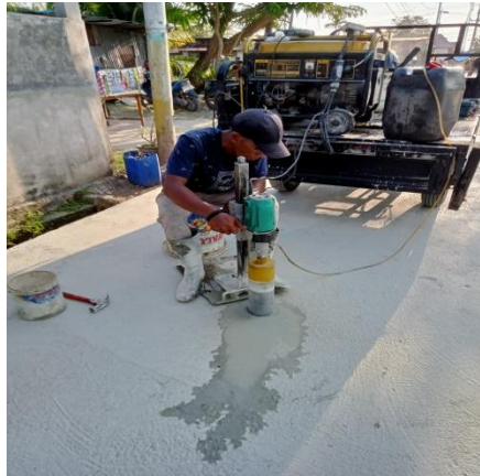
Gambar 3. 18 Proses Peng-core-an (Sumber: Dokumentasi KP, 2024)
