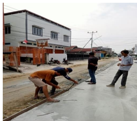
Gambar 3. 60 Pembongkaran Bekisting
