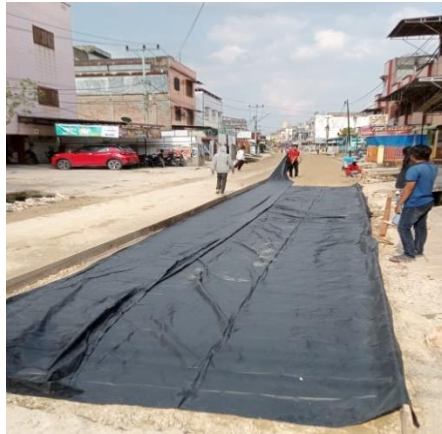
Gambar 3. 52 Pemasangan Plastik Cor (Sumber: Dokumentasi KP, 2024)
