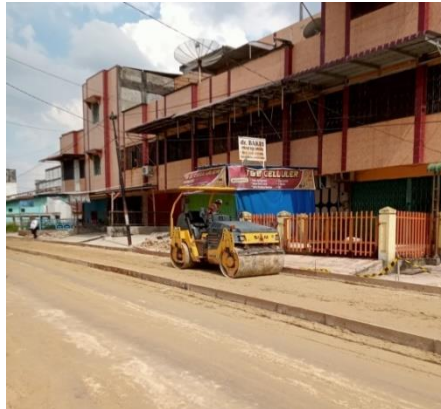
Gambar 3. 43 Vibratory Roller (Sumber: Dokumentasi KP, 2024)
