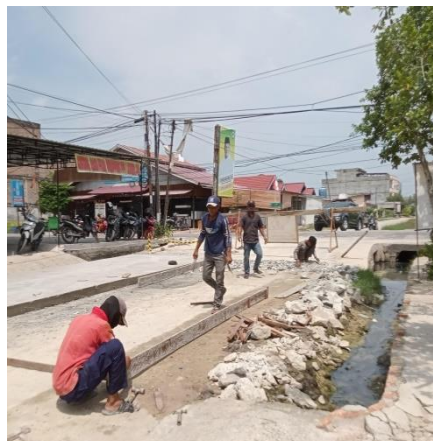
Gambar 3. 51 Pemasangan Bekisting (Sumber: Dokumentasi KP, 2024)
