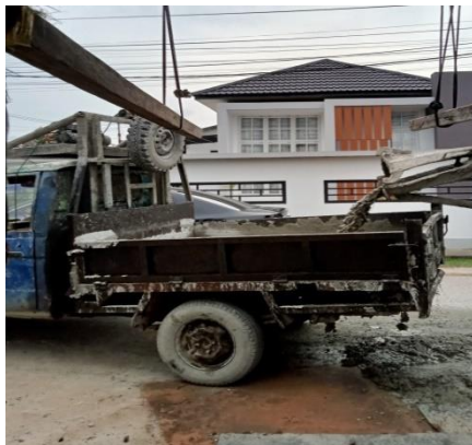
Gambar 3. 30 Penuangan Ready Mix ke Dalam Pick Up (Sumber: Dokumentasi KP, 2024)
