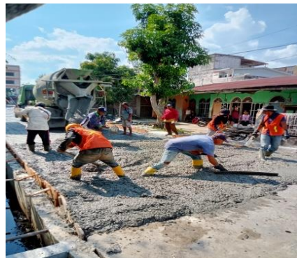
Gambar 3. 75 Pemadatan Beton (Sumber: Dokumentasi KP, 2024)
