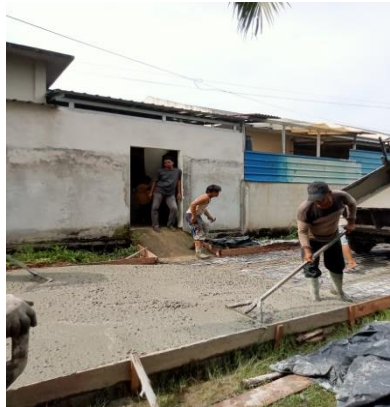
Gambar 3. 93 Pemadatan Beton (Sumber: Dokumentasi KP, 2024)
