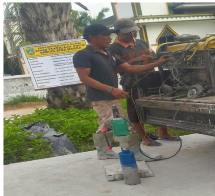
Gambar 3. 98 Pekerjaan Core Drill
