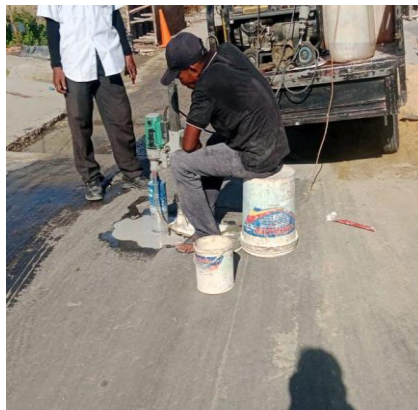
Gambar 3. 46 Mesin Core Drill (Sumber: Dokumentasi KP, 2024)
