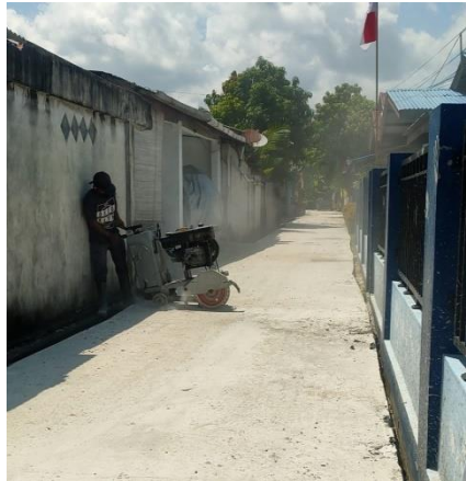
Gambar 3. 36 Pekerjaan Cutting (Sumber: Dokumentasi KP, 2024)
