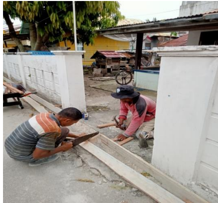
Gambar 3. 27 Pemasangan Bekisting (Sumber: Dokumentasi KP, 2024)
