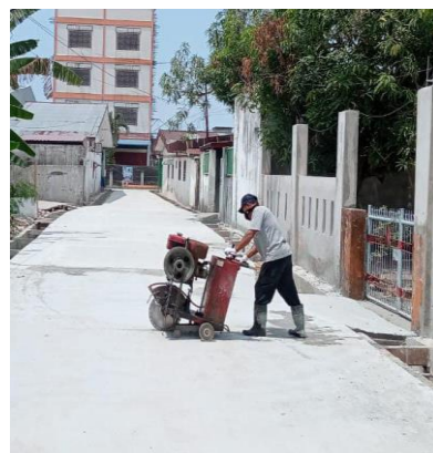
Gambar 3. 80 Pekerjaan Cutting (Sumber: Dokumentasi KP, 2024)
