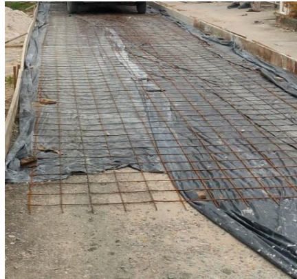
Gambar 3. 29 Pemasangan Besi Wiremesh (Sumber: Dokumentasi KP, 2024)
