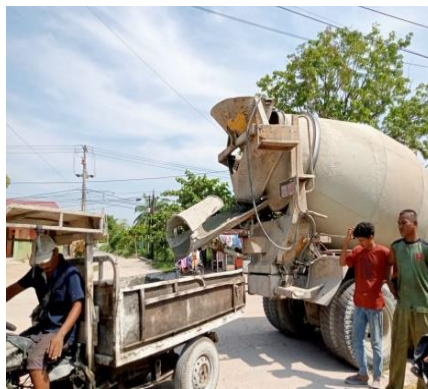
Gambar 3. 10 Penuangan Ready Mix ke Dalam Kaisar (Sumber: Dokumentasi KP, 2024)
