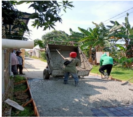
Gambar 3. 11 Penuangan Ready Mix ke Tempat Pengecoran (Sumber: Dokumentasi KP, 2024)
