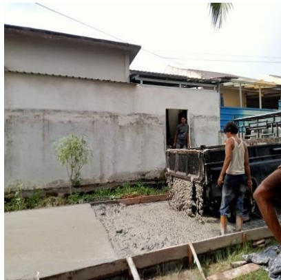
Gambar 3. 92 Penuangan Ready Mix (Sumber: Dokumentasi KP, 2024)
