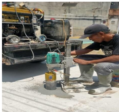
Gambar 3. 37 Proses Peng-core-an (Sumber: Dokumentasi KP, 2024)
