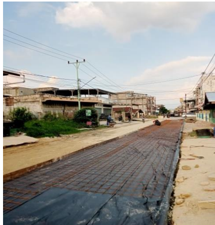
Gambar 3. 53 Pemasangan Besi Wiremesh (Sumber: Dokumentasi KP, 2024)
