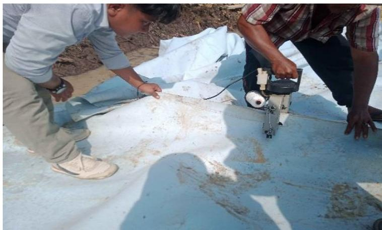
Gambar 3. 12 Penjahitan geotextile
