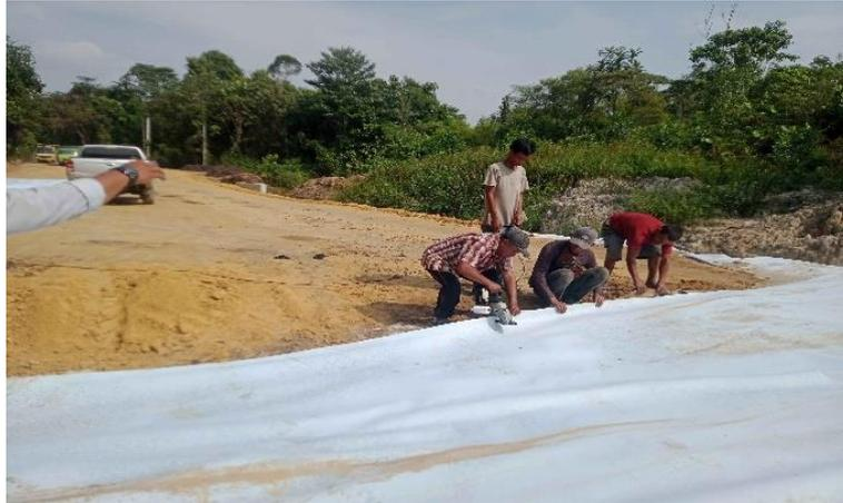
Gambar 3. 11 Pemasangan geotextile
