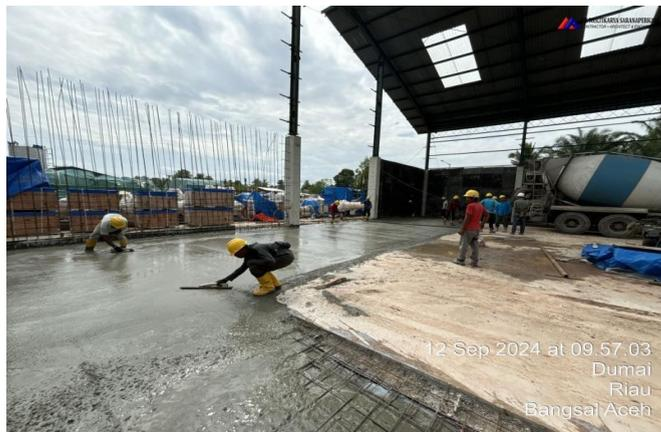
Gambar 3. 22 Pengecoran Lantai
