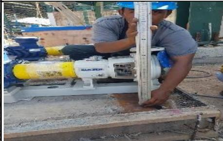
Melevel baut untuk dudukan equipment di extraction plant
