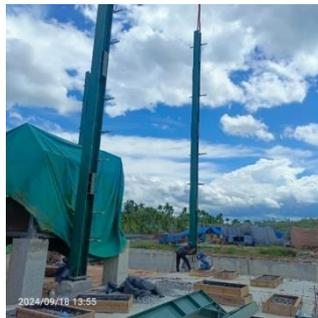
Gambar 3. 25 Pengangkatan kolom
