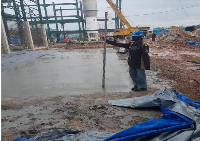
Gambar 3. 20 Pengecoran level lantai
