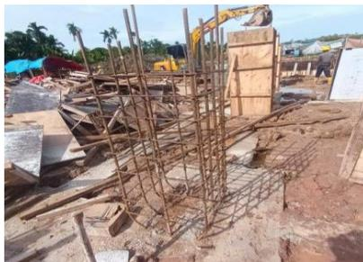
Gambar 3. 13 Tulangan sengkang untuk kolom
