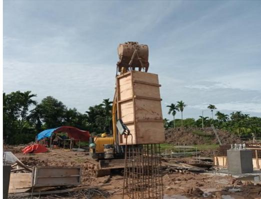
Gambar 3. 14 Pemasangan *bekesting* kolom
