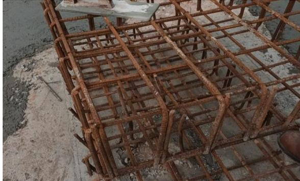
Gambar 3. 23 Pemasangan Besi *Equipment*
