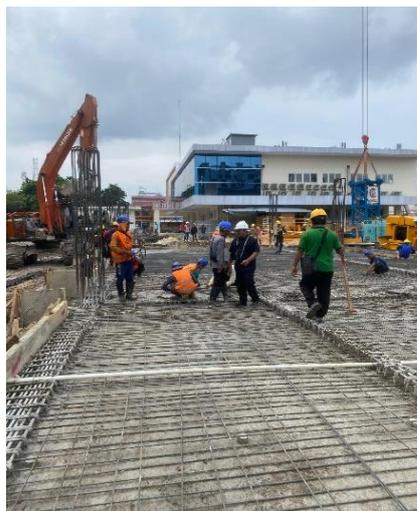
Gambar 3. 39 Pekerjaan Pembesian lantai dasar
