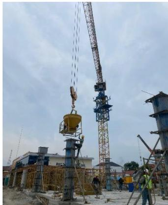
Gambar 3. 46 Pekerjaan pengecoran kolom
