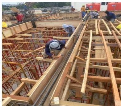
Gambar 3. 50 Pemasangan bekisting balok
