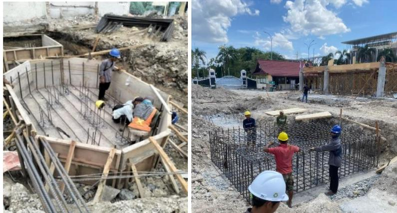
Gambar 3. 22 Pekerjaan penempatan tulangan
