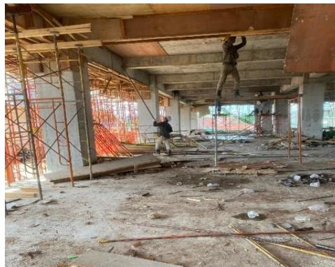
Gambar 3. 53 Pekerjaan pembongkaran bekisting
