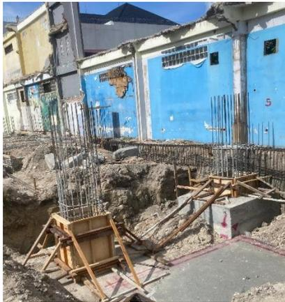
Gambar 3. 26 Pekerjaan bekisting kolom pedestal
