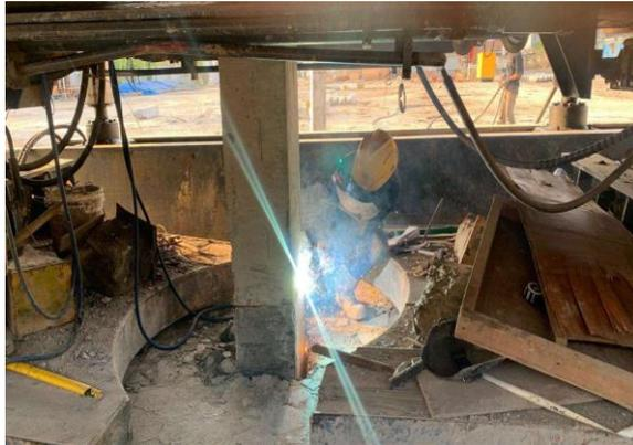
Gambar 3. 15 Pekerjaan pengelasan sambungan tiang pancang
