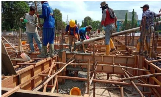
Gambar 3. 34 Pekerjaan pengecoran sloof
