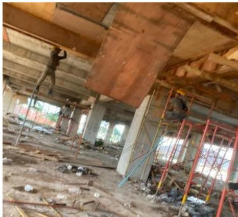
Gambar 3. 58 Pekerjaan pembongkaran bekisting
