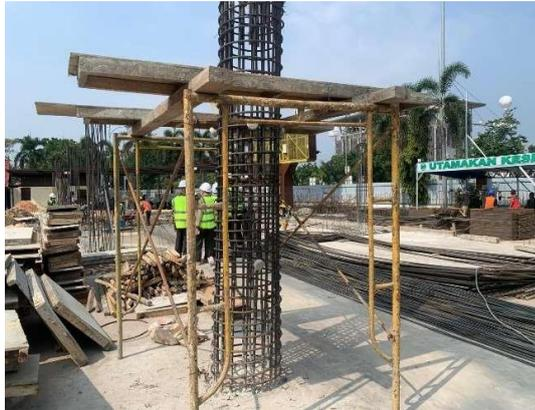
Gambar 3. 44 Pekerjaan penulangan kolom
