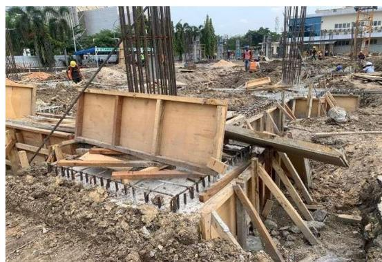
Gambar 3. 27 Pekerjaan pembongkaran bekisting
