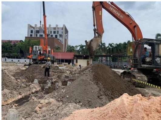
Gambar 3. 19 Penggalian tana pile cap dengan excavator
