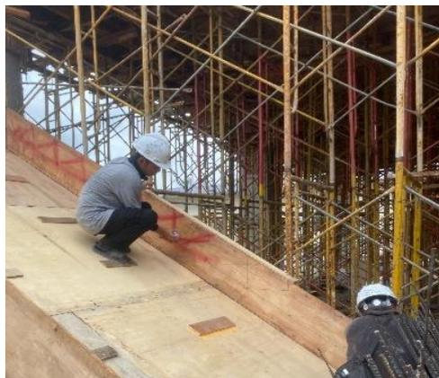
Gambar 3. 62 Pekerjaan marking tangga
