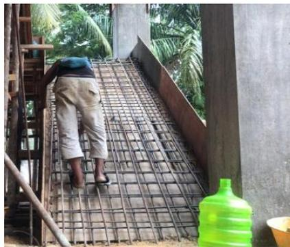
Gambar 3. 63 Pekerjaan penulangan tangga
