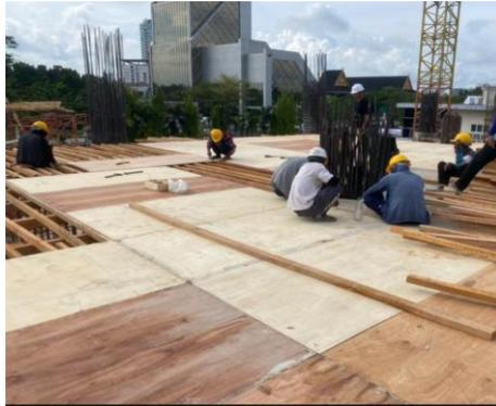
Gambar 3. 55 Pekerjaan pemasangan bekisting
