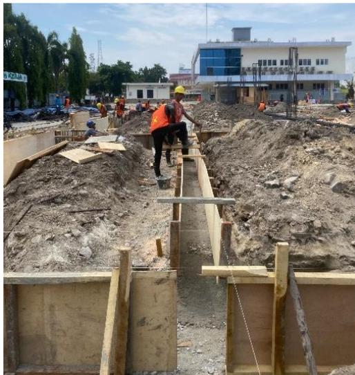
Gambar 3. 33 Pekerjaan bekisting sloof
