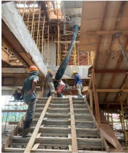
Gambar 3. 64 Pekerjaan pengecoran tangga
