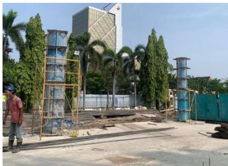
Gambar 3. 45 Pekerjaan pemasangan bekisting kolom
