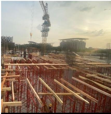
Gambar 3. 54 Pekerjaan pemasangan perancah
