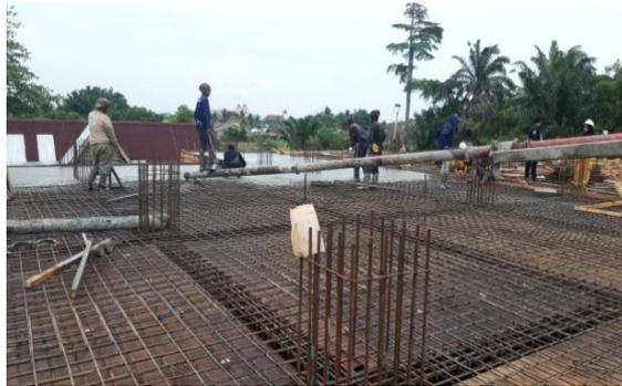
Gambar 3. 52 Pengecoran balok disertai pengecoran plat
