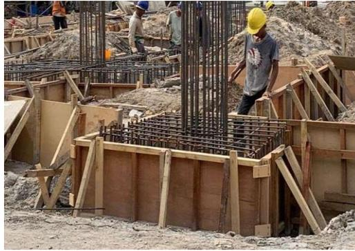
Gambar 3. 24 Pekerjaan penempatan tulangan
