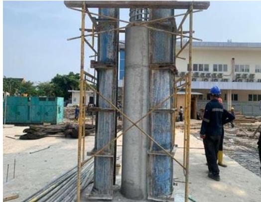
Gambar 3. 47 . Pekerjaan pembongkaran bekisting
