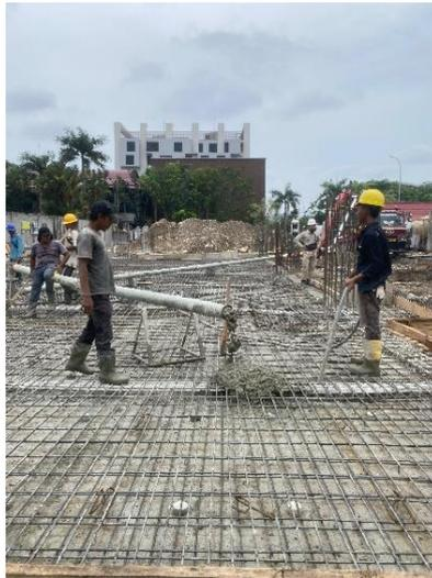
Gambar 3. 40 Pekerjaan pengecoran lantai dasar
