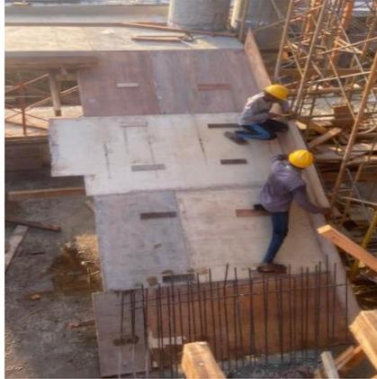
Gambar 3. 61 Pekerjaan bekisting tangga
