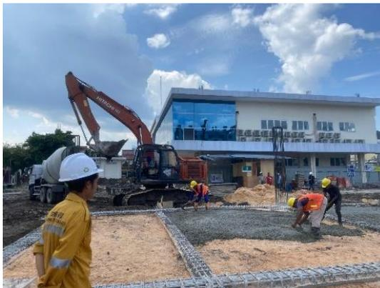
Gambar 3. 38 Pekerjaan Pengecoran lantai kerja
