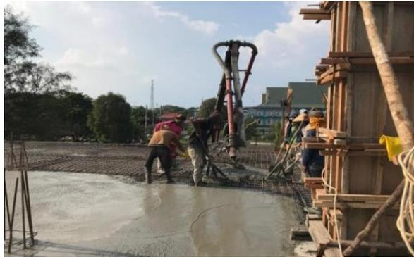
Gambar 3. 57 Pekerjaan pengecoran plat lantai
