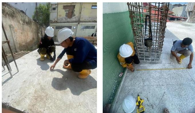
Gambar 3. 42 Pekerjaan marking kolom
