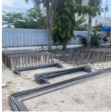
Gambar 3. 18 Perakitan pembersian pile cap
