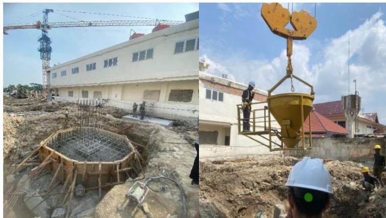
Gambar 3. 25 Pekerjaan pengecoran pile cap
