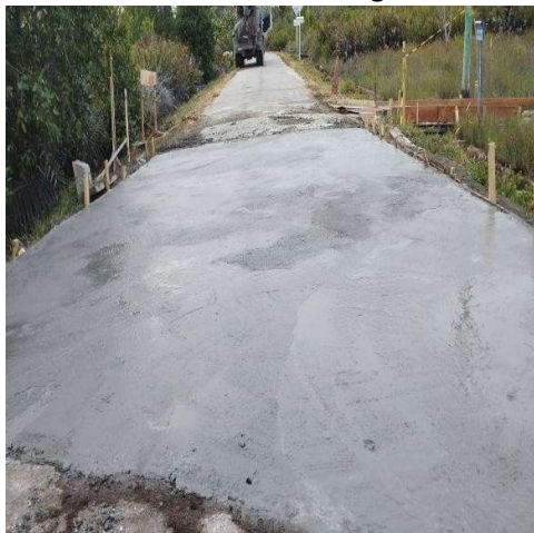
Gambar 3.6 Kondisi setelah di lakukan pengecoran
