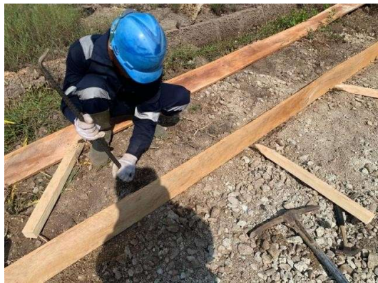
Gambar 3. 3 Pemasangan bekisting
