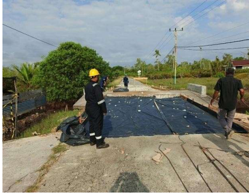
Gambar 3. 5 Kondisi jembatan setelah dilakukan perbaikan
