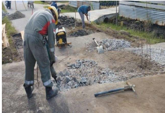
Gambar 3. 2 Proses pembongkaran beton jembatan yang rusak
