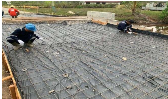
Gambar 3. 4 Pemasangan terpal dan penulangan
