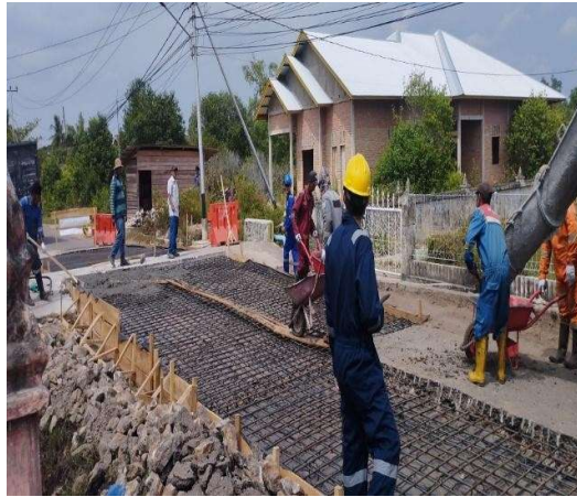
Gambar 3.13 proese pekerjaan pengecoran beton
