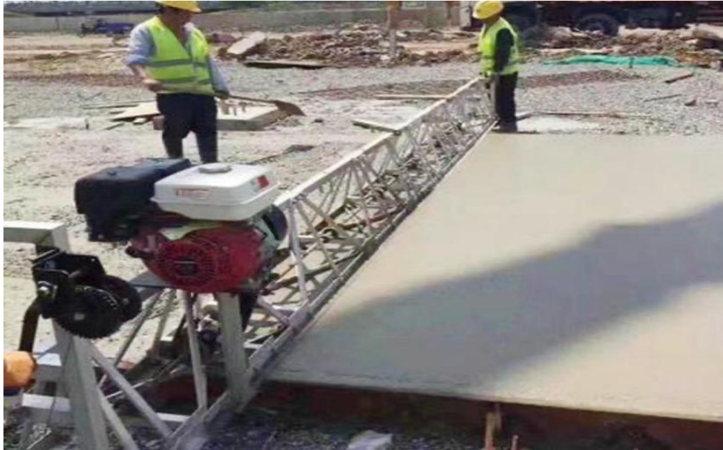
Gambar 3. 8 truss screeder dynamic Sumber: dokumentasi lapangan
