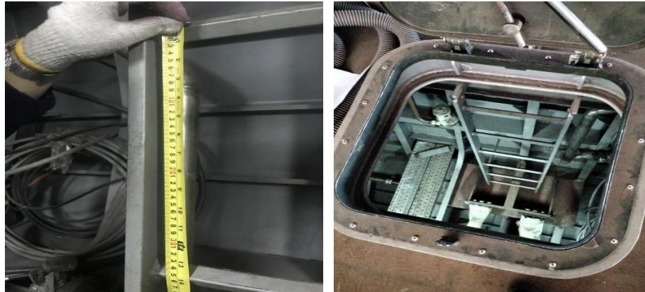
Gambar 3.25 pengukuran tangga di dalam tanki
