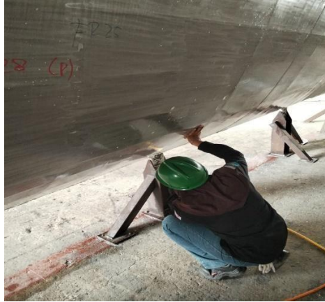
Gambar 3.40 proses air test pada lambung sebelah kiri
