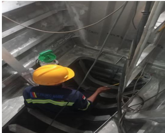
Gambar 3.41 proses air test pada fore peak tank
