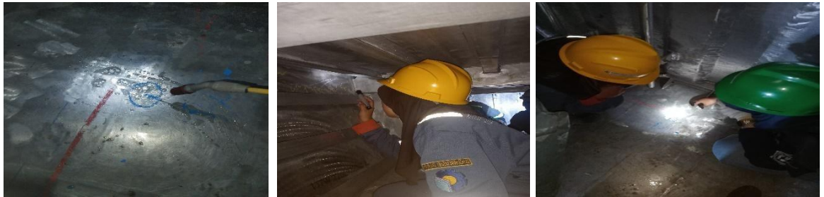
Gambar 3.10 pengecekan air test
