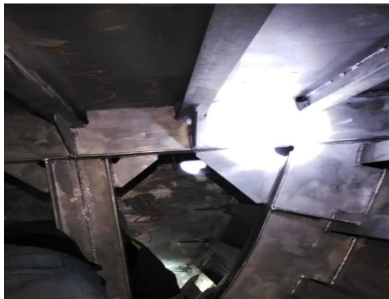
Gambar 3.32 proses inspeksi welding pada void tank
