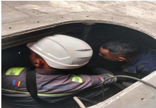
Gambar 3.45 proses pengecekan welding
