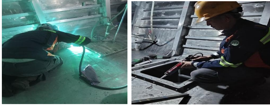
Gambar 3.37 proses inspeksi void tank kanan dan kiri
