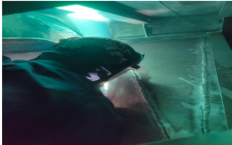
Gambar 3.42 proses welding pada fore peak tank
