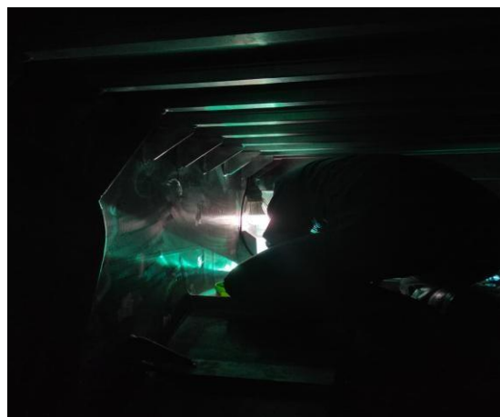
Gambar 3.43 proses welding pada void tank
