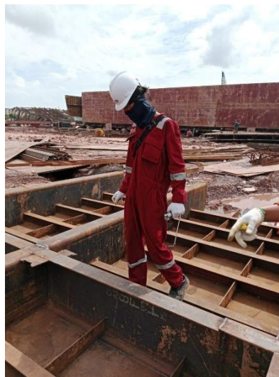
Gambar 3. 9 Visual welding incpection pada penel main deck
