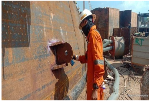
Gambar 3. 27 Liquid Penetrant Test pada kupingan
