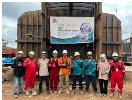
Gambar 3. 51 Keel laying kapal Tug boat.hull 095
