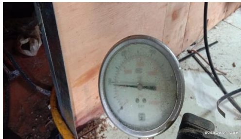
Gambar 4. 15 preasure test pada pengujian hydro test
