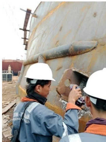
Gambar 3. 2 Liquid penetrant test pada kupingan
