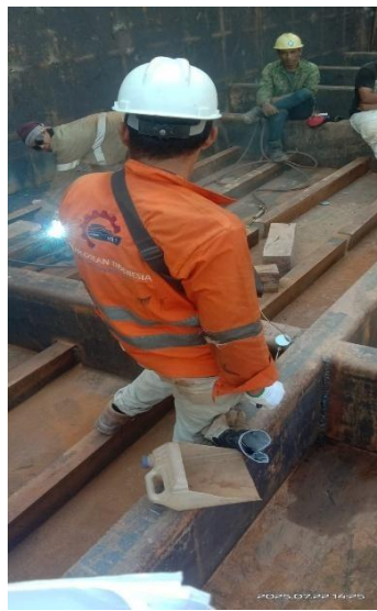
Gambar 3. 16 Visual Inspeksi pada Bottom
