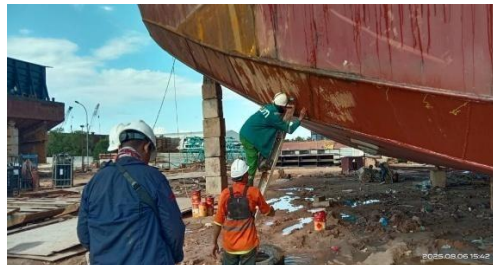
Gambar 3. 41 Air Pressure Test pada tangki fore Peak
