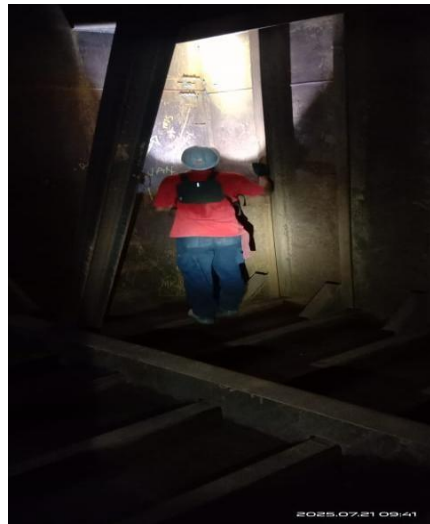
Gambar 3. 13 Visual Inspeksi tangki
