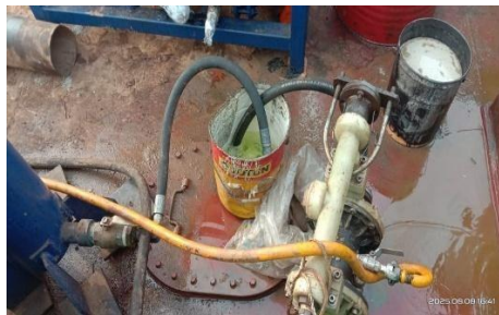
Gambar 4. 17 flushing menggunakan cemical
