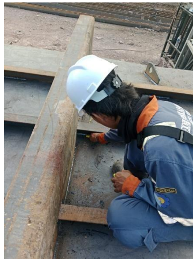
Gambar 3. 12 Welding Inspection pada Long Bulkhead
