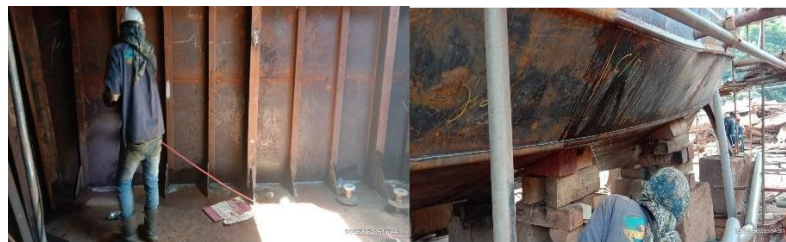
Gambar 3. 38 Air Preasure Test pada tangki Cofferdam
