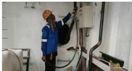
Gambar 4. 19 Air Blow untuk membersihkan kotoran dan air
