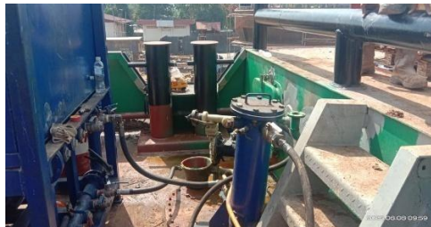
Gambar 3. 44 proses Flushing pada pipa Hidrolik
