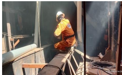
Gambar 3. 56 monitoring progress pada engine girder
