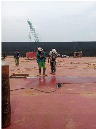
Gambar 3. 61 Air Pressure Test pada kapal tongkang
