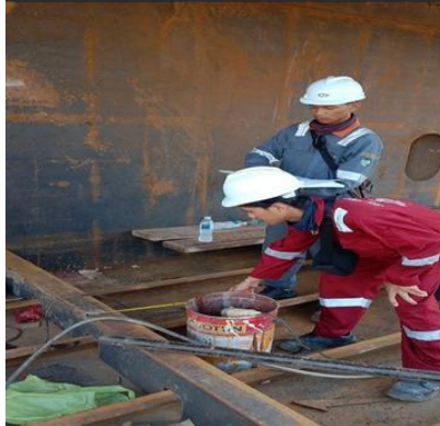
Gambar 3. 5 Scantling Check pada Kontruksi Main Deck
