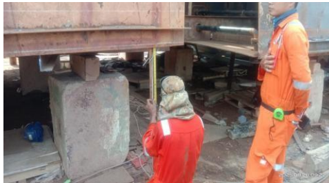
Gambar 3. 62 Levelling pada area Raise Deck
