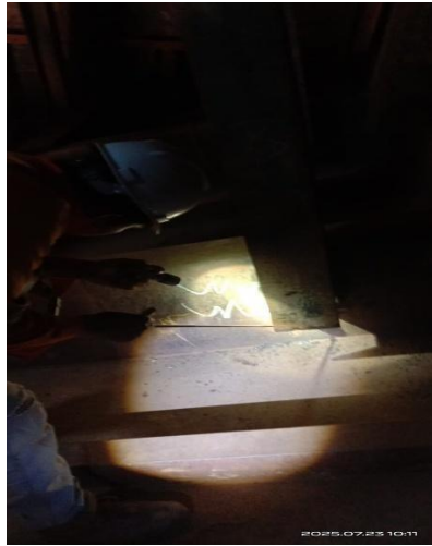
Gambar 3. 17 kondisi tangki ceruk bagian Portside
