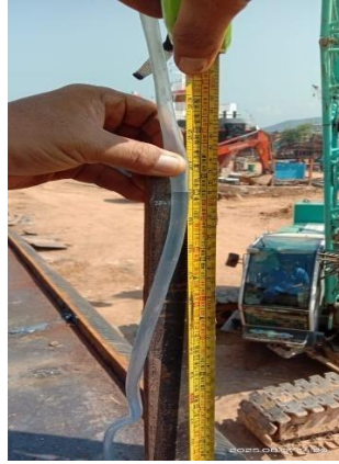
Gambar 3. 43 Leveling pada Main Deck
