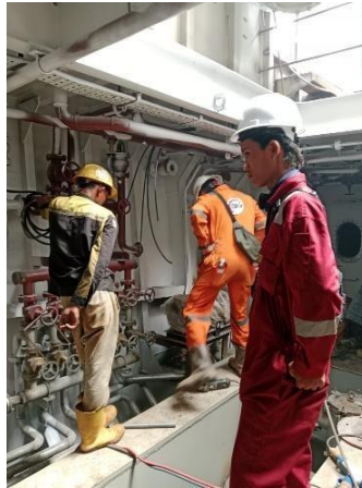
Gambar 3. 8 Hydro Test pada Bilga dan Ballast
