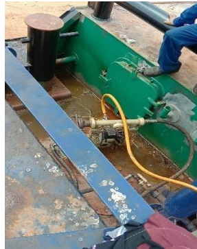
Gambar 4. 18 flushing menggunakan soda
