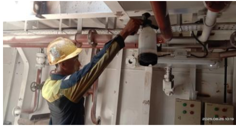
Gambar 3. 59 Air Preasure Test pada pipa
