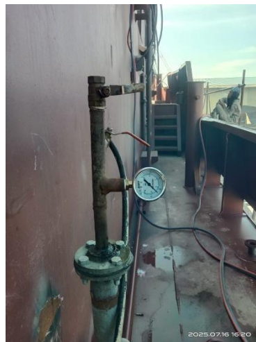
Gambar 3. 6 Pressure Gauge pada pengujian hydrotest
