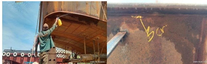
Gambar 3. 58 Air Pressure Test pada ballast tank
