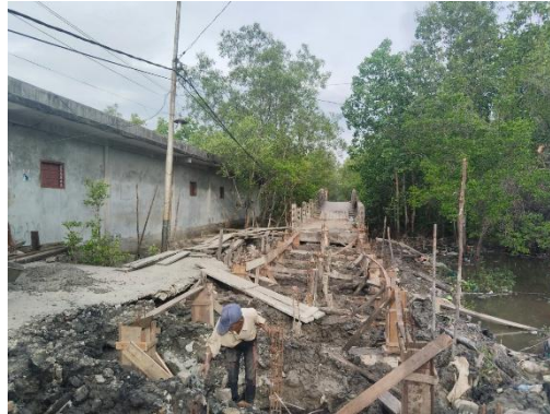
Gambar 3. 70 Pekerjaan pembuatan cetakan kolom Sumber: Dokumentasi Lapangan
