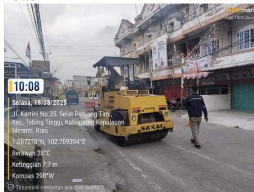
Gambar 3. 85 Tandem Roller Sumber: Dokumentasi Lapangan
