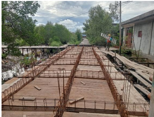
Gambar 3. 75 Pekerjaan pemasangan tulangan balok
