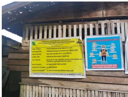
Gambar 3. 37 Papan Proyek Sumber: Dokumentasi Lapangan
