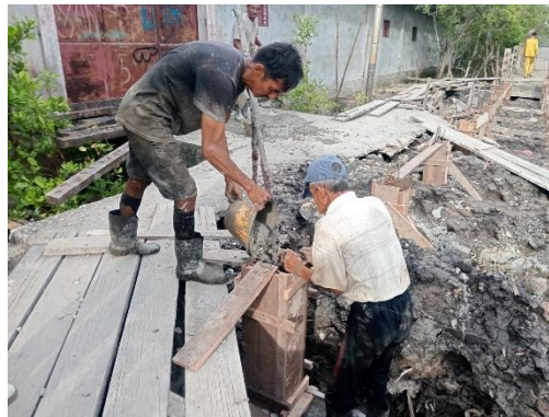
Gambar 3. 71 Pekerjaan pengecoran kolom Sumber: Dokumentasi Lapangan
