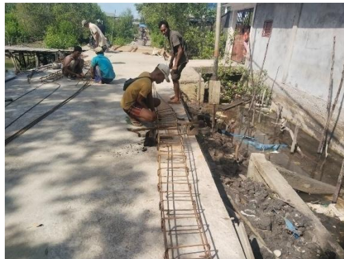
Gambar 3. 53 Tulangan baja berdiameter 8 mm dan 10 mm
