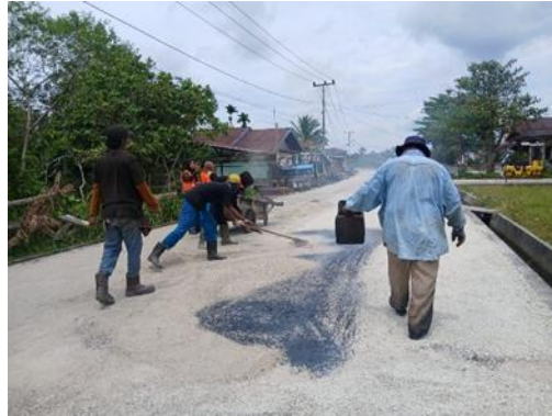
Gambar 3. 35 Penghamparan agregat halus Sumber: Dokumentasi Lapangan
