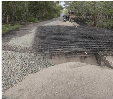
Gambar 3. 63 Pekerjaan penyiapan material
