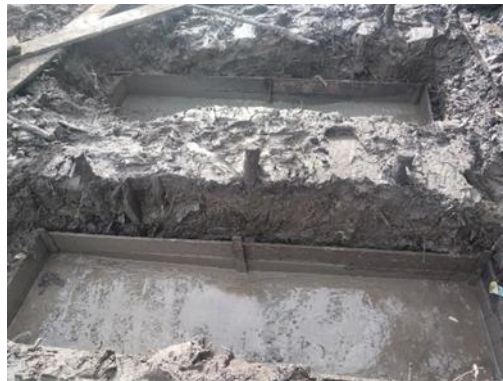
Gambar 3. 67 Pekerjaan pengecoran lantai kerja (LC) pada dasar pondasi
