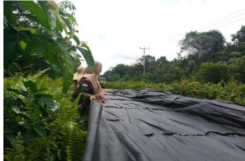
Gambar 3. 11 Pekerjaan Pemasangan Geotextil Sumber : Dokumentasi Lapangan
