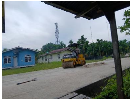
Gambar 3. 36 Penggilasan agregat halus Sumber: Dokumentasi Lapangan
