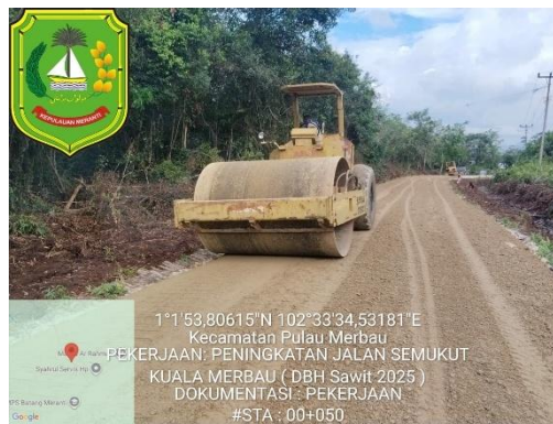
Gambar 3. 14 Pemadatan Agregat Quarry Waste
