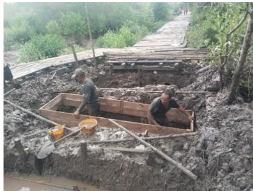
Gambar 3. 65 Pekerjaan pemasangan cetakan pondasi
