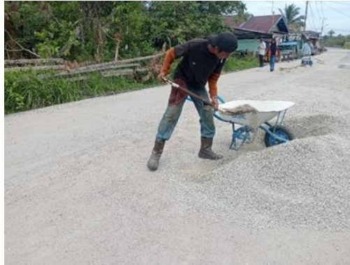
Gambar 3. 29 Mobilisasi material Sumber: Dokumentasi Lapangan
