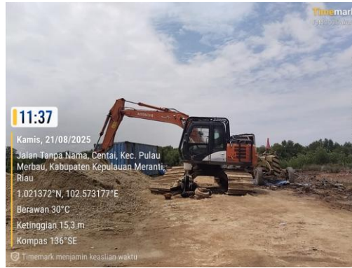
Gambar 3. 5 Exavator Sumber : Dokumentasi Lapangan
