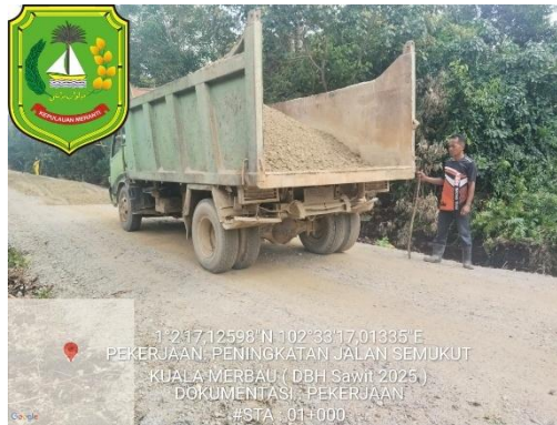
Gambar 3. 12 Mobilisasi Material Agregat Quarry Waste Sumber : Dokumentasi Lapangan
