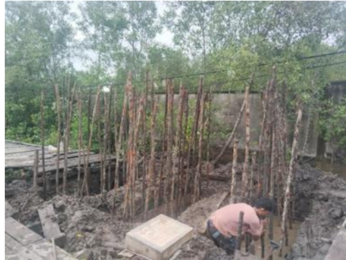
Gambar 3. 66 Pekerjaan pemasangan cerucuk
