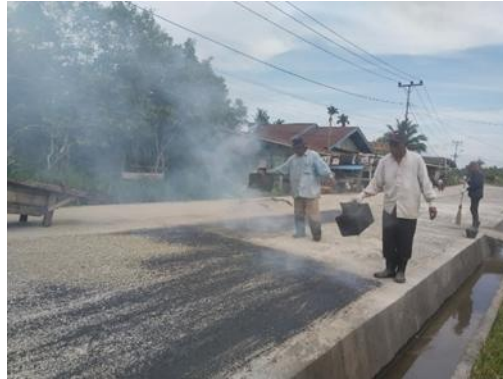
Gambar 3. 31 Pekerjaan penyiraman aspal
