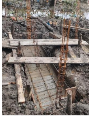
Gambar 3. 68 Pekerjaan pemasangan tulangan pondasi Sumber: Dokumentasi Lapangan
