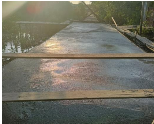
Gambar 3. 79 Pekerjaan pengecoran plat lantai
