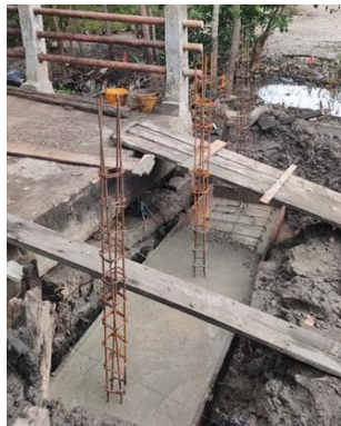
Gambar 3. 69 Pekerjaan pengecoran pondasi Sumber: Dokumentasi Lapangan
