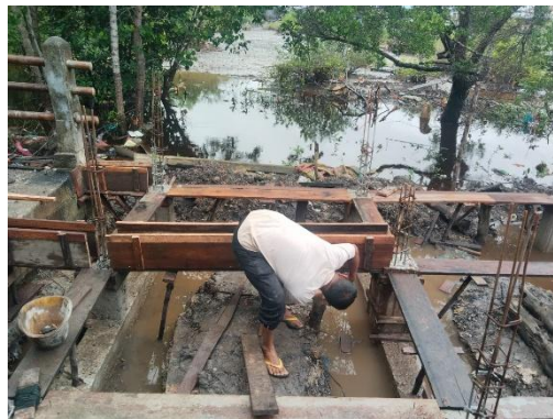
Gambar 3. 73 Pekerjaan pembuatan cetakan balok Sumber: Dokumentasi Lapangan
