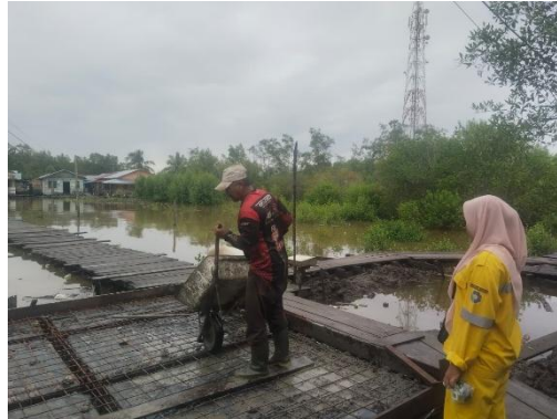
Gambar 3. 78 Pekerjaan pengecoran balok
