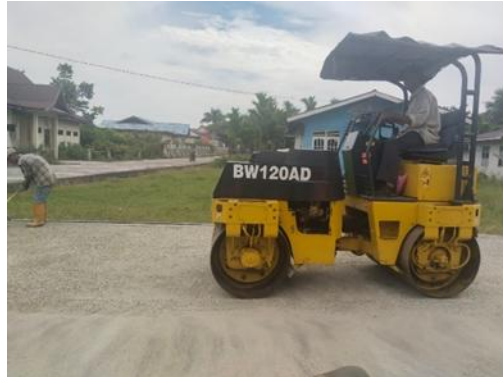
Gambar 3. 33 Pekerjaan pemadatan
