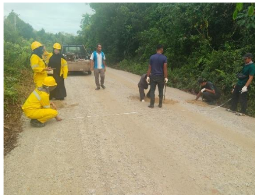
Gambar 3. 15 Pekerjaan Core Drill Sumber: Dokumentasi Lapangan
