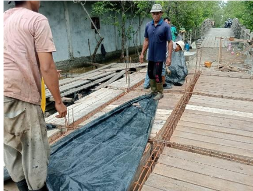
Gambar 3. 76 Pekerjaan pemasangan plastik cor Sumber: Dokumentasi Lapangan
