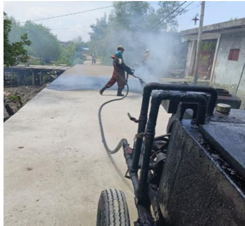
Gambar 3. 80 Pekerjaan pemyemprotan aspal cair Sumber: Dokumentasi Lapangan
