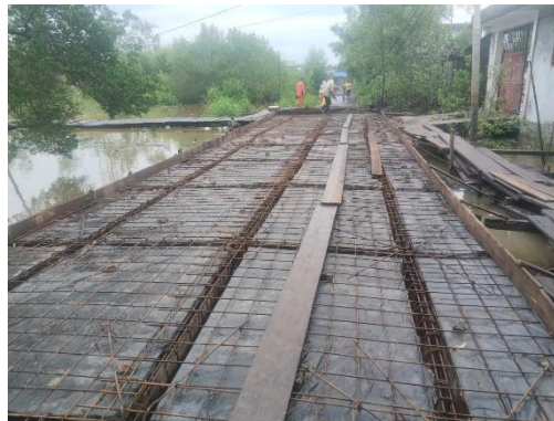
Gambar 3. 77 Pekerjaan pemasangan wire mash Sumber: Dokumentasi Lapangan
