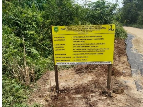
Gambar 3. 3 Papan Proyek Sumber : Dokumentasi Lapangan
