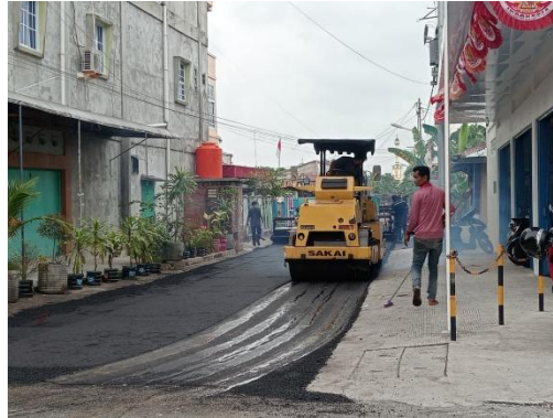
Gambar 3. 91 Pemasatan lapisan aspal AC-WC menggunakan tandem roller
