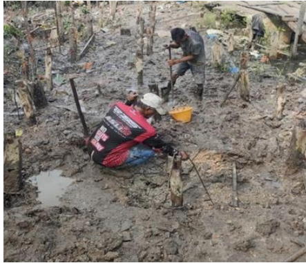
Gambar 3. 62 Pekerjaan persiapan dan pembersihan lahan
