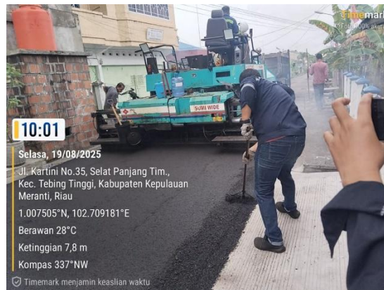
Gambar 3. 90 Penghamparan campuran aspal menggunakan aspal finisher
