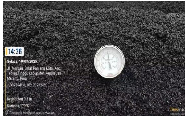
Gambar 3. 89 Pengecekan Suhu Campuran Aspal Menggunakan Termometer
