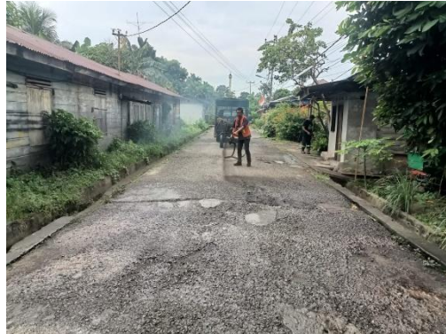
Gambar 3. 87 penyiraman lapisan Tack Coat Sumber: Dokumentasi Lapangan
