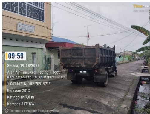
Gambar 3. 88 Mobilisasi Aspal Dari Asphalt Mixing Plant (AMP) Sumber: Dokumentasi Lapangan
