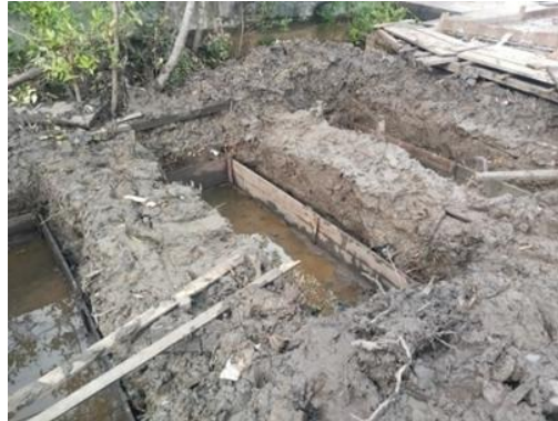
Gambar 3. 64 Pekerjaan Penggalian pondasi
