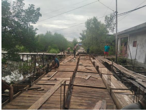
Gambar 3. 74 Pekerjaan pembuatan cetakan plat lantai
