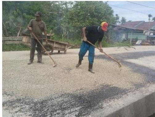
Gambar 3. 32 Pekerjaan pengambaran agregat kasar atau krikil 1/2 dan 3/8
