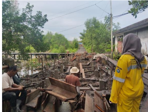
Gambar 3. 72 Pekerjaan pembongkaran cetakan kolom Sumber: Dokumentasi Lapangan
