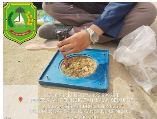
Gambar 3. 16 Pekerjaan Pengujian Sand Cone Sumber: Dokumentasi Lapangan
