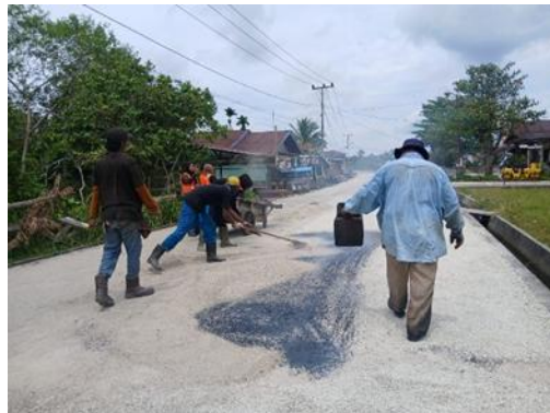
Gambar 3. 34 Pekerjaan penyiraman aspal Lapisan Kedua
