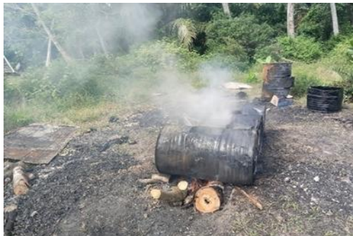
Gambar 3. 30 Pekerjaan pemanasan Aspal Sumber: Dokumentasi Lapangan
