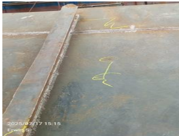
Gambar 3. 12 Welding Inspect Pada Erection Kepingan Pop Deck
