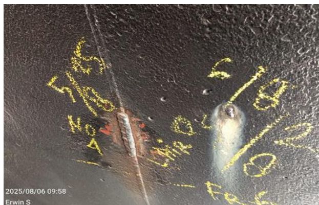
Gambar 3. 35 Inspect Kebocoran Lambung Kapal Lintas Bahari Secara Visual
