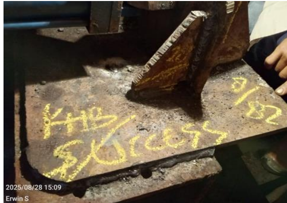
Gambar 3. 60 Monitoring dan Visual Weld bracket
