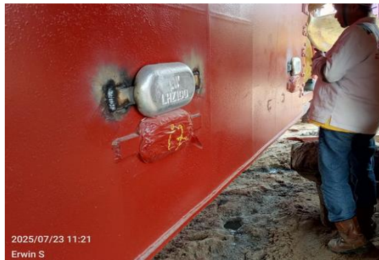
Gambar 3. 8 Monitoring Dan Visual Weld Zink Anode
