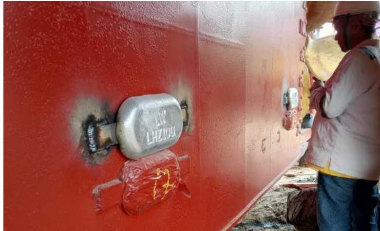
Gambar 3. 18 Monitoring Dan Visual Weld Zink Anode
