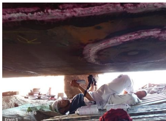
Gambar 3. 37 Penetran Pada Bottom Lintas Bahari
