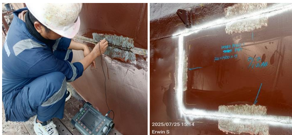
Gambar 3. 21 UT Pada Welding Replating Oleh Class Rina
