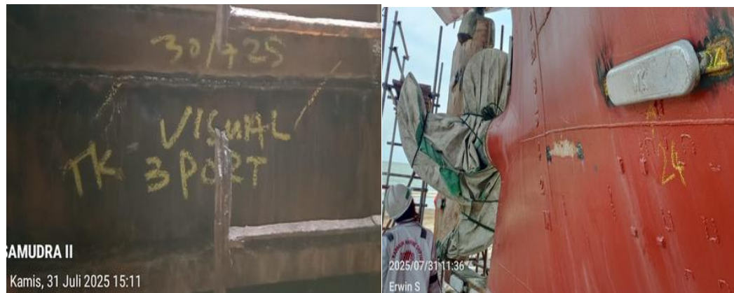
Gambar 3. 27 Monitoring Kebocoran Lambung dan Inspect Visual
