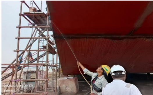
Gambar 3. 30 Uji Kebocoran Metode Air Test Pada Tongkang Samudra II
