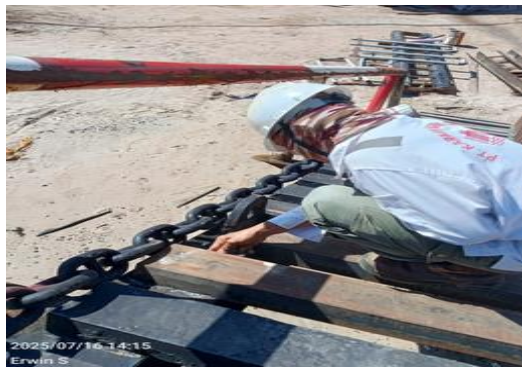
Gambar 3. 5 Welding Inspect Pada Ramdoor
