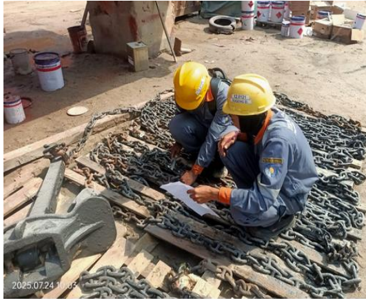
Gambar 3. 19 Pengukuran Rantai Jangkarn Ghanda
