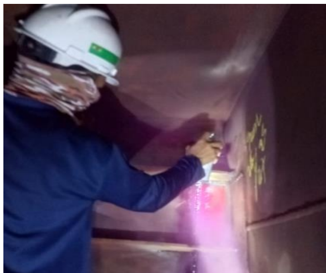
Gambar 3. 22 Uji Kebocoran Metode penetran test
