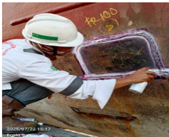
Gambar 3. 15 Penetran Pada Side Shell Lintas Bahari
