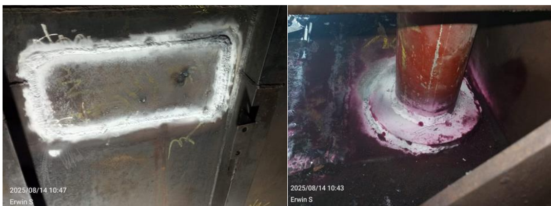
Gambar 3. 43 Penetran Test Lintas Bahari
