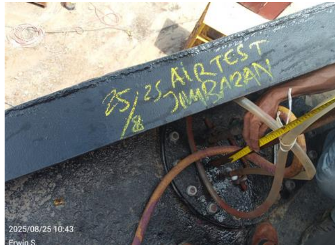
Gambar 3. 53 Uji Kebocoran Air Test Pada Jmbaran
