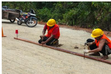
Gambar 3.17 Pemasangan Bekisting Lc Sumber : Dokumentasi Lapangan 2025
