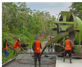
Gambar 3.24 Pengecoran Rigid Sumber : Dokumentasi Lapangan 2025
