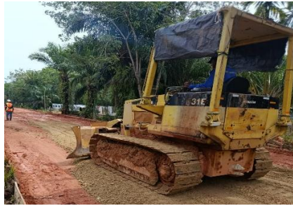
Gambar 2.9 Bulldozer Sumber : Dokumentasi Lapangan 2025
