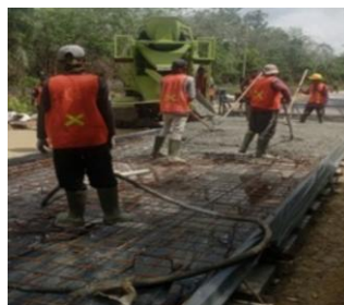
Gambar 3.26 Pengecoran Rigid Sumber : Dokumentasi Lapangan 2025
