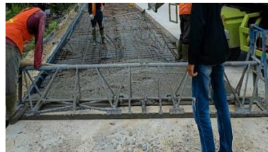
Gambar 2.15 Truss Screeder Dynamic Sumber : Dokumentasi Lapangan 2025
