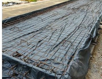
Gambar 3.21 Pemasangan Tulangan Dowel & Dudukan Wiremesh Sumber : Dokumentasi Lapangan 2025
