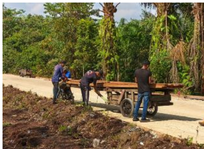
Gambar 3.5 Pemasangan papan mal Sumber : Dokumentasi Lapangan 2025
