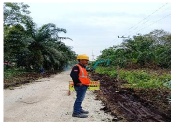
Gambar 3.4 Pembersihan lahan Sumber : Dokumentasi Lapangan 2025
