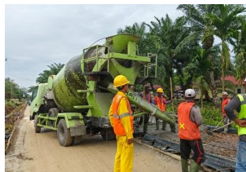
Gambar 2.13 Truck Mixer Sumber : Dokumentasi Lapangan 2025
