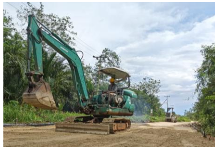
Gambar 2.8 Excavator Sumber : Dokumentasi Lapangan 2025
