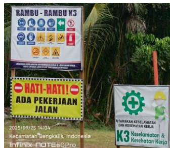
Gambar 3.3 Rambu Keselamatan Sumber : Dokumentasi Lapangan 2025
