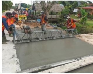
Gambar 3.27 meratakan permukaan beton Sumber : Dokumentasi Lapangan 2025
