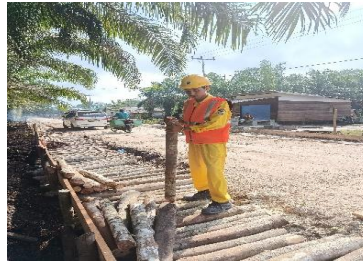
Gambar 3.7 Pemasangan kayu gambangan Sumber : Dokumentasi Lapangan 2025
