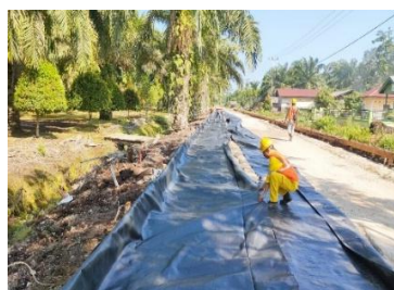
Gambar 3.7 Pemasangan Geotex Sumber : Dokumentasi Lapangan 2025
