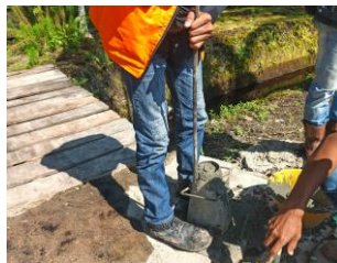
Gambar 3.25 Pengujian slump Sumber : Dokumentasi Lapangan 2025
