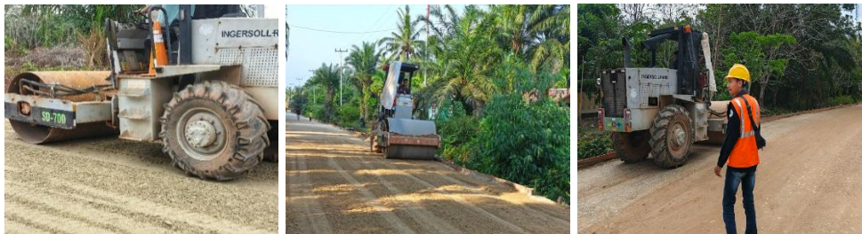
Gambar 4.4 Pemadatan Base B (Sumber: Dokumentasi Lapangan 2025)
