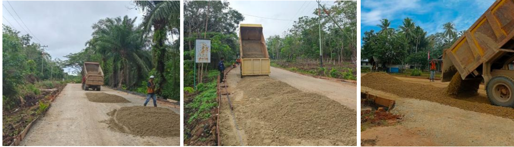
Gambar 4.2 Penghamparan Base B (Sumber: Dokumentasi Lapangan 2025)
