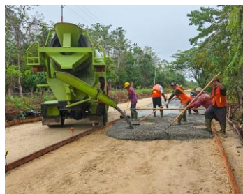
Gambar 3.19 Pengecoran Lc Sumber : Dokumentasi Lapangan 2025
