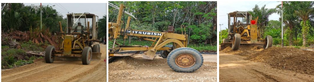
Gambar 4.3 Maratakan Material (Sumber: Dokumentasi Lapangan 2025)
