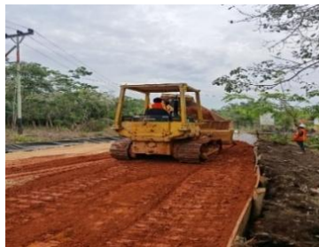
Gambar 3.8 Penghamparan Tanah Urugan Sumber : Dokumentasi Lapangan 2025
