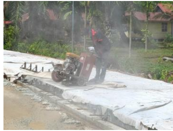
Gambar 3.30 Cutting Sumber : Dokumentasi Lapangan 2025
