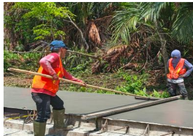
Gambar 3.28 Pekerjaan Grooving Sumber : Dokumentasi Lapangan 2025
