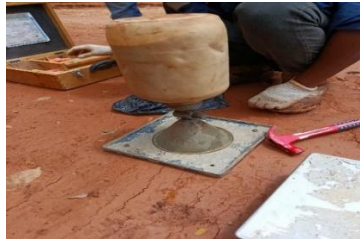
Gambar 3.11 Pengujian Sand Cone Tanah Timbunan Sumber : Dokumentasi Lapangan 2025
