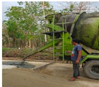
Gambar 3.18 Pengecoran Lc Sumber : Dokumentasi Lapangan 2025
