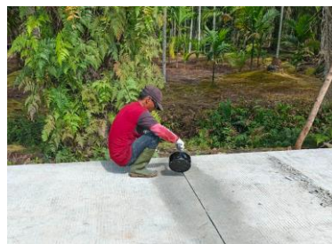
Gambar 3.31 Joint Sealnt Sumber : Dokumentasi Lapangan 2025
