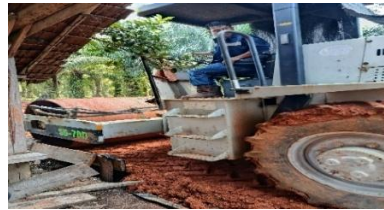
Gambar 3.9 Penghamparan Tanah Urugan Sumber : Dokumentasi Lapangan 2025
