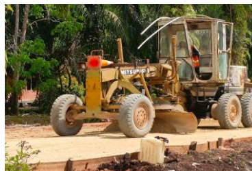
Gambar 3.12 Penghamparan dan Perataan Base B Sumber : Dokumentasi Lapangan 2025
