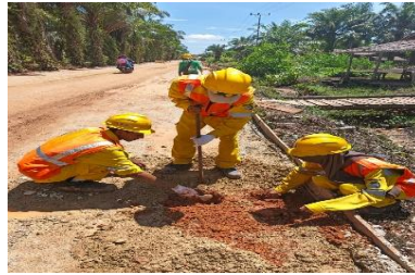
Gambar 3.10 Pengujian Core Drill Tanah Sumber : Dokumentasi Lapangan 2025
