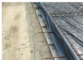
Gambar 3.22 Pemasangan Tie bar Sumber : Dokumentasi Lapangan 2025
