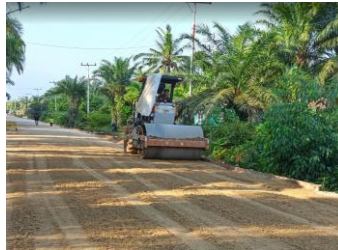
Gambar 3.13 Pemadatan Base B Sumber : Dokumentasi Lapangan 2025
