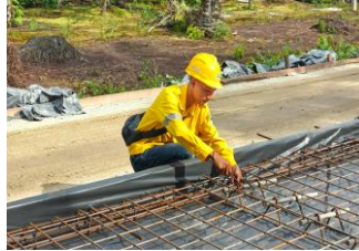
Gambar 3.23 Pengikatan Besi Tulangan Sumber : Dokumentasi Lapangan 2025
