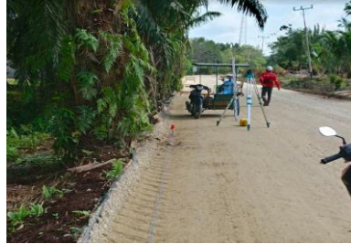
Gambar 3.16 Pemasangan Patok Mal Sumber : Dokumentasi Lapangan 2025
