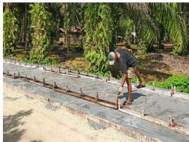
Gambar 3.20 Pemasangan Bekisting Rigid Sumber : Dokumentasi Lapangan 2025
