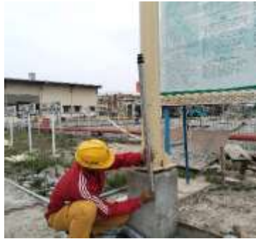
Gambar 82 Proses Top Level ffl +500 dan
