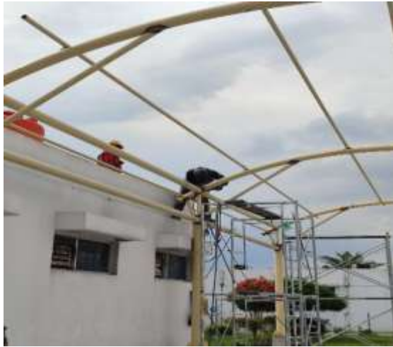
Gambar 99 Pekerjaan Pemasangan Pipa Tebim 4''
