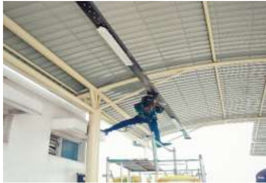
Gambar 120 Pekerjaan Pemasangan Kabel Tray Di Shelter Security
