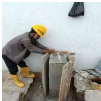
Gambar 56 Proses Pembukaan Bekisting Kolom
