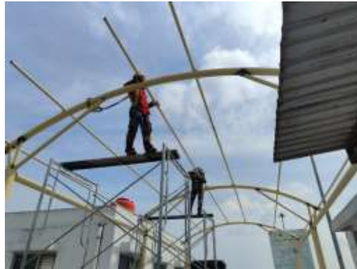
Gambar 93 Peroses Pemasangan Ring Seng
