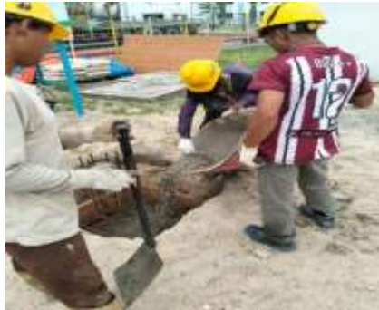
Gambar 25 Proses Pengecoran Tapak Pondasi
