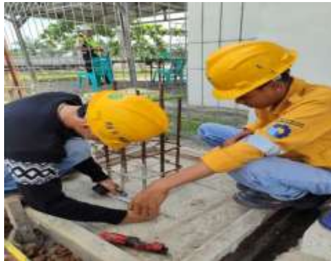
Gambar 35 Makingudukan bekisting
