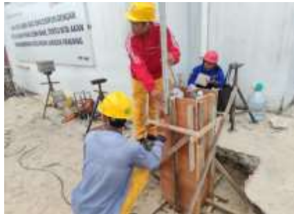
Gambar 44 Proses Leveling Dan Pemasangan Kolom
