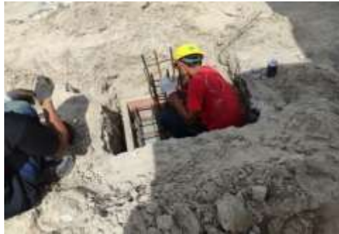
Gambar 21 Proses Memasang Tulangan Pondasi
