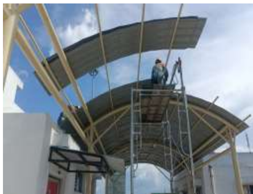
Gambar 111 Pekerjaan Pemasangan Seng Di Shalter Securi
