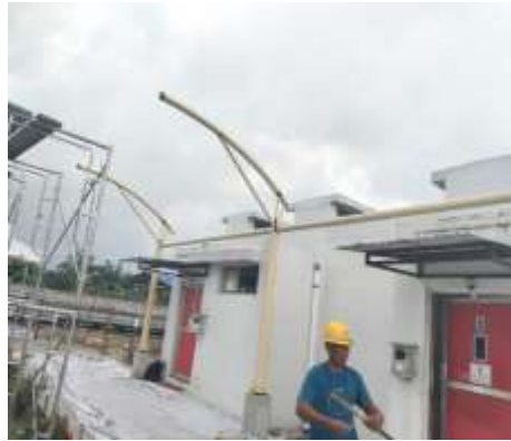
Gambar 86 Proses Pemasangan Besi Tulangan Supolt
