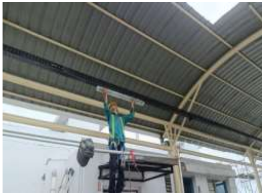
Gambar 121 Pekerjaan Pemasangan Lampu Di Shelter Securi
