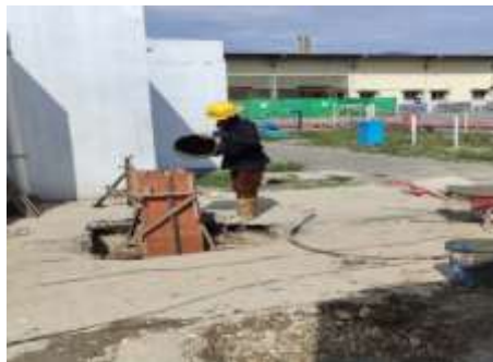
Gambar 48 Proses Pengaliran Tapak Gajah
