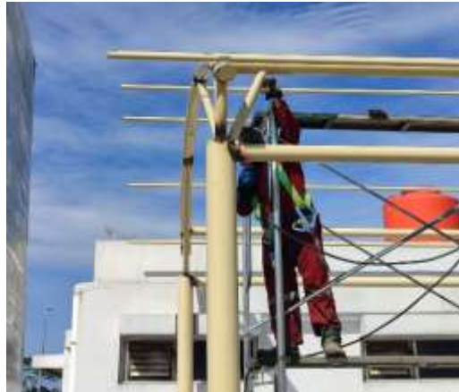
Gambar 105 Pekerjaan Pemasangan Tapor Shalter Security
