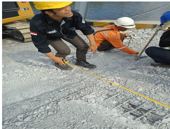
Gambar 3.6 Pengukuran Pembongkaran lantai jembatan ( Sumber : Dokumentasi Kerja Praktek 2024 ).
