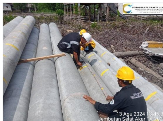
Gambar 3.8 Pengukuran dan diberi angka tiang pancang spun pile
