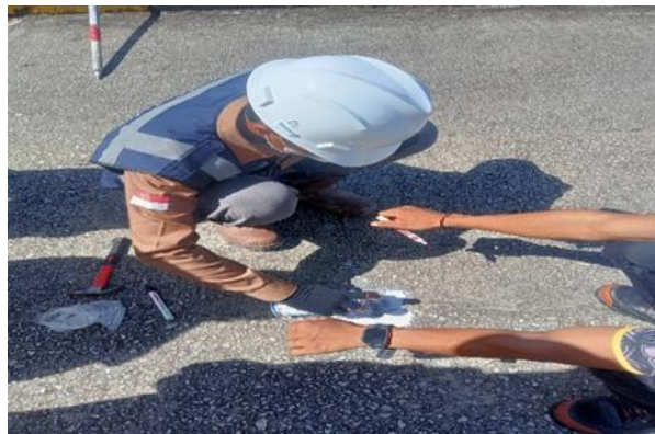
Gambar 3 . 3 Stake out menggunakan cat semprot
