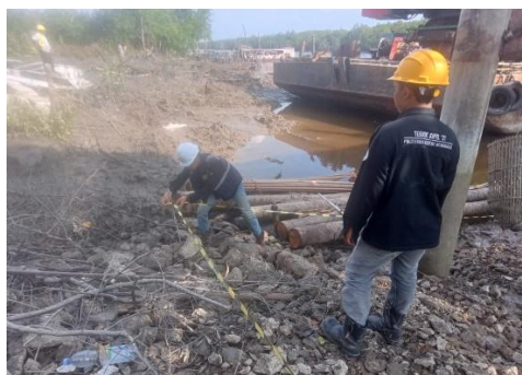
Gambar 3.7 Pengukuran elevasi tiang pancang
