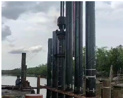
Gambar 4.7 Proses Pemukulan Tiang Pancang
