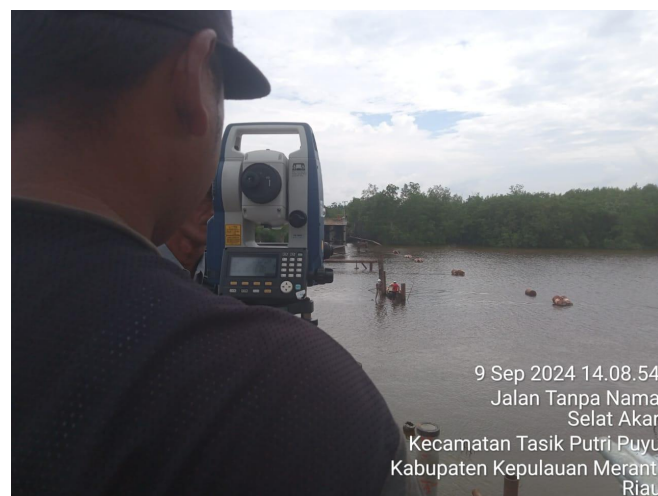
Gambar 4.2 Survey elevasi pemancangan baja (Sumber : Dokumentasi Lapangan 2024)
