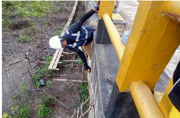
Gambar 3.5 Pengukuran pier head ( Sumber : Dokumentasi Kerja Praktek 2024 ).
