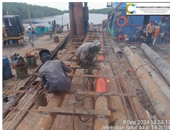
Gambar 4.6 Pemasangan Scaffolding
