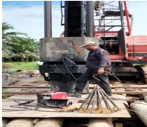
Gambar 4.4 Pemasangan Hammer Ke Crane (Dokumentasi Lapangan 2024)
