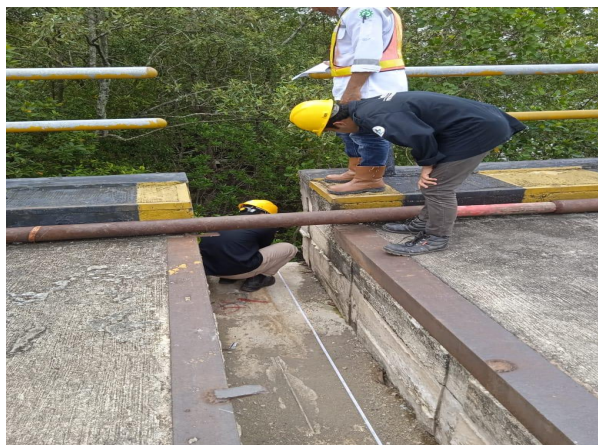
Gambar 3.4 Pengukuran lebar lantai jembatan (Sumber: Dokumentasi Kerja Praktek 2024)
