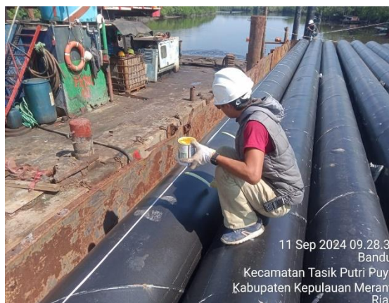
Gambar 4.5 Proses Pemberian Tanda Ukuran Tiang Pancang (Dokumentasi Lapangan 2024)
