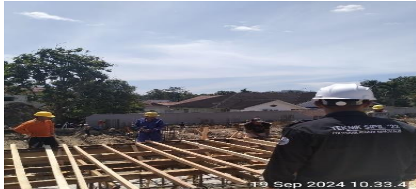
Gambar 3. 51 Pekerjaan pemasangan prancah
