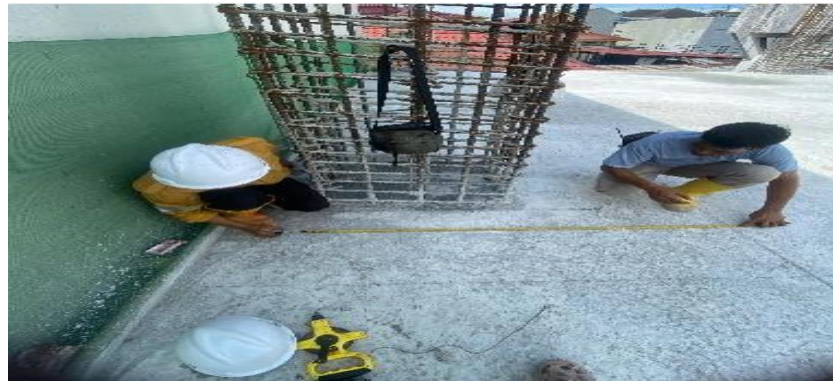
Gambar 3. 39 Pekerjaan marking kolom
