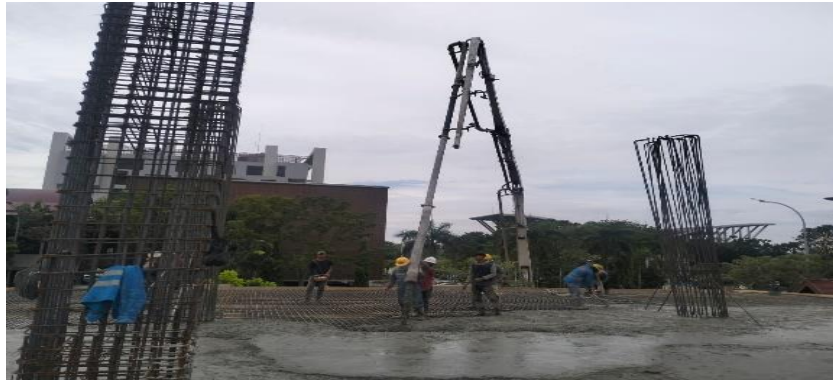
Gambar 3. 54 Pekerjaan pengecoran balok dan plat lantai
