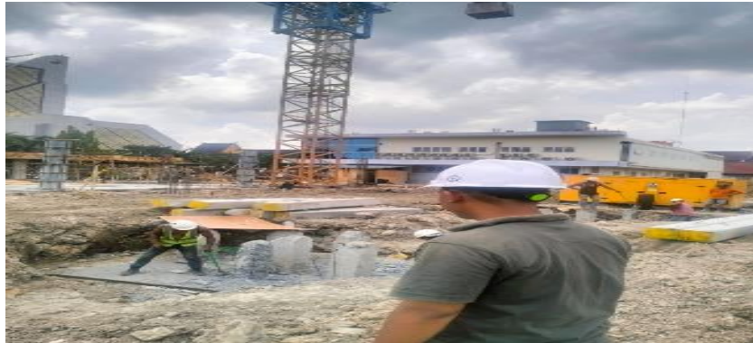
Gambar 3. 18 Pekerjaan cutting pile
