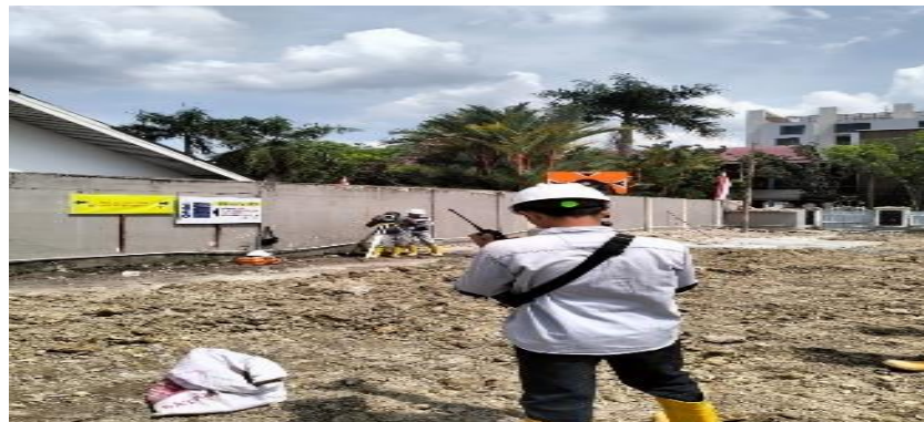
Gambar 3. 15 Pekerjaan Pematokan Titik Tiang pancang
