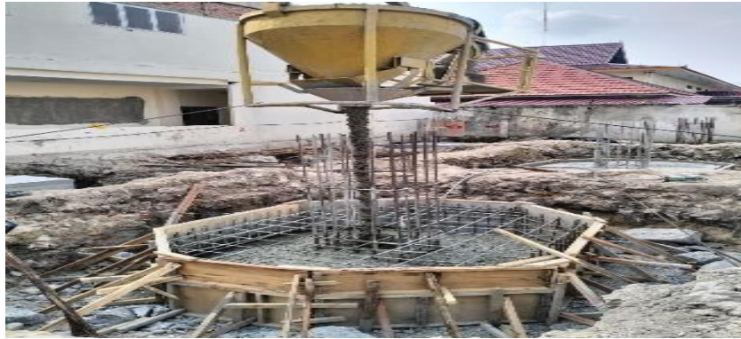
Gambar 3. 21 Pekerjaan pengecoran pile cap
