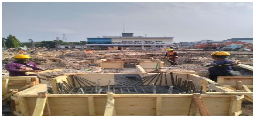
Gambar 3. 20 Pekerjaan bekisting pile cap
