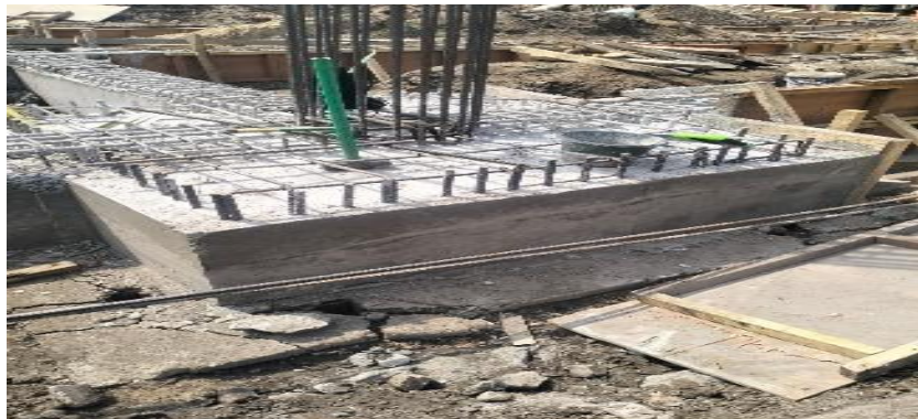
Gambar 3. 22 Pekerjaan pembongkaran bekisting
