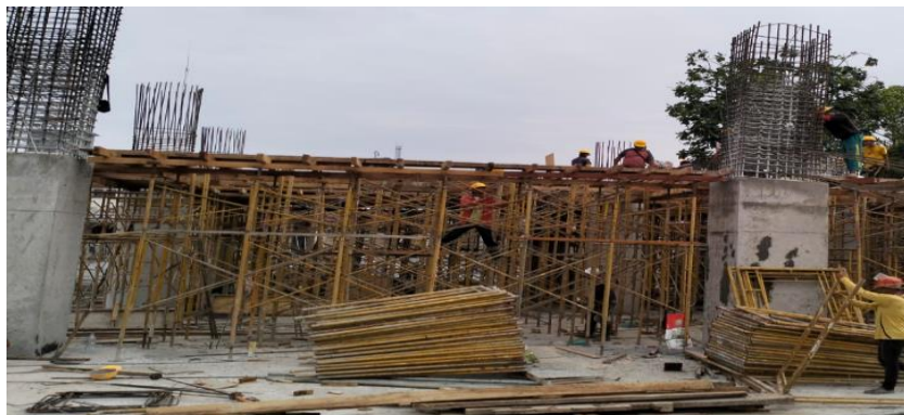
Gambar 3. 46 Pekerjaan Pemasangan Scaffolding
