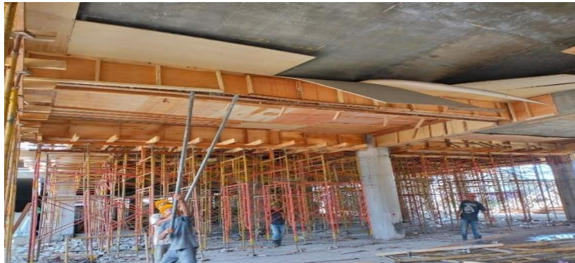
Gambar 3. 50 Pekerjaan pembongkaran bekisting Balok dan plat lantai
