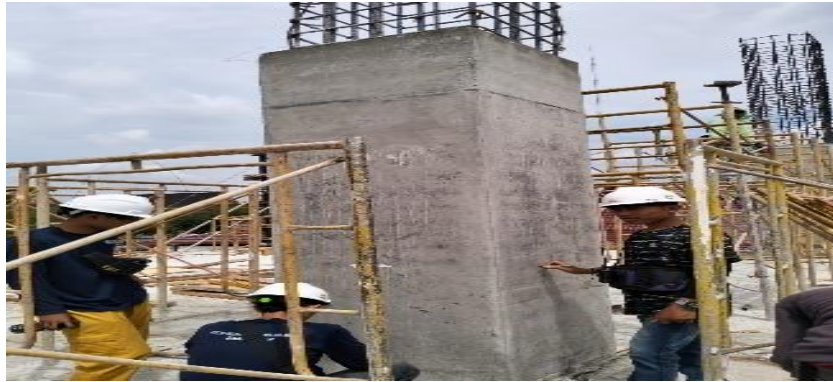
Gambar 3. 45 Pekerjaan Satu Meter Kolom
