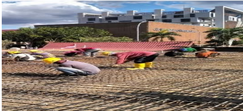
Gambar 3. 53 Pekerjaan penulangan plat lantai
