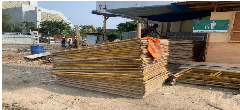
Gambar 3. 93 Scaffolding (Sumber : Dokumentasi Lapangan)
