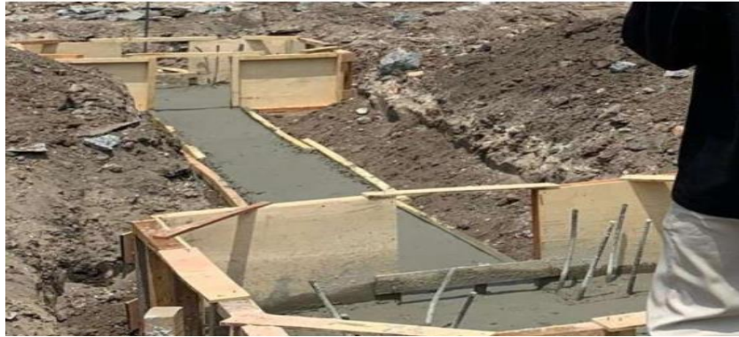
Gambar 3. 27 Pekerjaan Lantai Kerja Sloof
