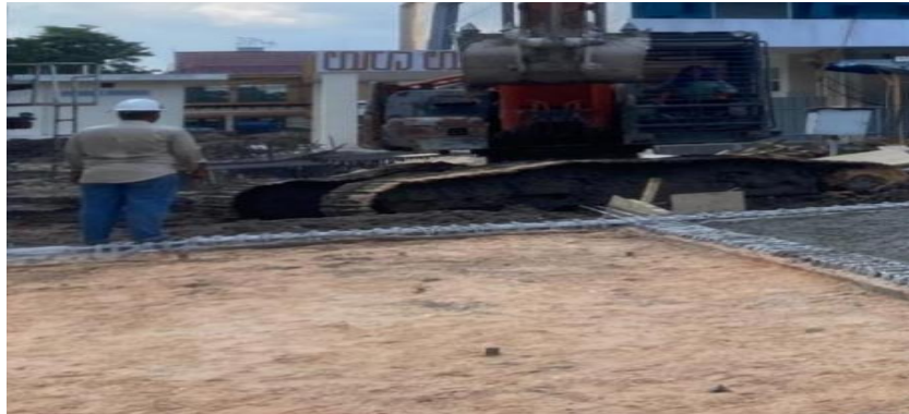
Gambar 3. 33 Pekerjaan urung pasir
