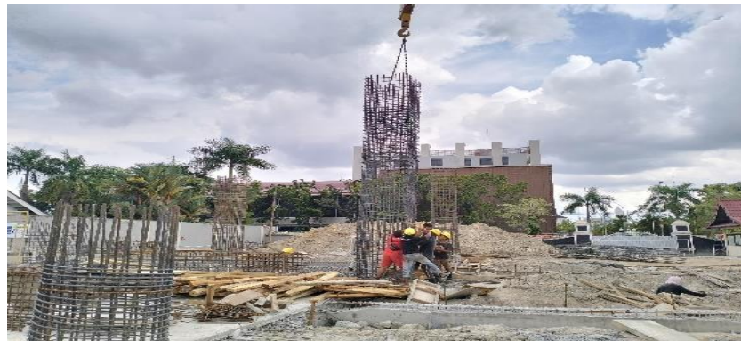
Gambar 3. 40 Pekerjaan Tulangan Kolom
