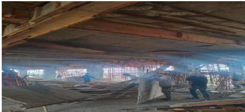
Gambar 3. 55 Pekerjaan pembongkaran bekisting Balok dan plat lantai
