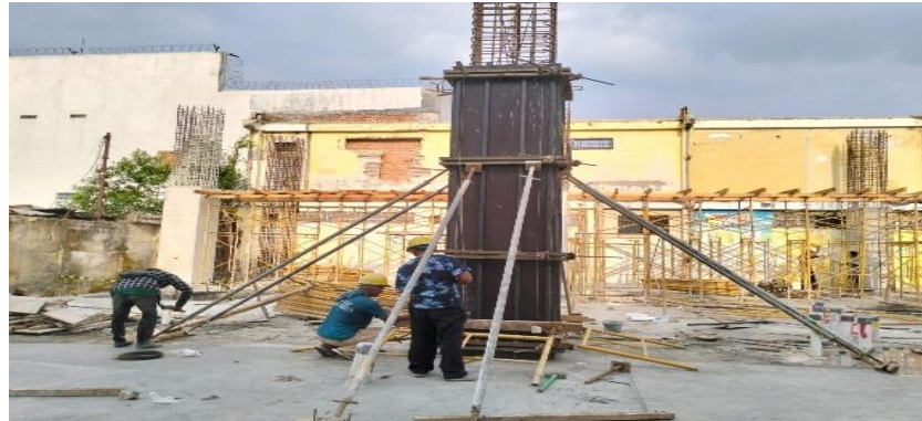
Gambar 3. 41 Pekerjaan Bekisting Kolom
