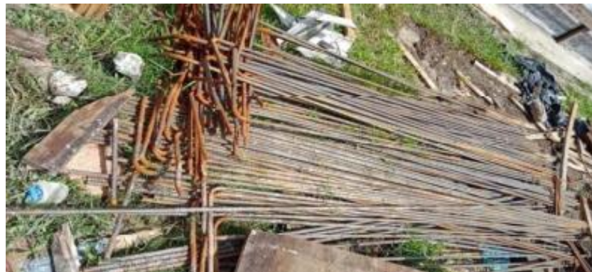
Gambar 3. 23 Pabrikasi besi kolom pedestal
