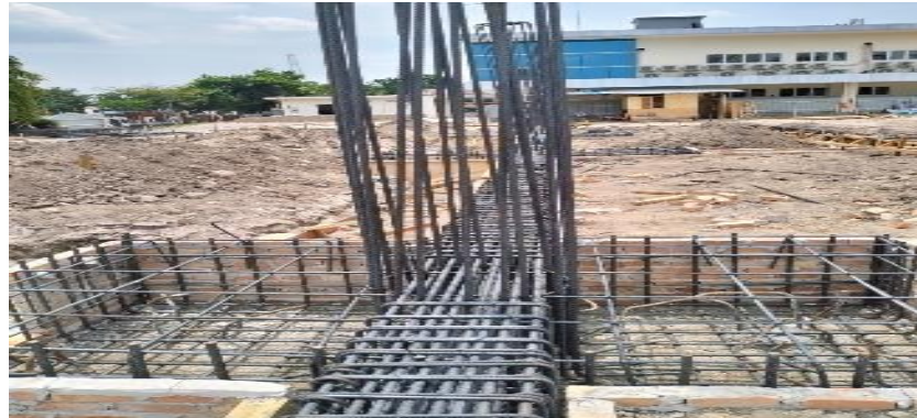
Gambar 3. 24 Pekerjaan kolom pedestal dan pile cap
