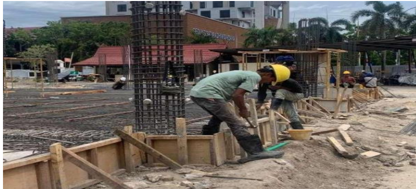
Gambar 3. 31 Pekerjaan Pembongkaran Bekisting Sloof
