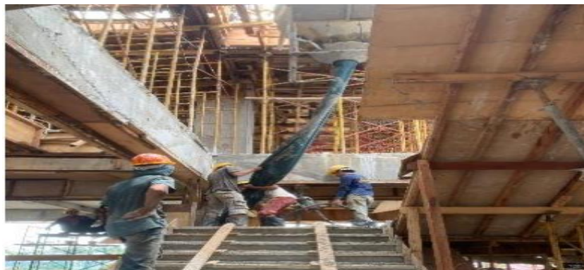
Gambar 3. 61 Pekerjaan Pengecoran
