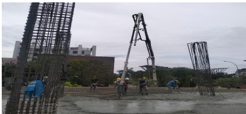
Gambar 3. 49 Pekerjaan pengecoran balok dan plat lantai
