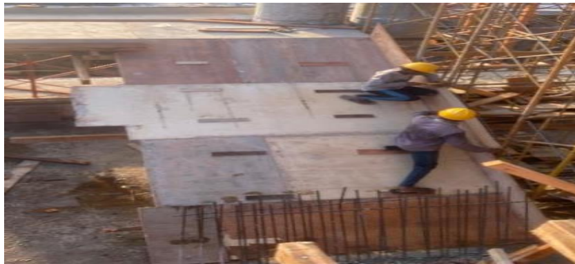
Gambar 3. 58 Pekerjaan bekisting tangga
