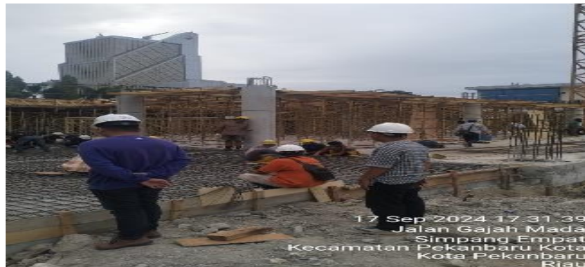
Gambar 3. 35 Pekerjaan Pembesian Lantai Dasar
