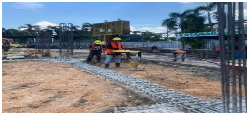
Gambar 3. 32 Pekerjaan Pemadatan Tanah
