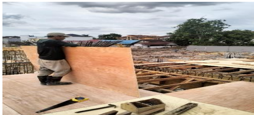
Gambar 3. 52 Pekerjaan pemasangan bekisting
