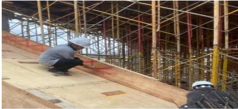
Gambar 3. 59 Pekerjaan marking tangga
