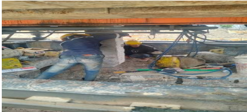
Gambar 3. 16 pemancangan tiang pancang
