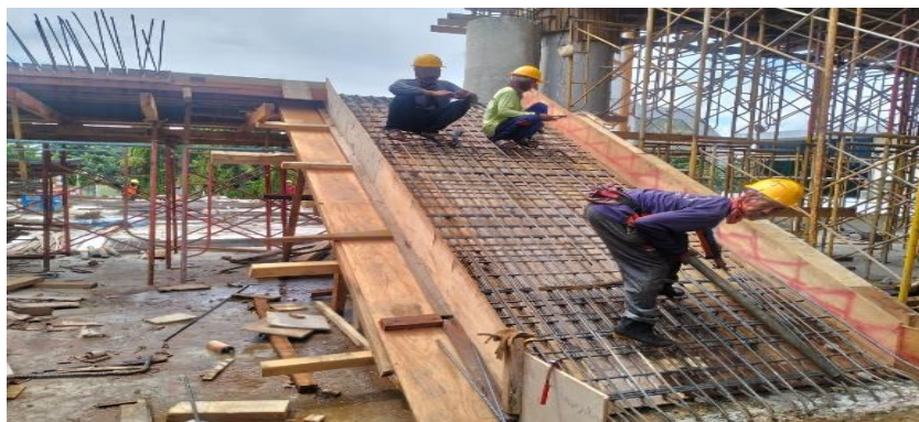
Gambar 3. 60 Pekerjaan pembesian tangga
