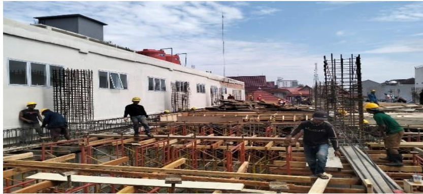
Gambar 3. 48 Pekerjaan Tulangan Balok
