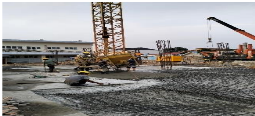
Gambar 3. 36 Pekerjaan Pengecoran Lantai Dasar
