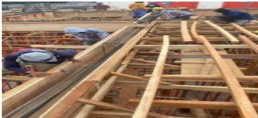
Gambar 3. 47 Pekerjaan Pemasangan Bekisting Balok
