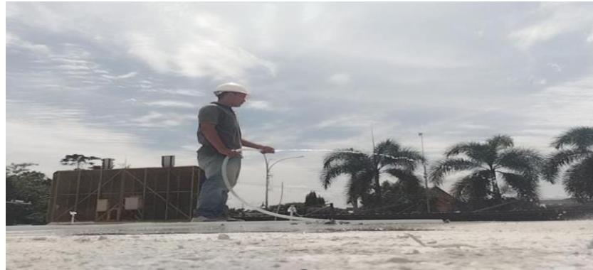
Gambar 3. 37 Pekerjaan Perawatan beton
