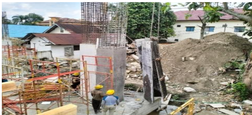
Gambar 3. 43 Pekerjaan Pembongkaran bekisting kolom
