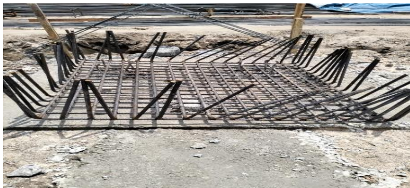
Gambar 3. 19 Tulangan pile cap
