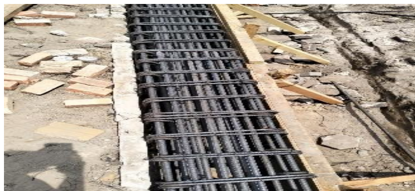
Gambar 3. 29 Pekerjaan Bekisting Sloof
