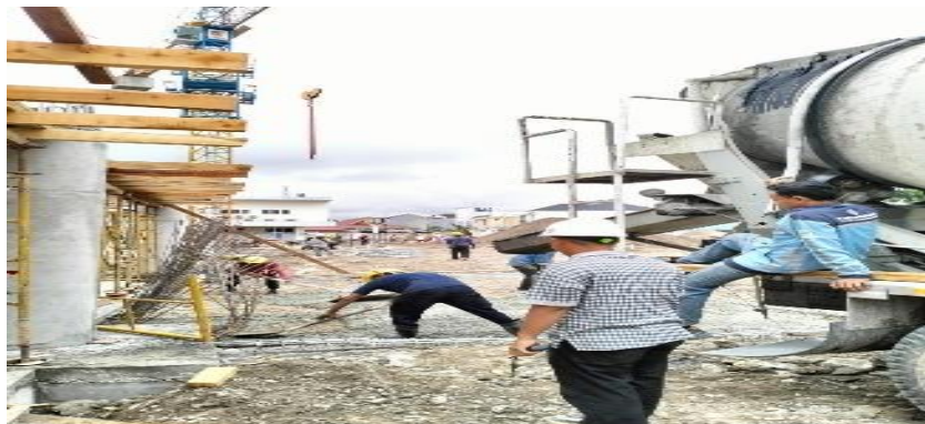
Gambar 3. 34 Pekerjaan Pengecoran Lantai Kerja
