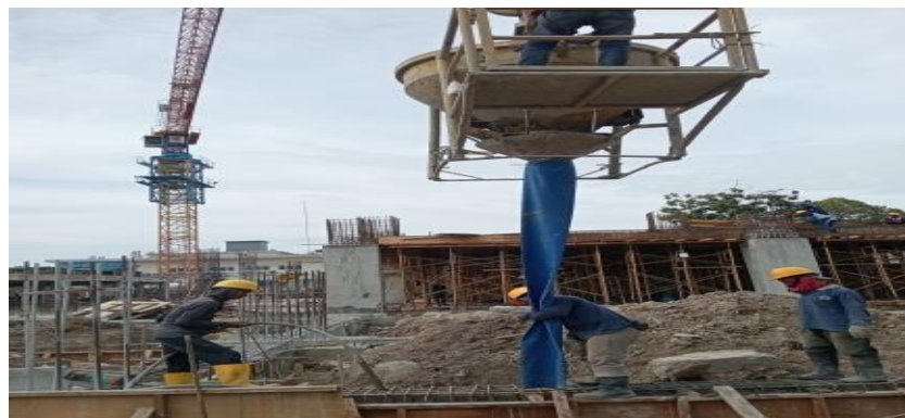
Gambar 3. 30 Pekerjaan Pengecoran Sloof
