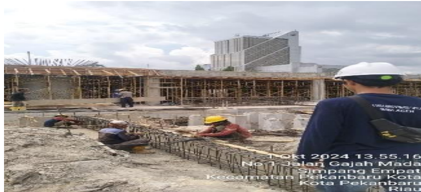
Gambar 3. 28 Pekerjaan Tulangan Sloof
