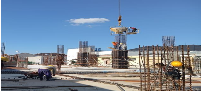
Gambar 3. 42 Pekerjaan pengecoran Kolom
