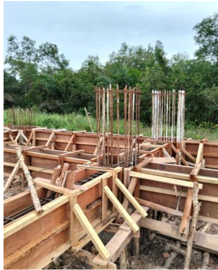
Gambar 1. 14 Pekerjaan Sloof (Sumber : Dokumentasi Pribadi, 2025)
