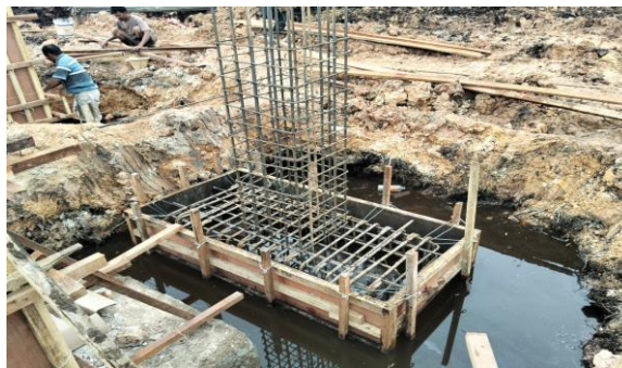
Gambar 1. 11 Pondasi Tapak (Sumber : Dokumentasi Pribadi, 2025)
