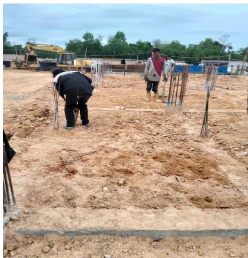
Gambar 1. 24 Memberi tanda pada pondasi untuk mengetahui posisi toilet (Sumber : Dokumentasi Pribadi, 2025)
