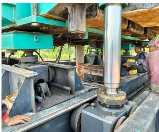
Gambar 1. 19 Penekanan Spun Pile (Sumber : Dokumentasi Pribadi, 2025)
