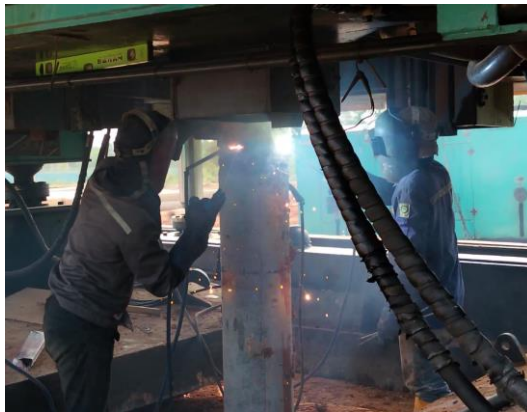
Gambar 1. 18 Penyambungan Spun Pile (Sumber : Dokumentasi Pribadi, 2025)
