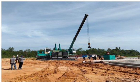
Gambar 1. 7 Pemasangan Tiang Pancang (Sumber : Dokumentasi Pribadi, 2025)
