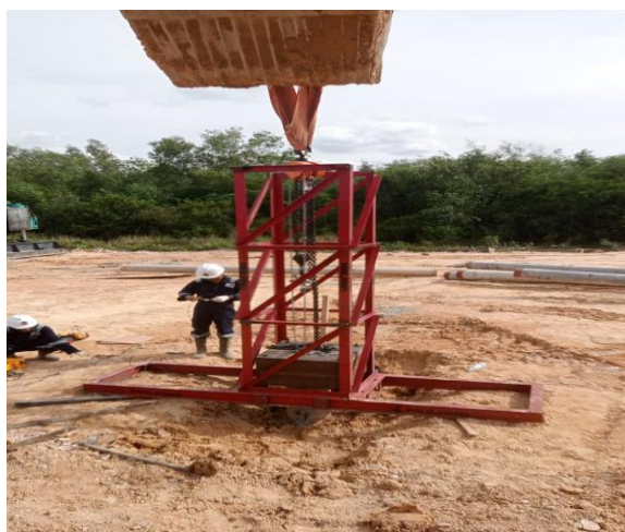
Gambar 1. 8 Pengujian Pile Dynamic Analyzer (PDA) test (Sumber : Dokumentasi Pribadi, 2025)
