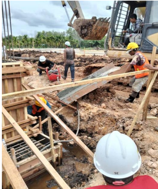
Gambar 1. 13 Pengecoran Setapak (Sumber : Dokumentasi Pribadi, 2025)
