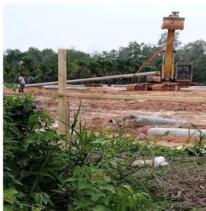
Gambar 1. 5 Pengangkatan Tiang Pancang (Sumber : Dokumentasi Pribadi, 2025)
