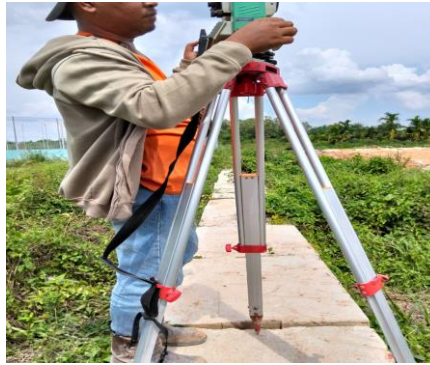
Gambar 1. 6 Pengukuran Elevasi (Sumber : Dokumentasi Pribadi, 2025)
