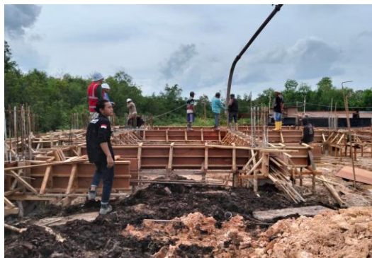
Gambar 1. 16 Pengecoran menggunakan metode curing (Sumber : Dokumentasi Pribadi, 2025)
