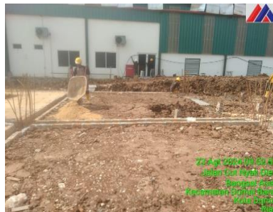
Gambar 3.38 Urugan Pasir Slab Beton ( Sumber : Dokumentasi lapangan 2024 )
