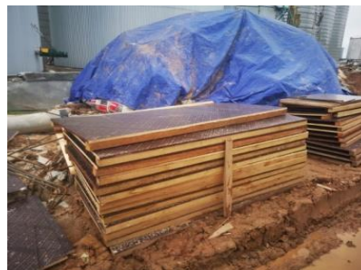
Gambar 3. 25 Pekerjaan Pembuatan bekisting ( Sumber : Dokumentasi lapangan 2024 )
