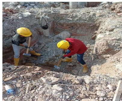
Gambar 3. 18 Pekerjaan pembobokan ( Sumber : Dokumentasi lapangan 2024 )
