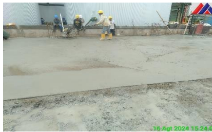
Gambar 3.46 Pekerjaan Finishing ( Sumber : Dokumentasi lapangan 2024 )
