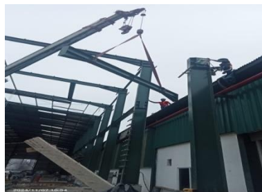
Gambar 3.57 Erection WF-200 Beam ( Sumber : Dokumentasi lapangan 2024 )
