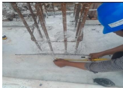
Gambar 3.49 Pekerjaan marking pedestal ( Sumber : Dokumentasi lapangan 2024 )
