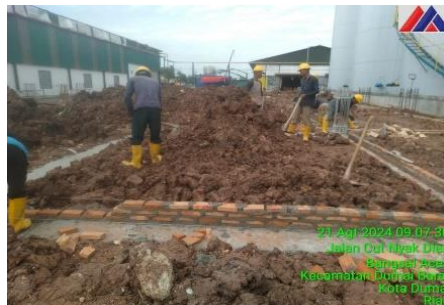
Gambar 3.36 Penimbunan Tanah Kembali Slab Beton ( Sumber : Dokumentasi lapangan 2024 )
