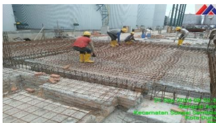
Gambar 3.40 Pemasangan Ware Mesh 2 Layer ( Sumber : Dokumentasi lapangan 2024 )
