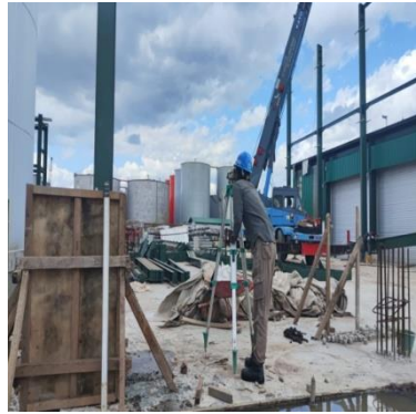
Gambar 3.54 Pekerjaan Melevel baut angkur ( Sumber : Dokumentasi lapangan 2024 )
