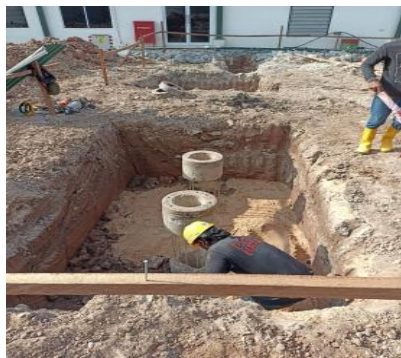
Gambar 3. 20 Pekerjaan urugan ( Sumber : Dokumentasi lapangan 2024 )
