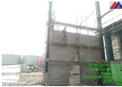
Gambar 3.67 Pekerjaan Instal escaffolding ( Sumber : Dokumentasi lapangan 2024 )
