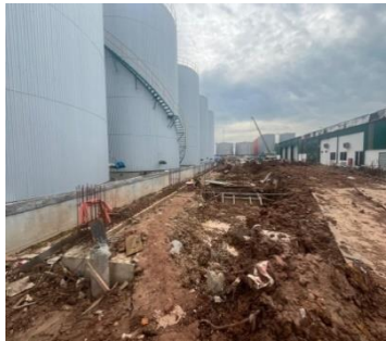
Gambar 3.31 Pekerjaan urugan pasir ( Sumber : Dokumentasi lapangan 2024 )
