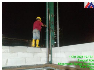
Gambar 3.66 Pekerjaan pemasangan Stick Bar ( Sumber : Dokumentasi lapangan 2024 )
