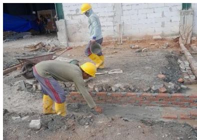
Gambar 3.32 Pemasangan Lean Concrete Ground Beam ( Sumber : Dokumentasi lapangan 2024 )
