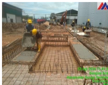
Gambar 3.39 Pemasangan Lean Concrete Slab Beton ( Sumber : Dokumentasi lapangan 2024 )
