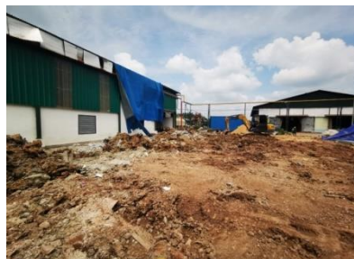
Gambar 3. 6 Pembersihan lokasi proyek ( Sumber : Dokumentasi lapangan 2024 )
