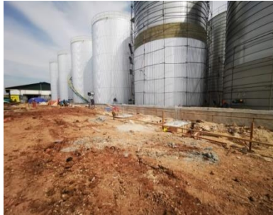
Gambar 3. 7 Pemasangan Bouwplank ( Sumber : Dokumentasi lapangan 2024 )
