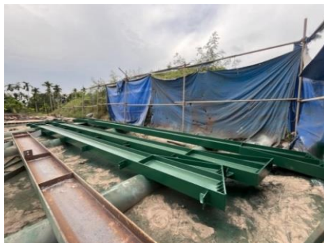
Gambar 3. 16 Proses pengecatan ( Sumber : Dokumentasi lapangan 2024 )
