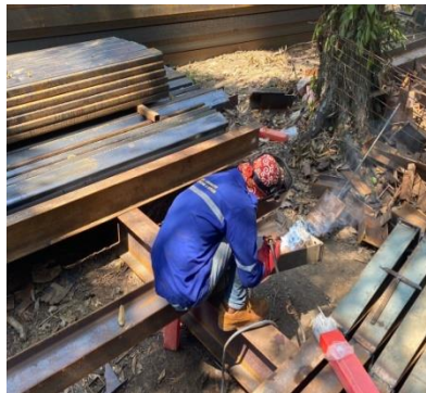
Gambar 3. 12 Proses pengelasan ( Sumber : Dokumentasi lapangan 2024 )
