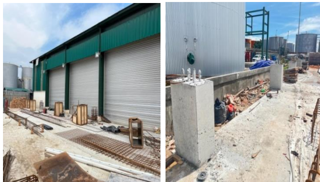
Gambar 3.53 kolom pedestal yang sudah di cor ( Sumber : Dokumentasi lapangan 2024 )
