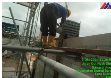
Gambar 3.68 Pekerjaan Pengecoran Kolom Praktis ( Sumber : Dokumentasi lapangan 2024 )
