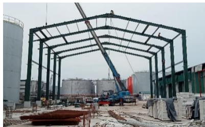
Gambar 3.59 Erection CNP-50 Purlin ( Sumber : Dokumentasi lapangan 2024 )
