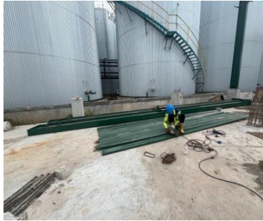
Gambar 3.55 Erection struktur baja WF dengan Scaffolding plan ( Sumber : Dokumentasi lapangan 2024 )
