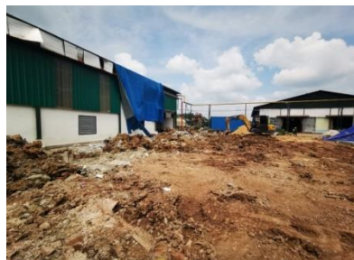
Gambar 3. 6 Pembersihan lokasi proyek ( Sumber : Dokumentasi lapangan 2024 )
