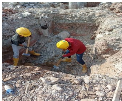
Gambar 3. 18 Pekerjaan pembobokan ( Sumber : Dokumentasi lapangan 2024 )
