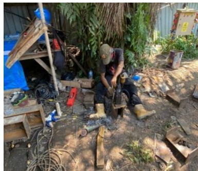
Gambar 3. 10 Proses pengeboran ( Sumber : Dokumentasi lapangan 2024 )
