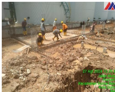
Gambar 3.34 Pemasangan Rebar Ground Beam ( Sumber : Dokumentasi lapangan 2024 )
