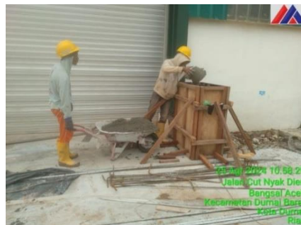
Gambar 3.52 Pekerjaan pengecoran kolom Sumber : Dokumentasi lapangan
