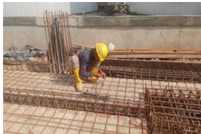
Gambar 3.42 Pemasangan Besi Suport Bar ( Sumber : Dokumentasi lapangan 2024 )
