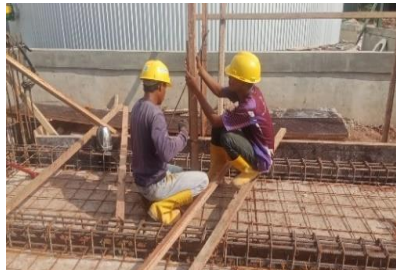
Gambar 3.43 Pemasangan Bekisting Lantai ( Sumber : Dokumentasi lapangan 2024 )
