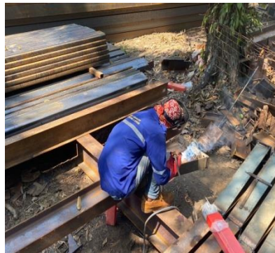
Gambar 3. 12 Proses pengelasan ( Sumber : Dokumentasi lapangan 2024 )
