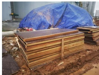
Gambar 3. 25 Pekerjaan Pembuatan bekisting ( Sumber : Dokumentasi lapangan 2024 )
