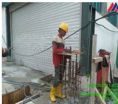
Gambar 3.50 Pekerjaan perakitan dan pemasangan besi angkur ( Sumber : Dokumentasi lapangan 2024 )
