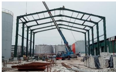
Gambar 3.59 Erection CNP-50 Purlin ( Sumber : Dokumentasi lapangan 2024 )
