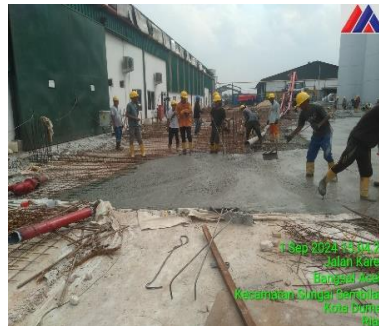
Gambar 3.35 Pengecoran Ground Beam ( Sumber : Dokumentasi lapangan 2024 )
