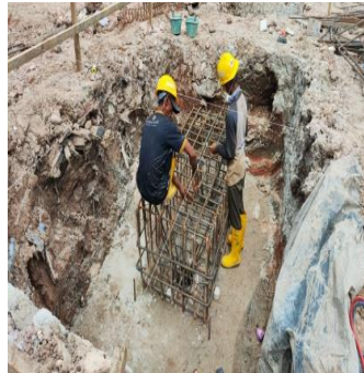
Gambar 3. 24 Pekerjaan Perakitan tulangan ( Sumber : Dokumentasi lapangan 2024 )
