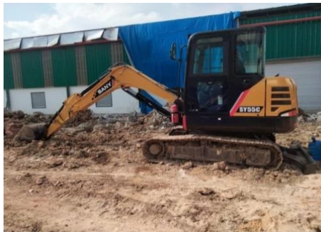
Gambar 3. 17 Pekerjaan galian ( Sumber : Dokumentasi lapangan 2024 )
