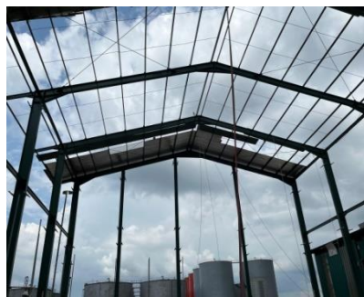
Gambar 3.62 Pekerjaan pemasangan atap ( Sumber : Dokumentasi lapangan 2024 )
