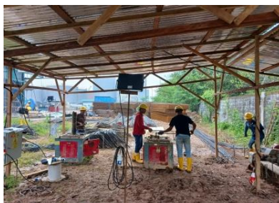
Gambar 3. 23 Pekerjaan Pembengkokan tulangan ( Sumber : Dokumentasi lapangan 2024 )
