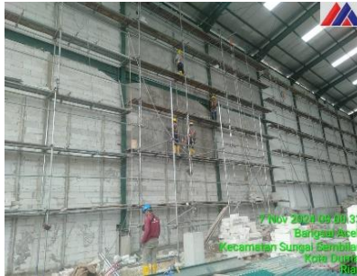
Gambar 3.70 Pekerjaan acian ( Sumber : Dokumentasi lapangan 2024 )
