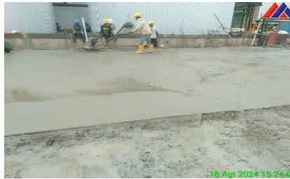
Gambar 3.46 Pekerjaan Finishing ( Sumber : Dokumentasi lapangan 2024 )
