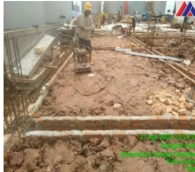
Gambar 3.37 Pemadatan Tanah Slab Beton ( Sumber : Dokumentasi lapangan 2024 )
