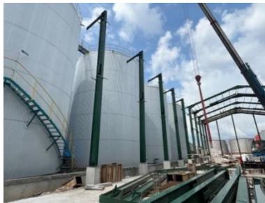
Gambar 3.56 Erection WF 500 Colum ( Sumber : Dokumentasi lapangan 2024 )
