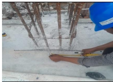
Gambar 3.49 Pekerjaan marking pedestal ( Sumber : Dokumentasi lapangan 2024 )
