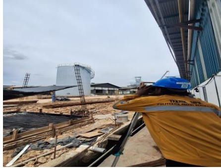
Gambar 3. 19 Pekerjaan Penentuan as pile cap ( Sumber : Dokumentasi lapangan 2024 )
