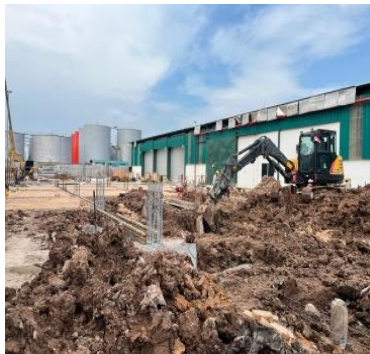
Gambar 3.30 Pekerjaan galian Ground Beam ( Sumber : Dokumentasi lapangan 2024 )
