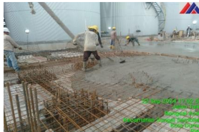
Gambar 3.44 Pekerjaan Pengecoran K300 ( Sumber : Dokumentasi lapangan 2024 )
