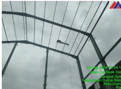
Gambar 3.60 Erection Round Bar ( Sumber : Dokumentasi lapangan 2024 )
