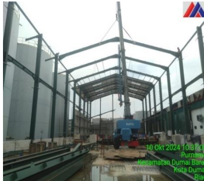
Gambar 3.58 Erection WF 400 Rafter ( Sumber : Dokumentasi lapangan 2024 )
