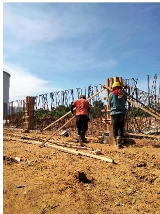
**Gambar 3. 24** Pekerjaan pemasangan formwork pedestal
