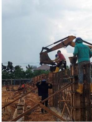
**Gambar 3. 27**Proses penuangan beton kedalam pedestal
