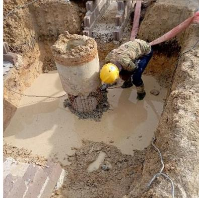
**Gambar 3. 12 Pemotongan tulangan spun pile**
