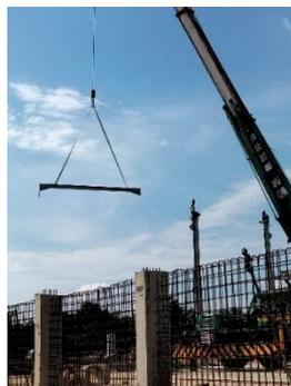
**Gambar 3. 36** Pekerjaan erection balok baja
