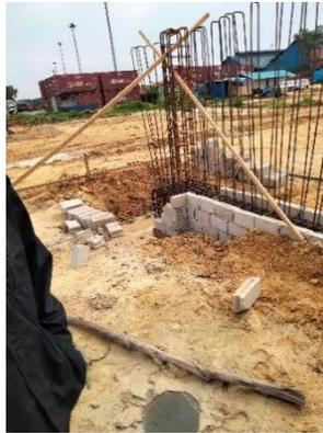
**Gambar 3. 18** Pekerjaan pemasangan tulangan pedestal
