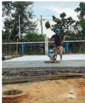
**Gambar 3. 33**Proses penghalusan coran menggunakan alat Trowel
