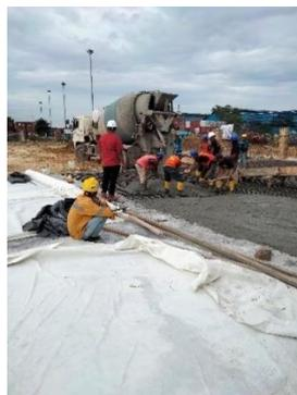
**Gambar 3. 34**Proses penuangan beton
