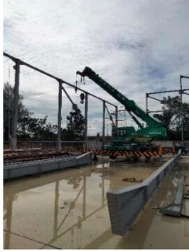
**Gambar 3. 35** Pekerjaan erection kolom dan balok baja
