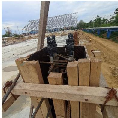
**Gambar 3. 25**Proses pemasangan angkur
