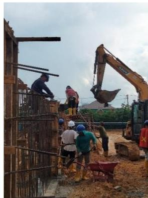
**Gambar 3. 28**Pekerjaan pengecoran kolom pedestal
