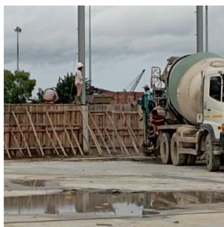
**Gambar 3. 30** Pekerjaan pengecoran dinding
