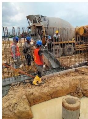
**Gambar 3. 23** Pekerjaan pengecoran tie bim
