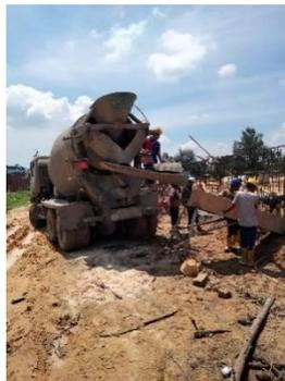
**Gambar 3. 21** Pekerjaan pengecoran menggunakan truk *mixer*
