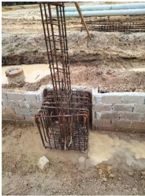
**Gambar 3. 15** Pekerjaan pemasangan tulangan
