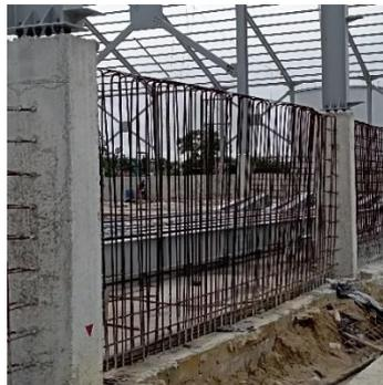
**Gambar 3. 19 Pekerjaan pemasangan tulangan dinding**
