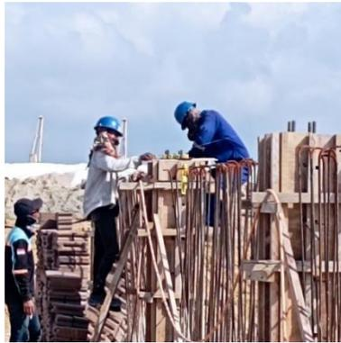
**Gambar 3. 26**ekerjaan pemasangan angkur
