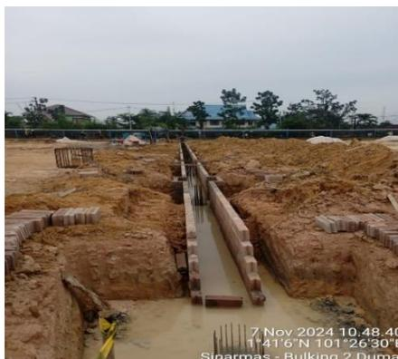
**Gambar 3. 11**Pekerjaan pemasangan formwork
