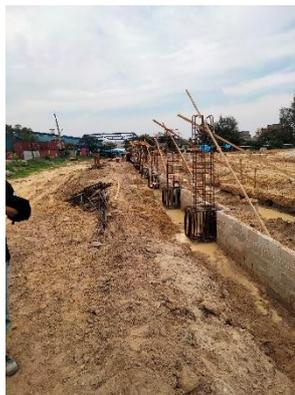
**Gambar 3. 17** Pekerjaan pengikatan tulangan pedestal
