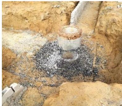
**Gambar 3. 13 Pekerjaan pembobokan spun pile**
