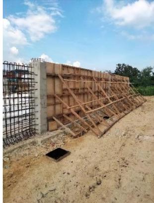
**Gambar 3. 29** Pekerjaan pemasangan formwork dinding
