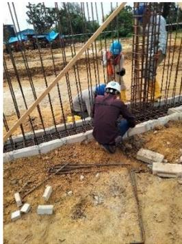
**Gambar 3. 16** Pekerjaan pemasangan formwork
