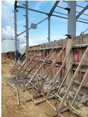
**Gambar 3. 20** Pekerjaan pengecoran dinding
