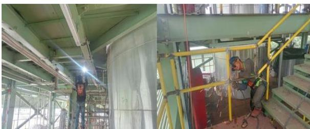
125 (Rabu, 25 Desember 2024) Pemasangan plat strip pada reboiler. Dan marking atap dan cladding fasciah.
