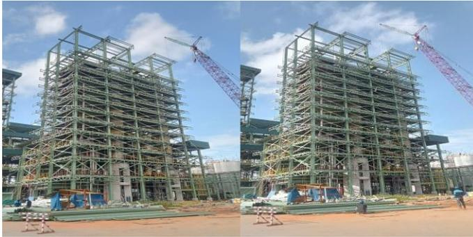
92. (Senin, 11 November 2024) Penaikan hoist beam dan erection gording untuk atap.
