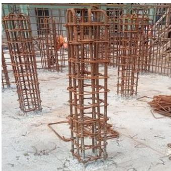
114. (Selamat, 10 Desember 2024) Pengecoran kolom cooling tower.
