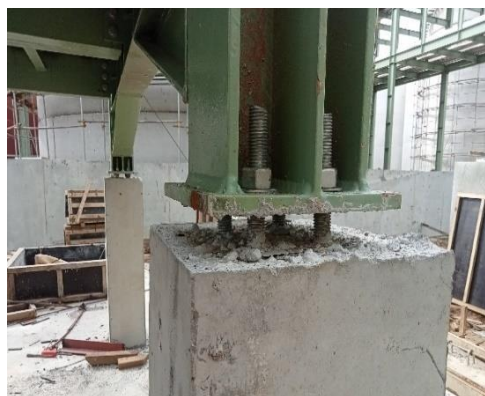
Gambar 3.5 Cutting kolom pedestal Sumber : Dokumentasi lapangan, 2024
