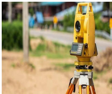
Gambar 3.10 Penegakan alat statif dan total station Sumber : Dokumentasi lapangan, 2024
