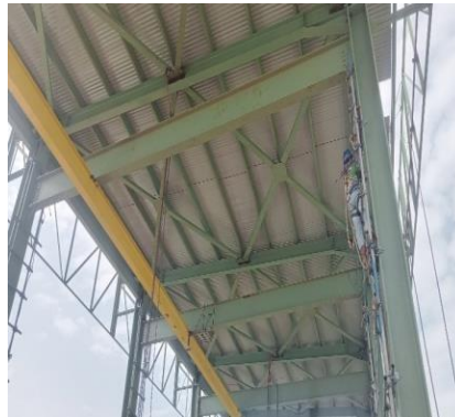
Gambar 3.14 Atap bangunan Sumber : Dokumentasi lapangan, 2024
