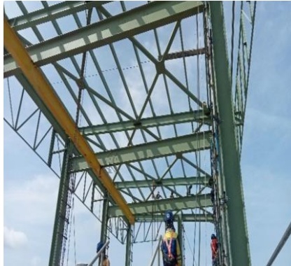
Gambar 3.13 Pemasangan Bracing dan sagrod Sumber : Dokumentasi lapangan, 2024
