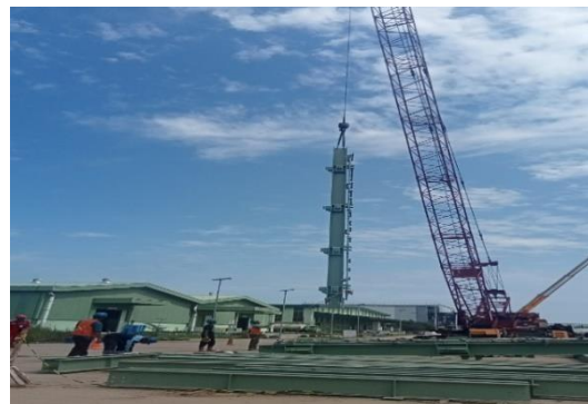
Gambar 3.8 Proses penaikan Sumber : Dokumentasi lapangan, 2024
