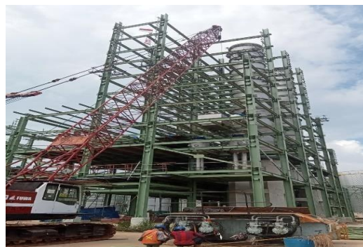
Gambar 3.9 Proses pemasangan Sumber : Dokumentasi lapangan, 2024
