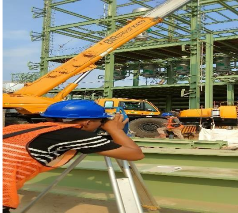
Gambar 3.12 Verticality kolom Sumber : Dokumentasi lapangan, 2024
