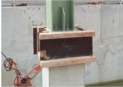
Gambar 3.6 Proses Grouting kolom pedestal Sumber : Dokumentasi lapangan, 2024
