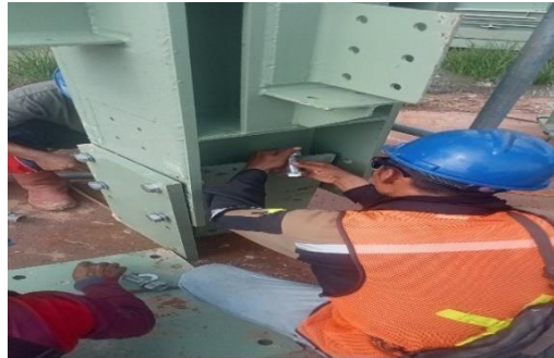
Gambar 3.7 Persiapan peralatan dan material Sumber : Dokumentasi lapangan, 2024
