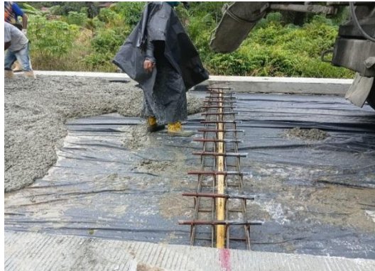
Gambar 3.25: Pemasangan Besi Dowel Sumber : Dokumentasi lapangan, 2025
