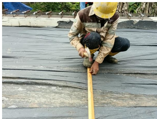
Gambar 3.24: Pemasangan Plang Kayu Sumber : Dokumentasi lapangan, 2025
