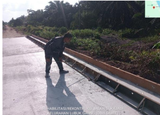
Gambar 3.19: Pekerjaan Pemasangan Mal Bahu Jalan
