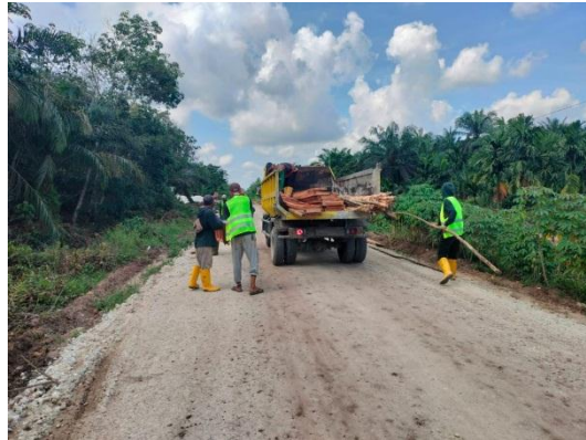
Gambar 3.15: Pekerjaan Pemasangan Mal Lc Sumber : Dokumentasi lapangan, 2025
