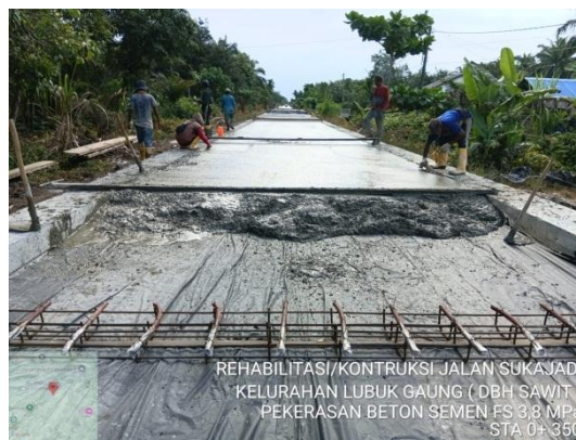
Gambar 3.26: Pekerjaan Pengecoran Rigit Fs 3,8 Mpa Sumber : Dokumentasi lapangan, 2025
