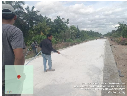
Gambar 3.30: Pemasangan Karpet Geotekwoven Dan Pekerjaan Curing Sumber : Dokumentasi lapangan, 2025
