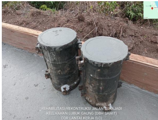
Gambar 3.18: Pembuatan Beton Silinder Untuk Lc Sumber : Dokumentasi lapangan, 2025
