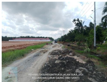
Gambar 3.5: Survey Lokasi Proyek Sumber : Dokumentasi lapangan, 2025
