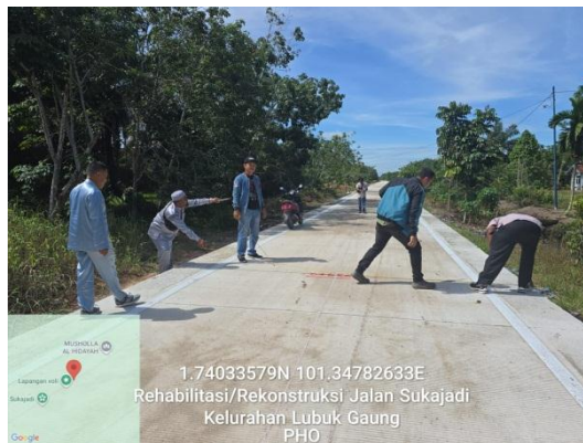
Gambar 3.33: PHO Sumber : Dokumentasi lapangan, 2025
