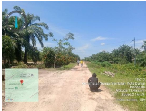
Gambar 3.6 Pengukuran Dan Pematokan Sumber : Dokumentasi lapangan, 2025
