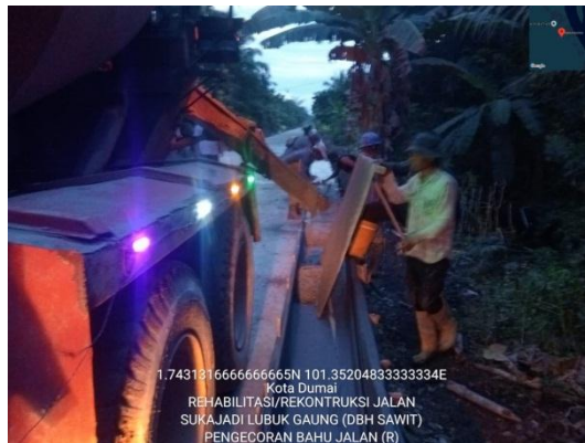
Gambar 3.20: Pekerjaan Pengecoran Bahu Jalan Sumber : Dokumentasi lapangan, 2025
