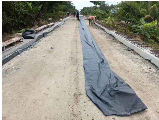
Gambar 3.23: Pemasangan Plasti Hitam Sumber : Dokumentasi lapangan, 2025
