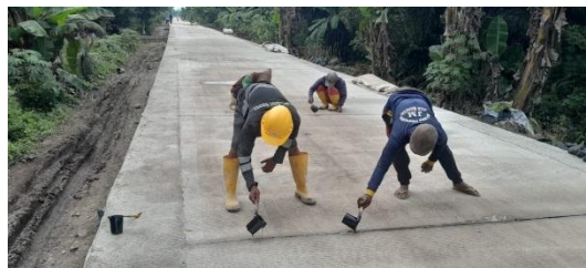
Gambar 3.31: Pekerjaan Prime Coat Sumber : Dokumentasi lapangan, 2025
