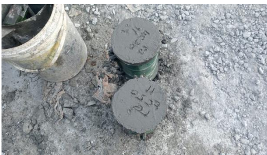
Gambar 3.22: Pembuatan Beton Selinder Bahu Jalan Sumber : Dokumentasi lapangan, 2025
