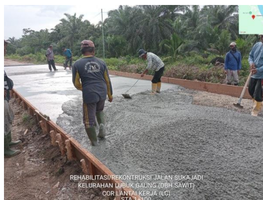
Gambar 3.16: Pekerjaan Pengecoran Lc
