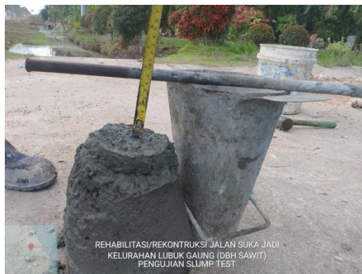
Gambar 3.27: Uji Slump Tes Fs 3,8 Mpa Sumber : Dokumentasi lapangan, 2025
