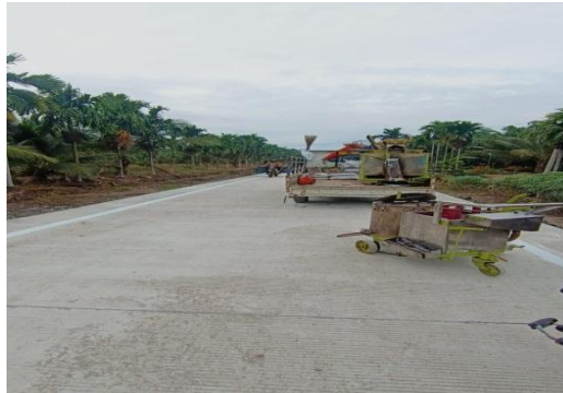
Gambar 3.32: Pembuatan Marka Jalan Sumber : Dokumentasi lapangan, 2025
