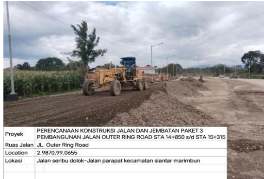
Gambar 3. 17 Penghamparan agregat Sumber: Dokumentasi Lapangan
