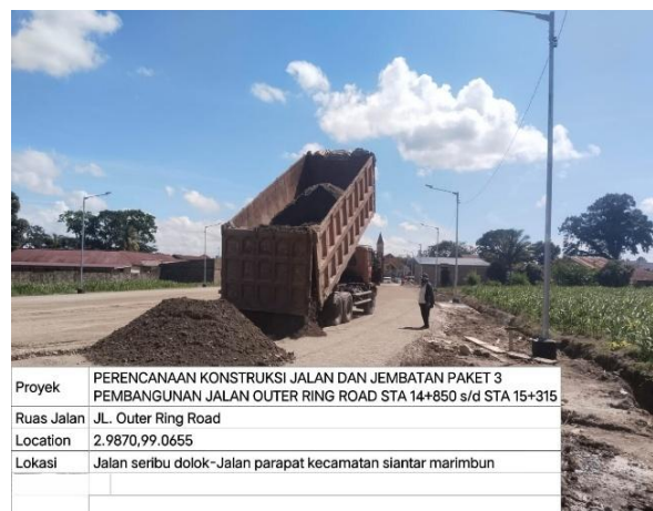
Gambar 3. 16 Penyiaran agregat kelas B Sumber: Dokumentasi lapangan
