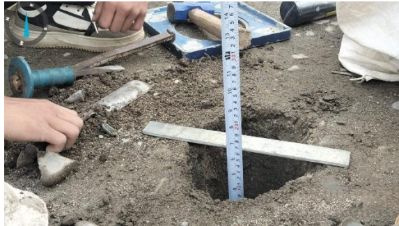
Gambar 3. 21 Pengujian test pit lapisan agregat kelas B dan tanah timbunan Sumber : Dokumentasi Lapangan
