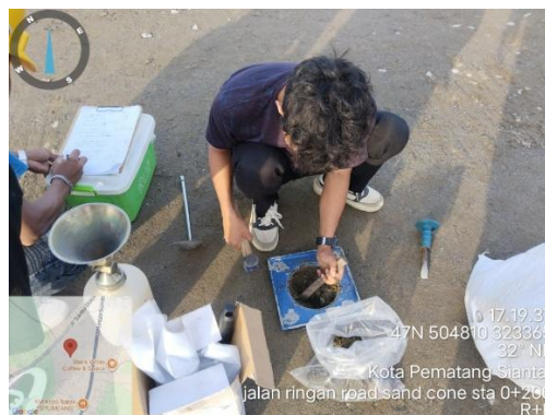
Gambar 3. 20 Pengujian sand cone Sumber : Dokumentasi Lapangan
