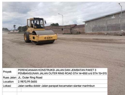
Gambar 3. 18 Pemadatan base B Sumber: Dokumentasi Lapangan
