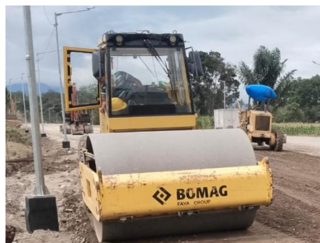
Gambar 3. 11 Tandem roller Sumber: Dokumentasi lapangan
