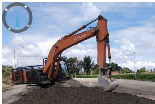
Gambar 3. 9 Excavator Sumber: Dokumentasi lapangan
