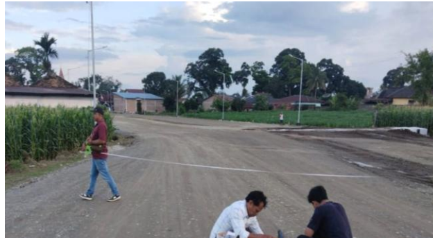
Gambar 3. 19 Pengukuran setelah pemadatan base B Sumber: Dokumentasi Lapangan
