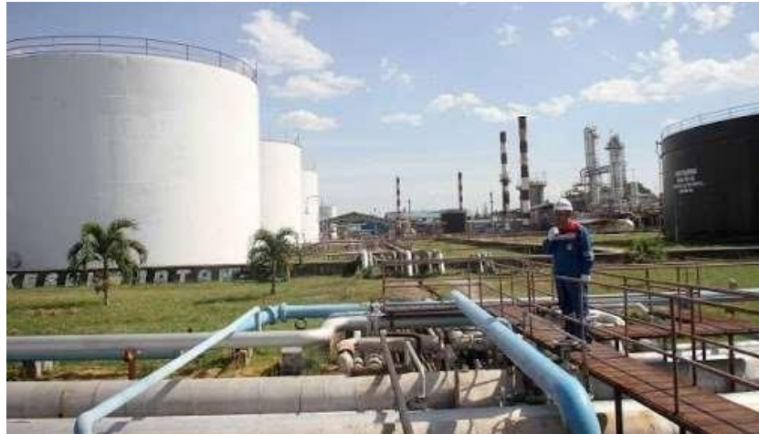
Gambar 1.2 Tangki Produk Pengolahan Minyak (Sumber: Dokumentasi Lapangan, 2024)
