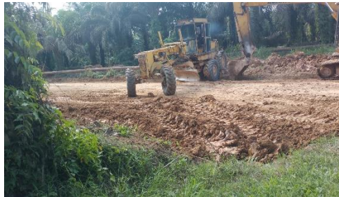
Gambar 3. 1 Motor Grader Sumber : Dokumentasi KP,2024
