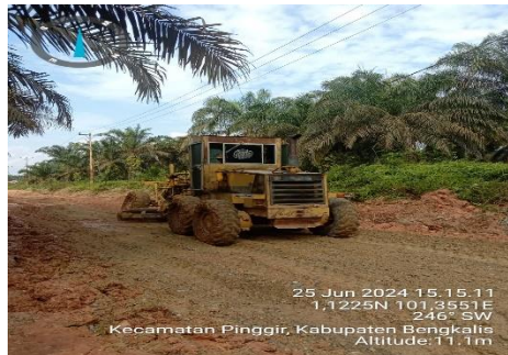
Gambar 3. 7 Pekerjaan Penghamparan Urpil Sumber : Dokumentasi KP,2024
