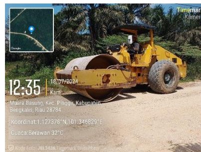
Gambar 3. 2 Vibratory Roller Sumber : Dokumentasi KP,2024
