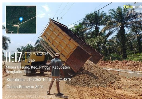
Gambar 3. 8 Pekerjaan Penghamparan Base B Sumber : Dokumentasi KP,2024
