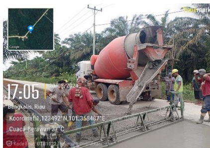
Gambar 3. 17 Pengecoran Rigid Sumber : Dokumentasi KP,2024
