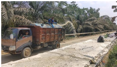
Gambar 3. 5 Water Tank Sumber : Dokumentasi KP,2024
