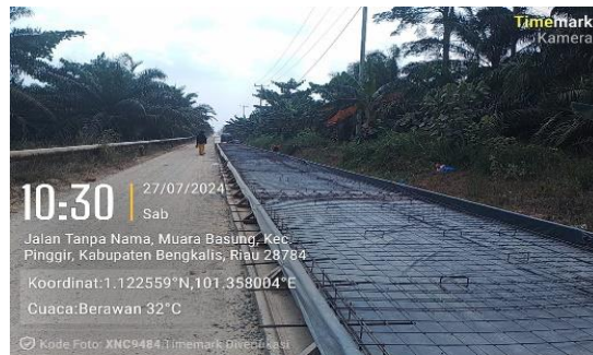
Gambar 3. 15 Pemasangan Bekisting Rigid Sumber : Dokumentasi KP, 2024
