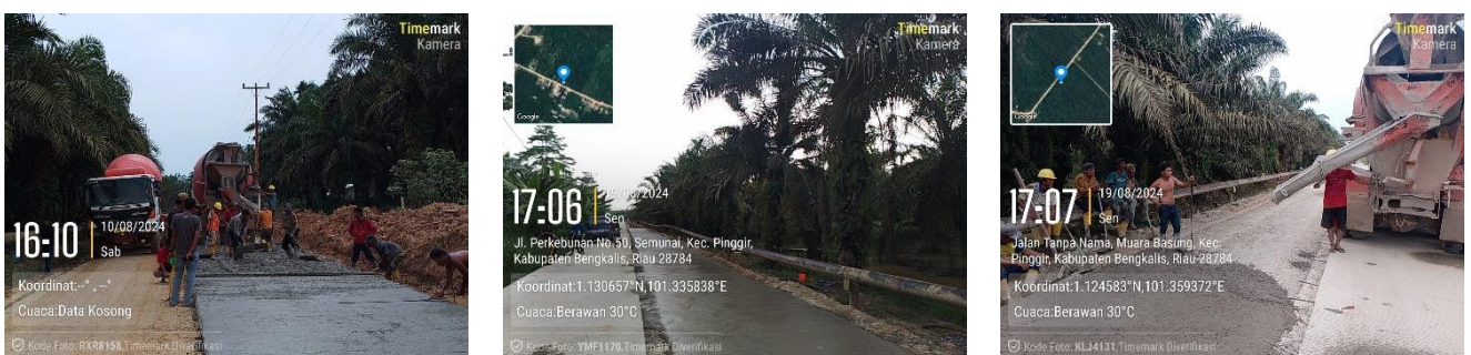
Gambar 3. 13 Pengecoran Lc Sumber : Dokumentasi KP, 2024
