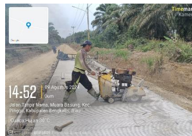
Gambar 3. 20 Cutting Beton Sumber : Dokumentasi KP, 2024
