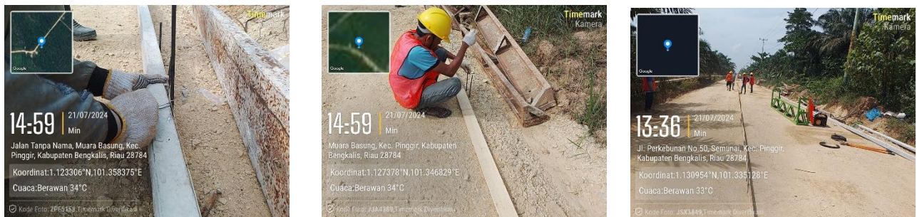
Gambar 3. 11 Pemasangan bekisting Sumber : Dokumentasi lapangan 2024
