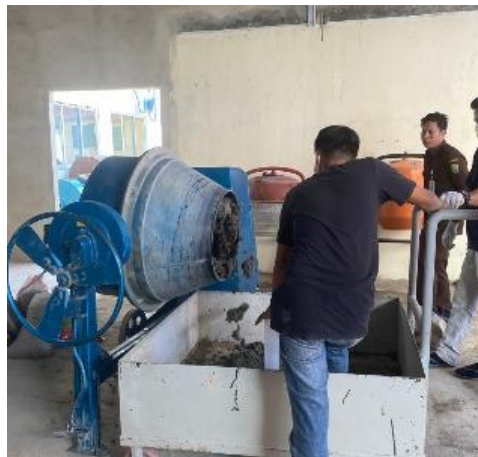
Gambar 3. 68 Pencampuran beton
