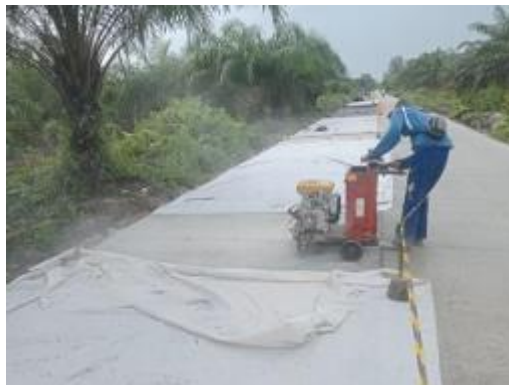
Gambar 3. 35 Pekerjaan Cutting
