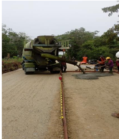
Gambar 3. 21 Pengecoran LC
