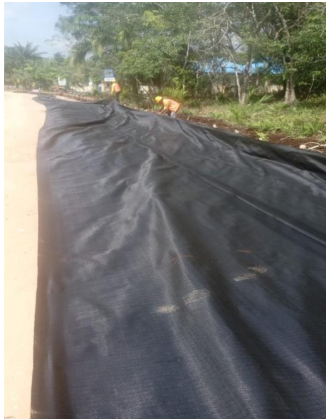
Gambar 3. 7 Pemasangan Geotextile
