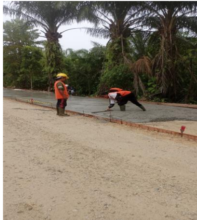
Gambar 3. 22 Merata pengecoran
