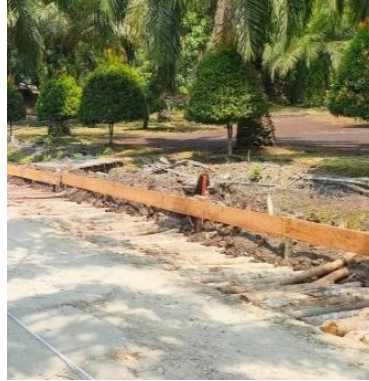
Gambar 3. 5 Pemasangan papan mal
