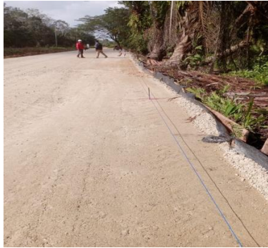
Gambar 4. 1 Pemasngan bekisting LC
