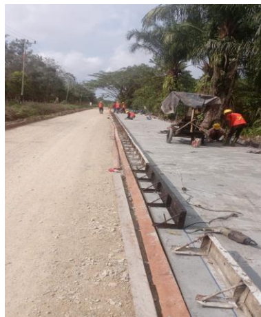
Gambar 3. 23 Pengeboran LC untuk Pemasangan Besi Penahan Bekisting Rigid
