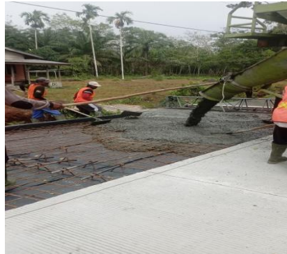
Gambar 3. 27 Pengecoran Rigid
