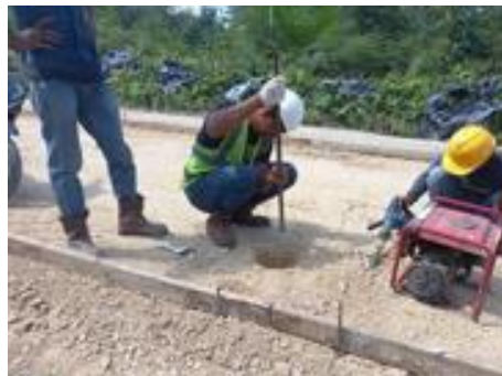
Gambar 3. 15 Penggalian lubang Test Pit Base B
