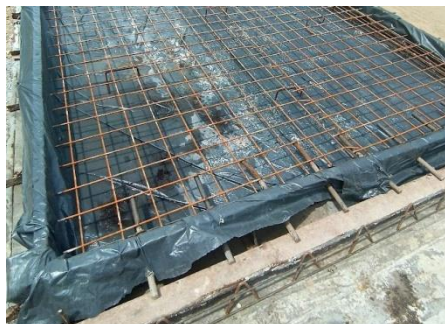
Gambar 3. 24 Pemasangan Tulangan Dowel & Dudukan Wiremesh
