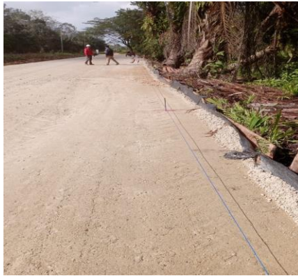
Gambar 4. 3 Penentu kan titik patokan
