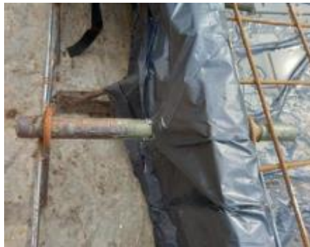
Gambar 3. 25 Pemasangan Tie Bar
