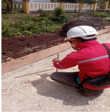
Gambar 3. 18 Gambar pemasangan patok LC
