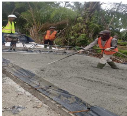
Gambar 3. 29 Pemadatan Beton Menggunakan Vibrator (sumber : Dokumentasi Lapangan, Kerja Praktek 2025)
