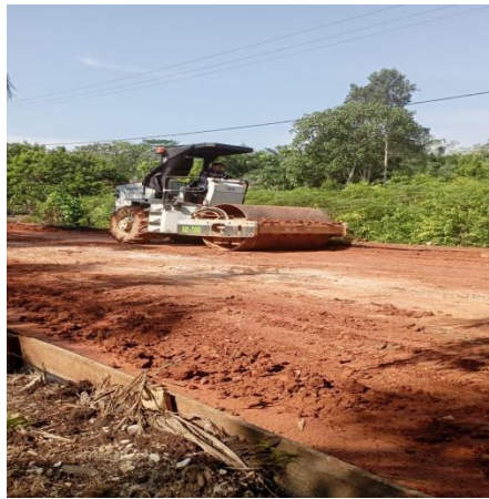
Gambar 3. 9 Pemadatan Tanah urugan pilihan
