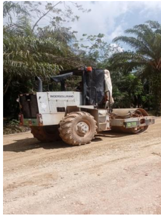
Gambar 3. 13 Pemadatan agregat base B
