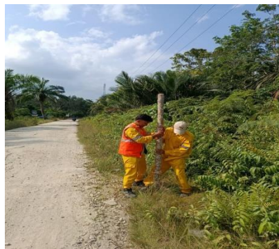
Gambar 3. 4 Pemasangan patok mal
