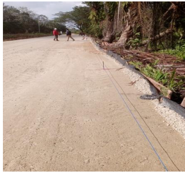
Gambar 3. 20 Pegecekan Bekisting LC (sumber : Dokumentasi Lapangan, Kerja Praktek 2025)
