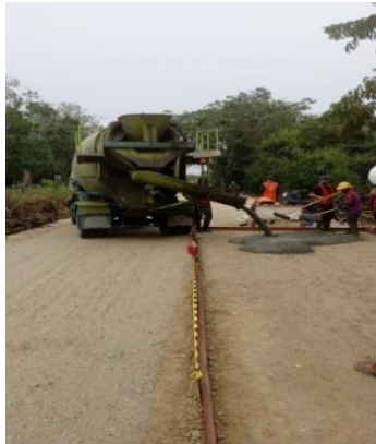
Gambar 4. 7 Penuangan beton
