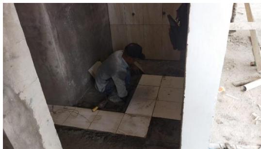
Gambar 3. 51 Pemasangan Keramik Toilet (Sumber : Dokumentasi Pribadi, 2023)
