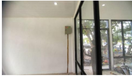
Gambar 3. 41 Pemasangan Box Panel (Sumber : Dokumentasi Pribadi, 2023)
