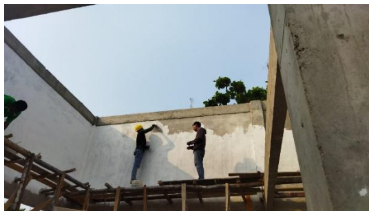
Gambar 3. 19 Plamir Dinding (Sumber : Dokumentasi Pribadi, 2023)
