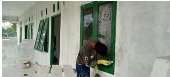
Gambar 3. 54 Pengecatan Jendela dan Pintu (Sumber : Dokumentasi Pribadi, 2023)
