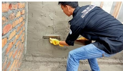
Gambar 3. 14 Belajar Cara Mengerjakan Perkerjaan Plesteran Dinding (Sumber : Dokumentasi Pribadi, 2023)
