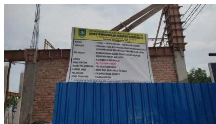
Gambar 2.6 Papan Proyek Ruang Tunggu Roro (Sumber : Dokumentasi Pribadi, 2023)
