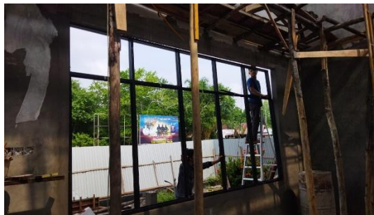
Gambar 3. 23 Pemasangan Kusen Aluminium (Sumber : Dokumentasi Pribadi, 2023)
