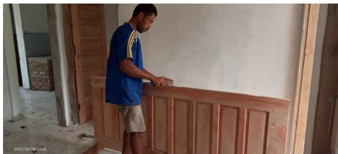
Gambar 3. 21 Pemasangan Pintu ( Sumber : Dokumentasi Pribadi, 2023)
