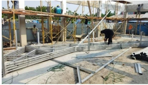
Gambar 3. 30 Fabrikasi Kuda-Kuda Atap (Sumber : Dokumentasi Pribadi , 2023)
