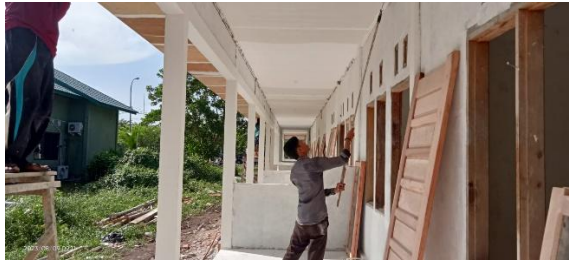
Gambar 3. 53 Pengecatan Dinding (Sumber : Dokumentasi Pribadi, 2023)
