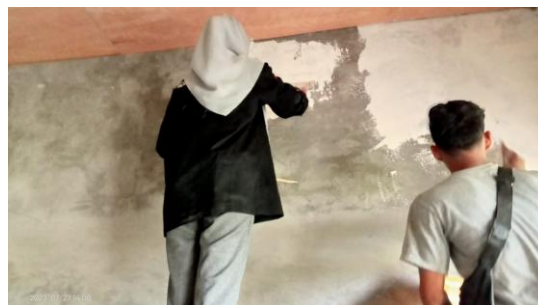
Gambar 3. 15 Pekerjaan Plamir (Sumber : Dokumentasi Pribadi, 2023)
