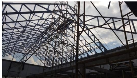
Gambar 3. 31 Pemasangan Kuda-kuda (Sumber : Dokumentasi Pribadi, 2023)
