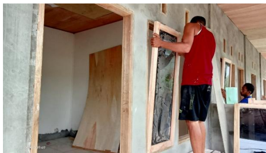
Gambar 3. 20 Pemasangan Jendela (Sumber : Dokumentasi Pribadi, 2023)
