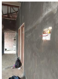
Gambar 3. 35 Pemasangan Stop Kontak (Sumber : Dokumentasi Pribadi, 2023)
