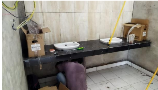
Gambar 3. 46 Pemasangan Wastafel (Sumber : Dokumentasi Pribadi, 2023)
