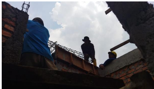
Gambar 3. 11 Pemasangan Bekisting dan Tulangan Balok (Sumber : Dokumentasi Pribadi, 2023)
