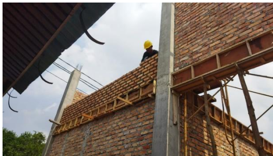
Gambar 3. 17 Pemasangan Bata (Sumber : Dokumentasi Pribadi, 2023)
