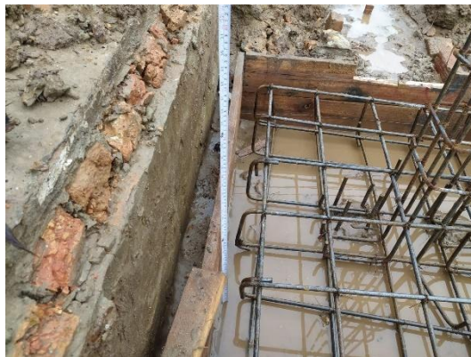
Gambar 3. 3 Pemasangan Tulangan Pondasi ( Sumber : Dokumentasi Pribadi, 2023)
