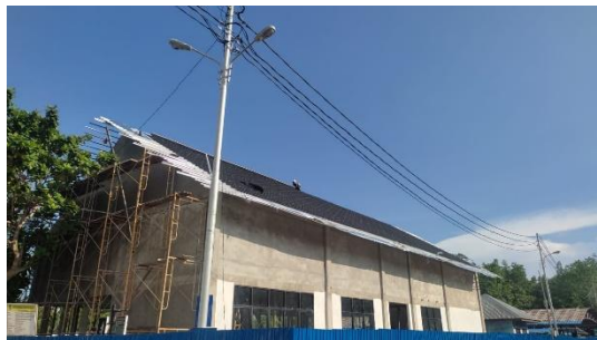
Gambar 3. 32 Pemasangan Penutup Atap (Sumber : Dokumentasi Pribadi, 2023)
