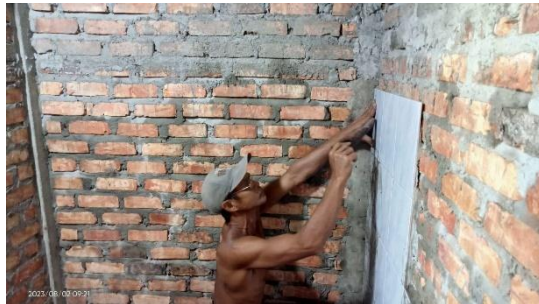
Gambar 3. 49 Pemasangan Karamik Pada Dinding Kamar Mandi (Sumber : Dokumentasi, Pribadi, 2023)
