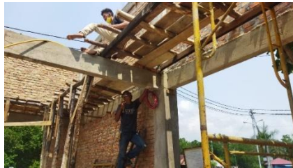
Gambar 3. 38 Pemasangan Kabel (Sumber : Dokumentasi Pribadi, 2023)
