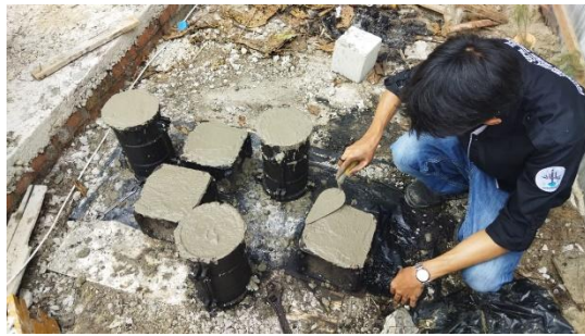
Gambar 3. 57 Pembuatan Sampel Beton Silinder dan Kubus (Sumber : Dokumentasi Pribadi, 2023)
