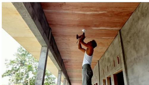
Gambar 3. 36 Pemasangan Lampu (Sumber : Dokumentasi Pribadi, 2023)
