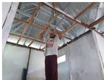
Gambar 3. 34 Pemasangan Kabel (Sumber : Dokumentasi Pribadi, 2023)
