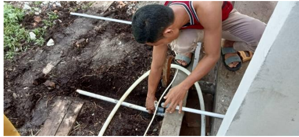
Gambar 3. 43 Instalasi Pipa (Sumber : Dokumentasi Pribadi, 2023)
