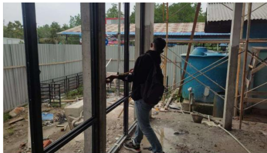
Gambar 3. 56 Pengukuran Kusen Jendela (Sumber : Dokumentasi Pribadi, 2023)
