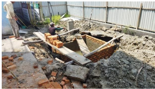
Gambar 3. 44 Pembuatan Septic Tank (Sumber : Dokumentasi Pribadi, 2023)
