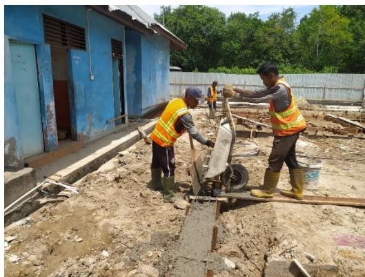
Gambar 3. 4 Pengecoran Balok Sloof (Sumber : Dokumentasi Pribadi, 2023)
