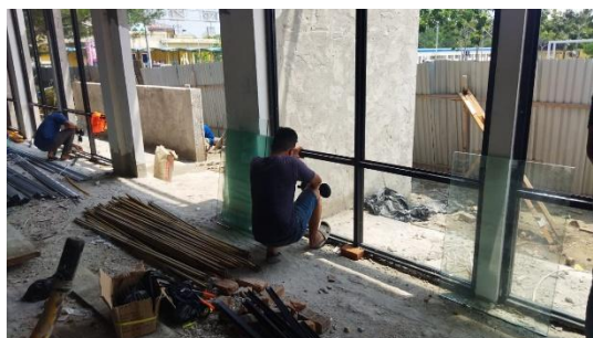
Gambar 3. 24 Pemasangan Kaca Jendela (Sumber : Dokumentasi Pribadi, 2023)
