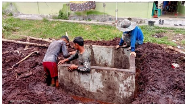
Gambar 3. 42 Pekerjaan Septic Tank (Sumber : Dokumentasi Pribadi, 2023)
