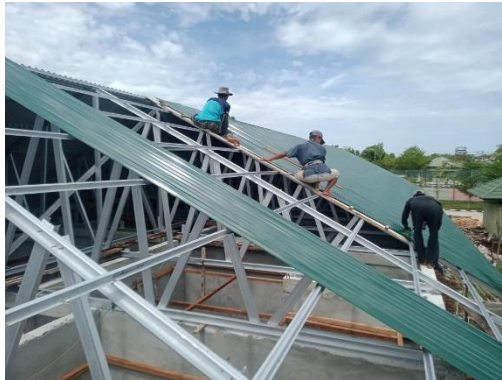
Gambar 3. 27 Pekerjaan Pemasangan Penutup Atap Spandek (Sumber : Dokumentasi Pribadi, 2023)
