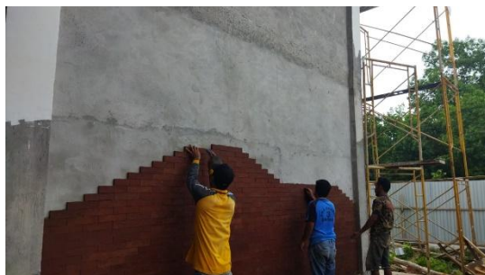
Gambar 3. 52 Pemasangan Batu Teracota (Sumber : Dokumentasi Pribadi, 2023)
