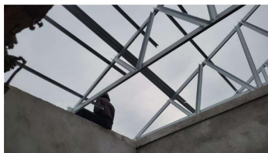
Gambar 3. 26 Pekerjaan Pemasangan Rangka Baja Ringan (Sumber : Dokumentasi Pribadi, 2023)
