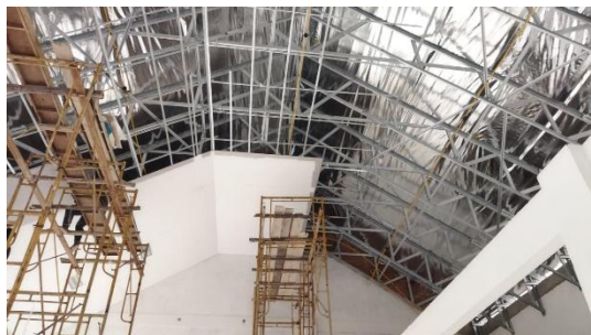
Gambar 3. 33 Pemasangan Plafond (Sumber : Dokumentasi Pribadi, 2023)
