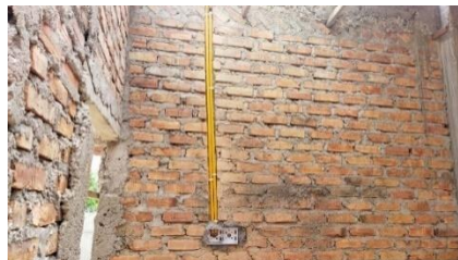
Gambar 3. 39 Pemasangan Stop Kontak (Sumber : Dokumentasi Pribadi, 2023)
