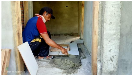
Gambar 3. 48 Pemasangan Keramik (Sumber : Dokumentasi Pribadi, 2023)
