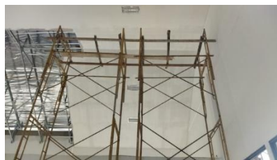
Gambar 3. 40 Pemasangan Lampu (Sumber : Dokumentasi Pribadi, 2023)
