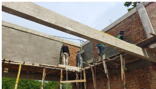
Gambar 3. 18 Plesteran Dinding (Sumber : Dokumentasi Pribadi, 2023)
