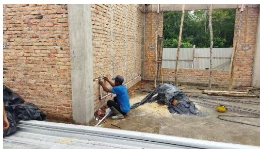
Gambar 3. 45 Instalasi Pipa (Sumber : Dokumentasi Pribadi, 2023)
