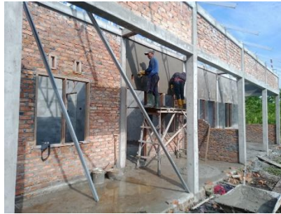
Gambar 3. 13 Pekerjaan Plesteran dan Acian Dinding (Sumber : Dokumentasi Pribadi, 2023)
