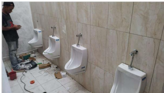
Gambar 3. 47 Pemasangan Urinoir (Sumber : Dokumentasi Pribadi, 2023)
