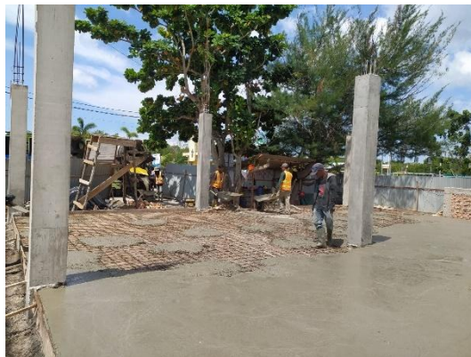
Gambar 3. 6 Pengecoran Lantai Kerja (Sumber : Dokumentasi Pribadi, 2023)
