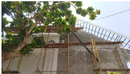
Gambar 3. 55 Pengecatan Dinding (Sumber : Dokumentasi Pribadi, 2023)
