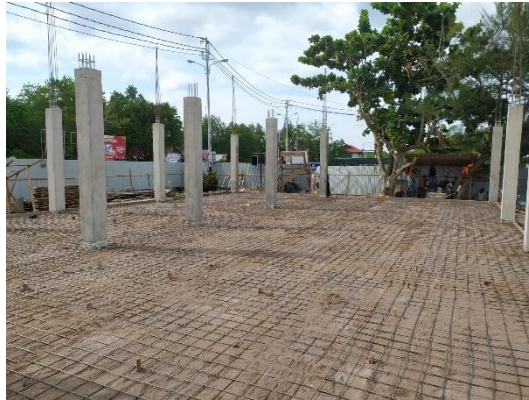
Gambar 3. 5 Pemasangan Tulangan Lantai Kerja (Sumber : Dokumentasi Pribadi, 2023)
