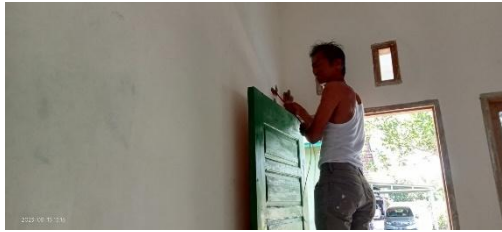
Gambar 3. 37 Pemasangan MCB (Sumber : Dokumentasi Pribadi, 2023)
