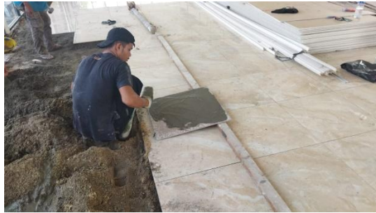
Gambar 3. 50 Pemasangan Granite Ruang Utama (Sumber : Dokumentasi Pribadi, 2023)
