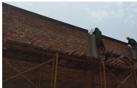
Gambar 3. 12 Pengecoran Balok (Sumber : Dokumentasi Pribadi, 2023)
