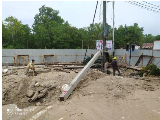
Gambar 3. 2 Pemasangan Mini Pile (Sumber : Dokumentasi Pribadi, 2023)
