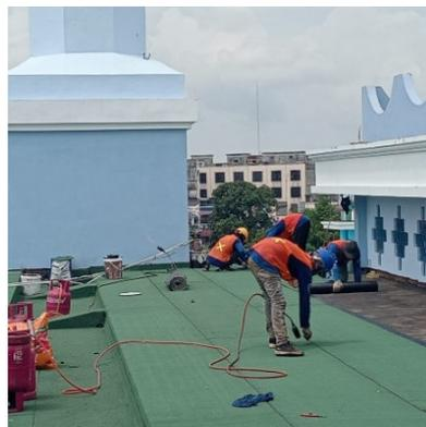
Gambar 3. 115 Pemasangan membran
