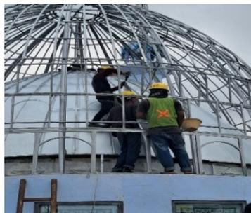
Gambar 3. 103 Memasang kerangka kubah utama
