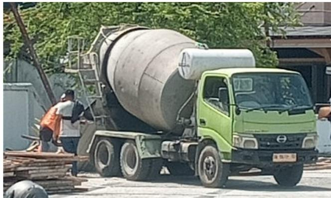
Gambar 3. 60 Menuang mortar dari *truck ready mix*
