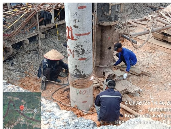
Gambar 3. 8 Penyambungan spun pile
