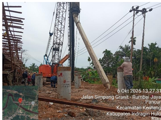
Gambar 3. 6 Pengangkatan dan penegakan spun pile
