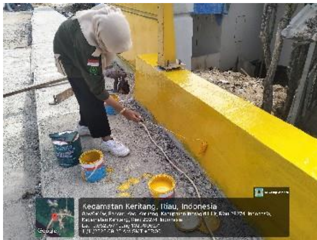
Gambar 3. 90 Parapet dan Loneng
