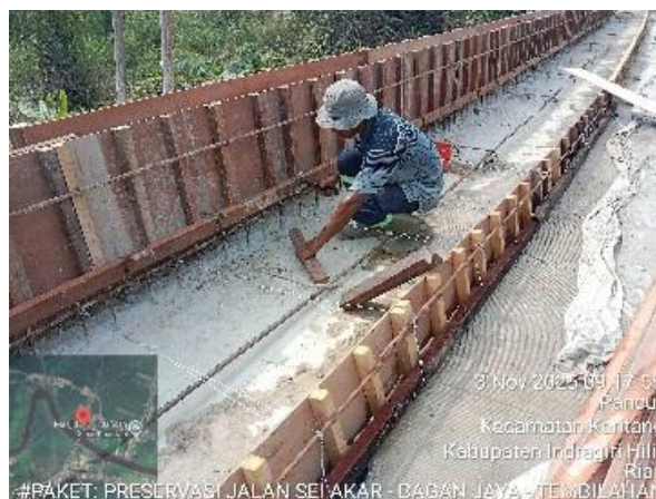
Gambar 3. 65 Pemasangan Bekisting Trotoar
