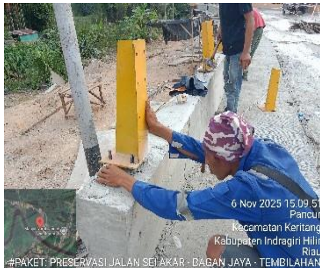
Gambar 3. 82 Pemasangan Dudukan
