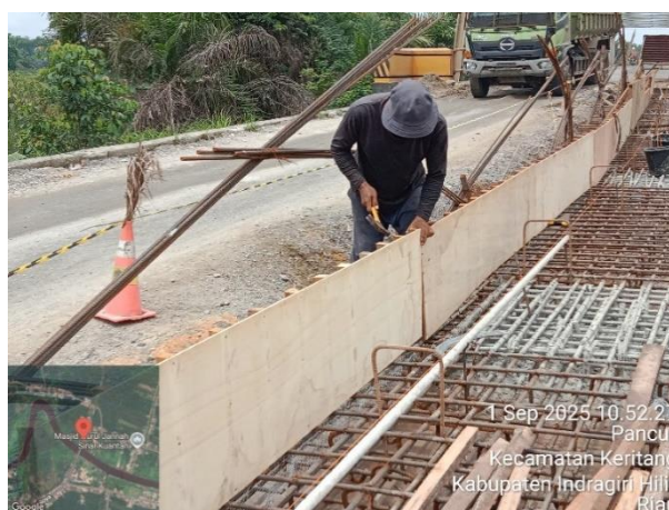
Gambar 3. 54 Pemasangan Perancah
