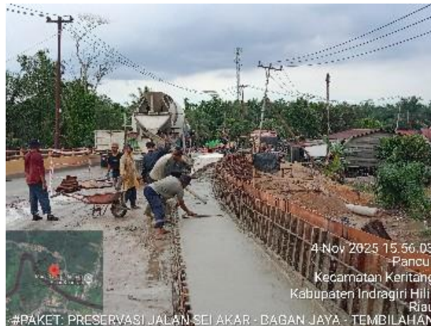
Gambar 3. 66 Pengecoran
