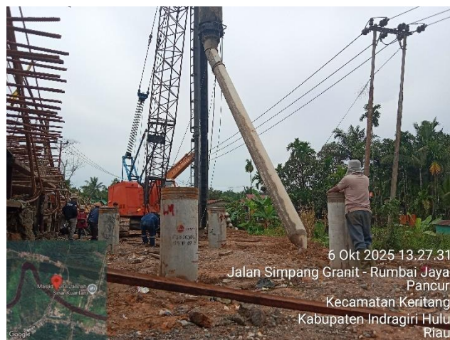
Gambar 3. 33 Pengangkatan dan penegakan spun pile
