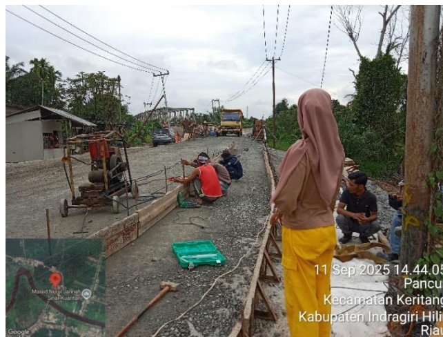
Gambar 3. 87 Pemasangan Bekisting Besi
