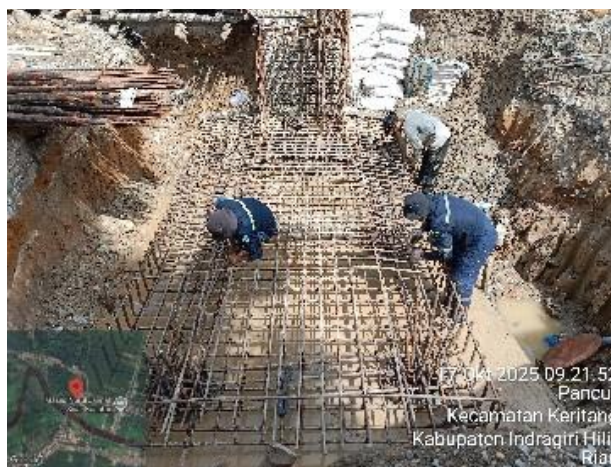
Gambar 3. 45 Pemasangan tulangan abutment
