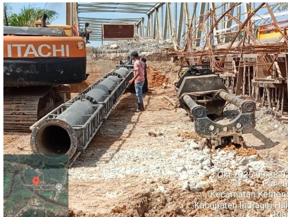
Gambar 3. 31 Pemasangan hammer ke crane
