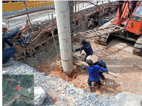
Gambar 3. 34 Proses pemancangan
