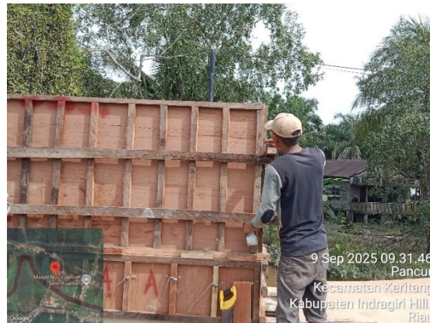
Gambar 3. 77 Pemasangan Bekisting
