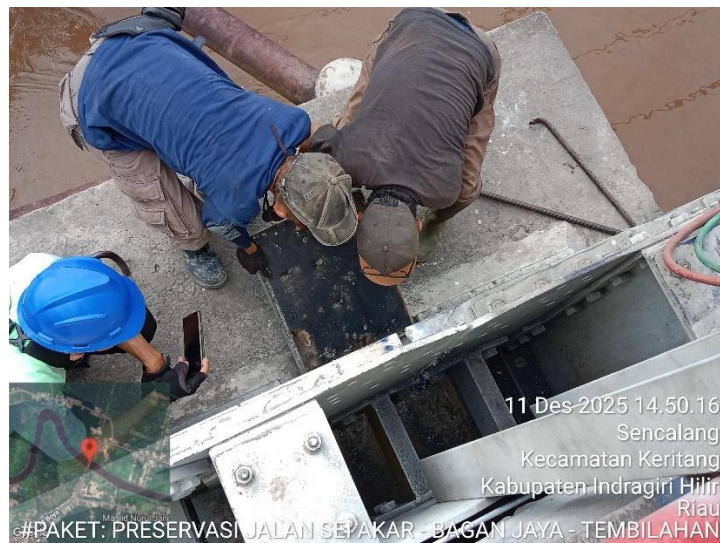
Gambar 3. 96 Pelepasan Bantalan Lama
