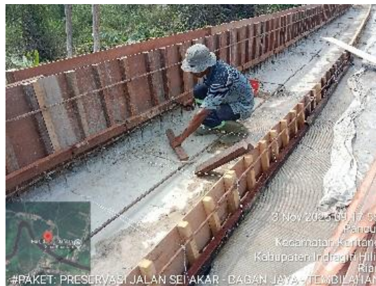
Gambar 3. 70 Pemasangan Bekisting
