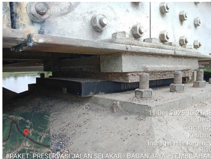
Gambar 3. 97 Pemasangan Elestomer Baru
