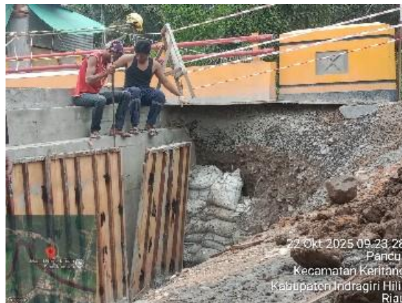
Gambar 3. 48 Pembongkaran Bekisting
