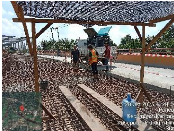
Gambar 3. 55 Pembersihan lokasi pengecoran
