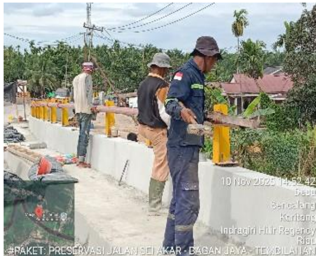
Gambar 3. 83 Pemasangan pipa besi railing
