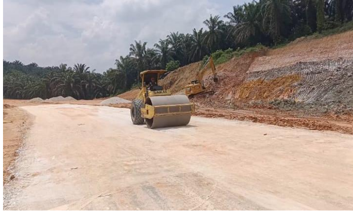
Gambar 3. 19 Pemadatan akhir menggunakan Smooth Roller Sumber: "Dokumentasi pribadi"
