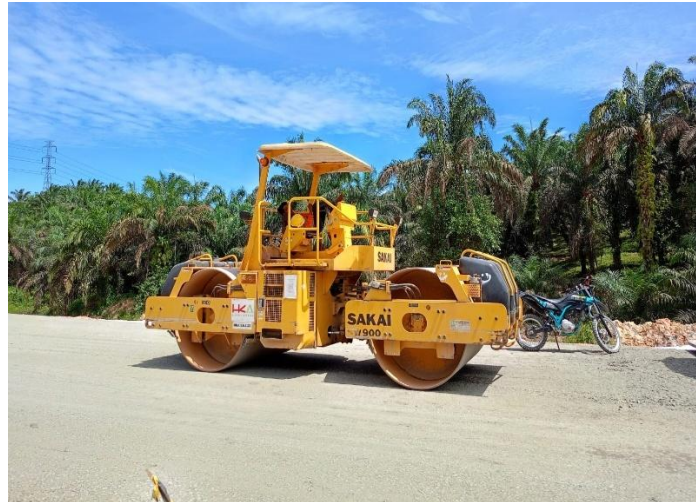
Gambar 3. 48 Pemadatan awal menggunakan Vibratory roller Sumber: "Dokumentasi pribadi"
