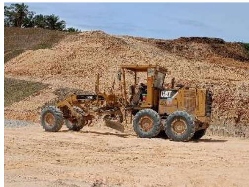
Gambar 3. 29 Motor grader Sumber: "Dokumentasi pribadi"
