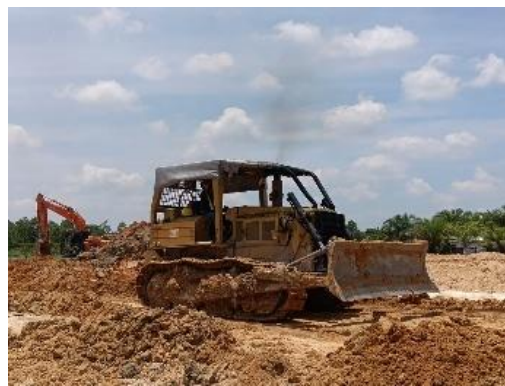
Gambar 3. 11 Bulldozer Sumber: "Dokumentasi pribadi"
