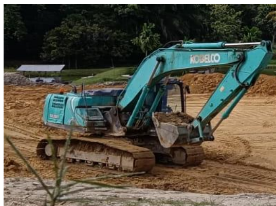
Gambar 3. 27 Excavator Sumber: "Dokumentasi pribadi"
