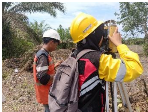
Gambar 3. 7 Stake out Sumber: "Dokumentasi pribadi"
