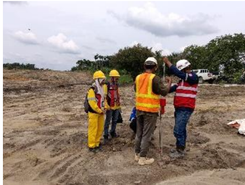
Gambar 3. 17 Pengujian Dynamic Cone Penetrometer Sumber: "Dokumentasi pribadi"
