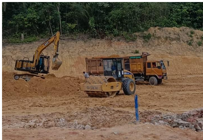
Gambar 3. 18 Pemadatan awal menggunakan Sheep Foot Roller Sumber: "Dokumentasi pribadi"
