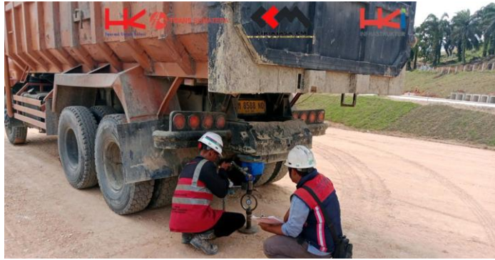
Gambar 3. 25 Pengujian proofrolling Sumber: “Dokumentasi PT Ciriayasa Cipta Mandiri”
