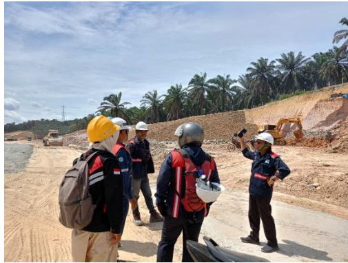
Gambar 3. 46 Pengecekan lokasi pekerjaan lapis sirtu b. Sumber: "Dokumentasi pribadi"
