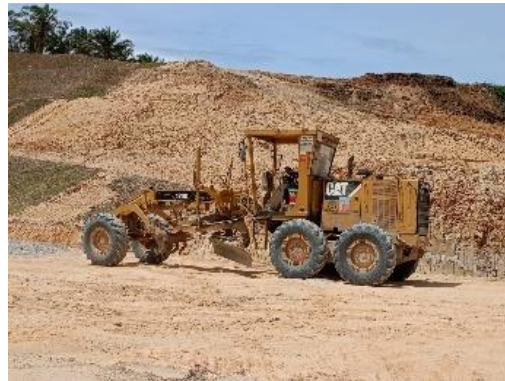
Gambar 3. 13 Motor grader Sumber: "Dokumentasi pribadi"
