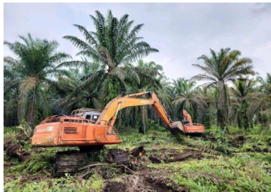
Gambar 3. 10 Excavator Sumber: “Dokumentasi pribadi”
