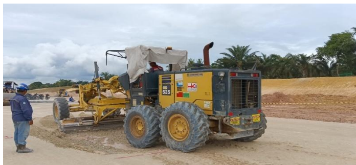
Gambar 3. 34 Penghampan lapis separator Sumber: "Dokumentasi pribadi"
