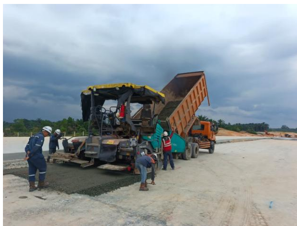
Gambar 3. 51 Penghamparan lapis pondasi agregat Sumber: "Dokumentasi lapangan"
