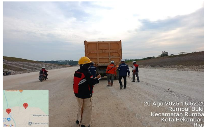
Gambar 3. 24 Pengujian proofrolling Sumber: "Dokumentasi pribadi"
