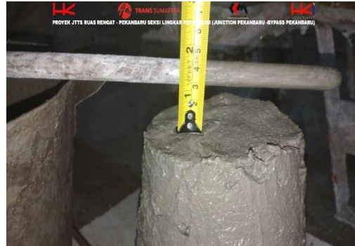
Gambar 3. 61 Uji slump Sumber: "Dokumentasi lapangan"
