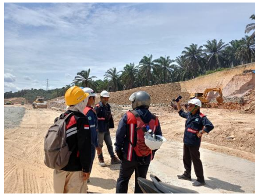
Gambar 3. 32 Pengecekan lokasi pekerjaan lapis sirtu Sumber: "Dokumentasi pribadi"
