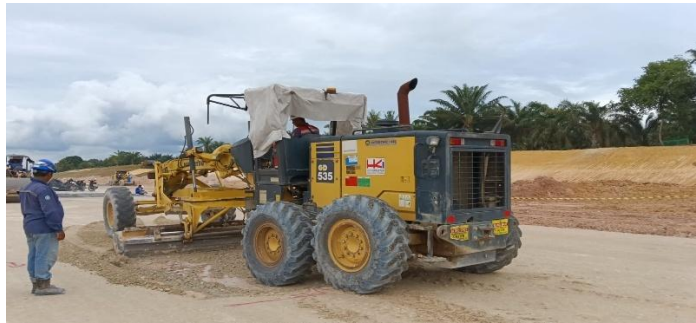
Gambar 3. 47 Penghamparan lapis separator Sumber: "Dokumentasi pribadi"
