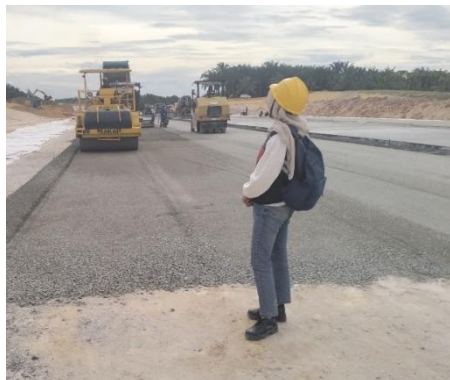
Gambar 3. 53 pemadatan akhir menggunakan PTR Sumber: “Dokumentasi rekan lapangan”
