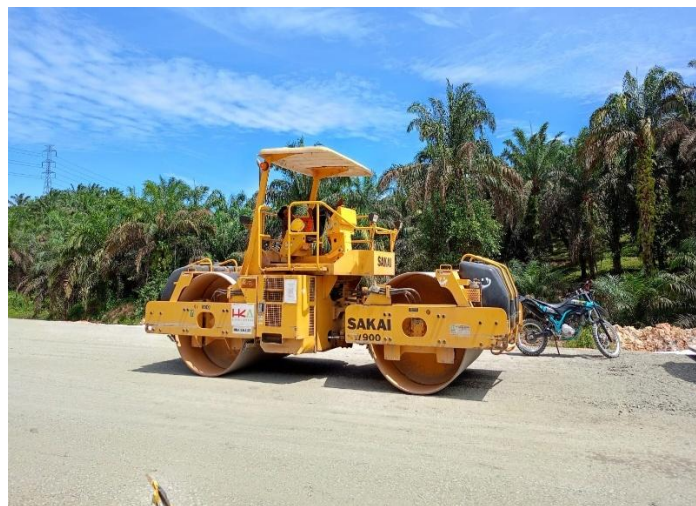
Gambar 3. 35 Pemadatan awal menggunakan Vibratory roller Sumber: "Dokumentasi pribadi"
