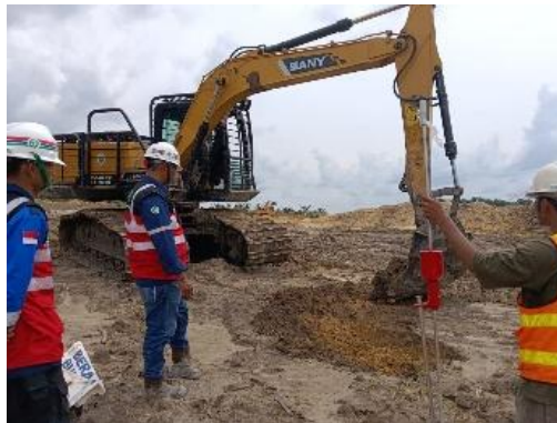
Gambar 3. 16 Test pit Sumber: "Dokumentasi pribadi"
