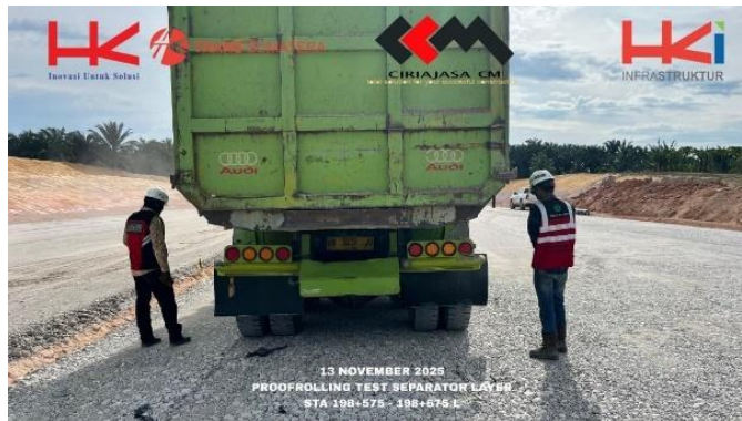
Gambar 3. 56 Proofrolling tes Sumber: “Dokumentasi lapangan”
