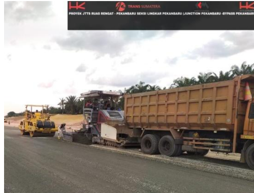
Gambar 3. 52 Pemadatan Awal menggunakan (Vibratory Roller) Sumber: “Dokumentasi lapangan”
