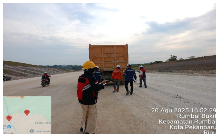
Gambar 3. 44 Pengujian proofrolling Sumber: "Dokumentasi pribadi"
