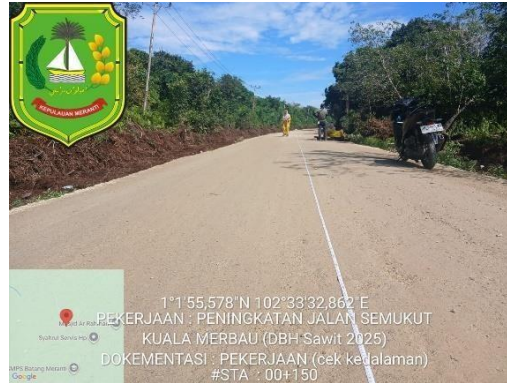
Gambar 3. 28. Ukuran Panjang setiap 25 meter per sta
