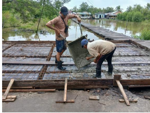
Gambar 3. 8313. Perkerjaan pengecoran balok
