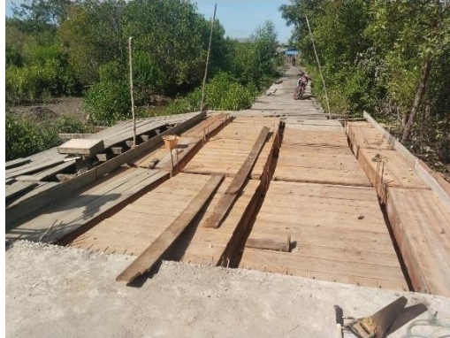
Gambar 3. 79. Pekerjaan pembuatan cetakan plat lantai
