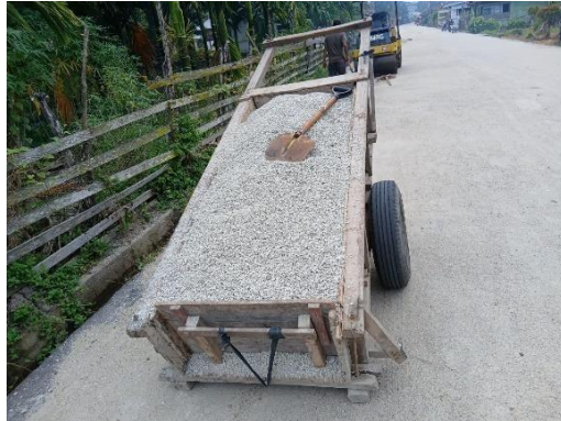
Gambar 3. 50 Mobilisasi agregat kasar dan halus
