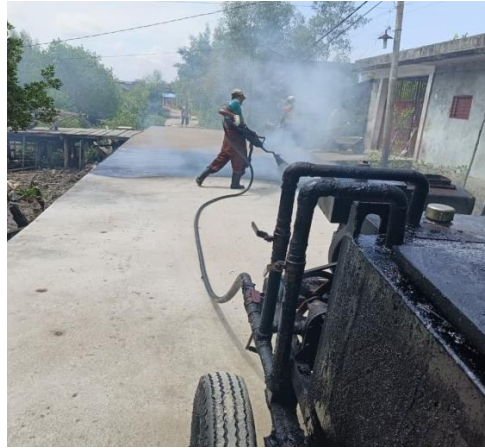
Gambar 3. 85. Perkerjaan penyiraman aspal dan penghamparan agregat halus
