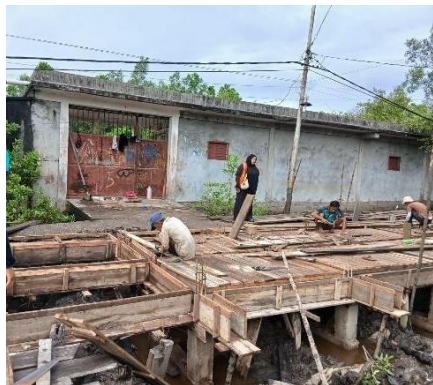
Gambar 3. 78. Pekerjaan pembuatan cetakan balok
