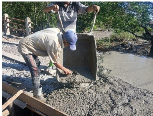
Gambar 3. 84. Perkerjaan pengecoran plat lantai
