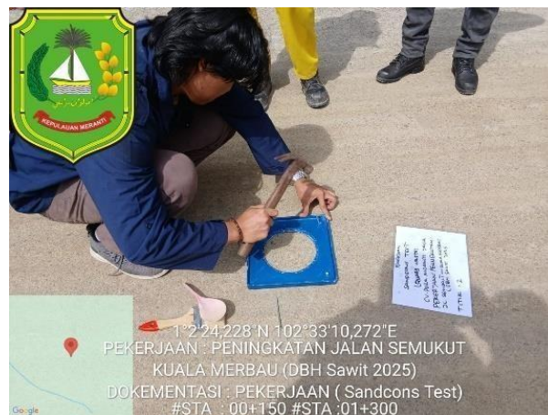
Gambar 3. 23. Pemasangan pelat dasar
