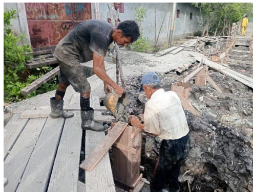
Gambar 3. 76. Pekerjaan pengecoran kolom
