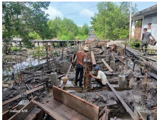
Gambar 3. 77. Pekerjaan pemasangan cetakan dan pengecoran sisa kolom
