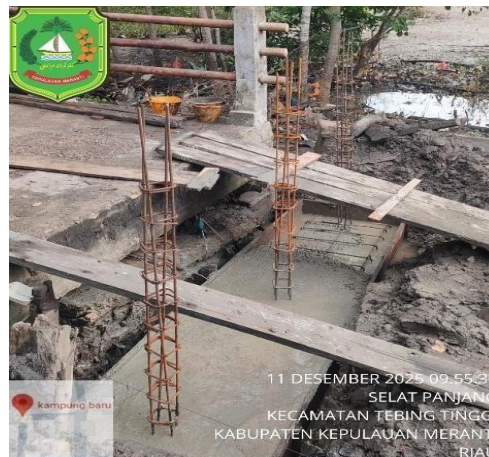
Gambar 3. 74. Pekerjaan pemasangan tulangan pondasi
