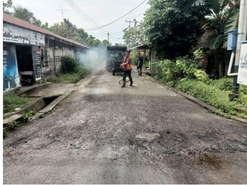
Gambar 3. 71. Pembersihan Permukaan Jalan dan penyiraman Tack Coat.
