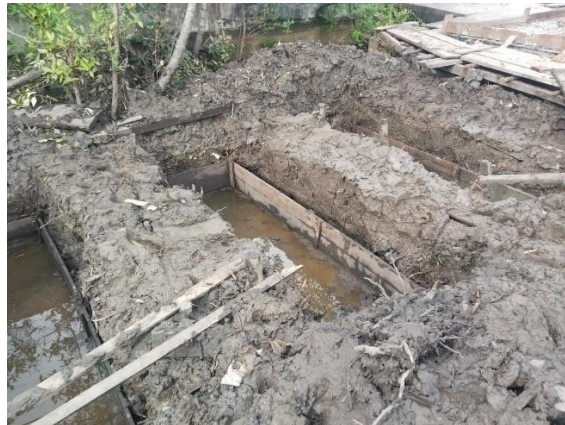
Gambar 3. 72. Pekerjaan penggalian pondasi
