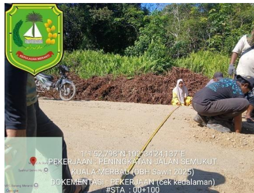
Gambar 3. 29. Ukuran lebar jalan tersebut setiap 25 meter per sta
