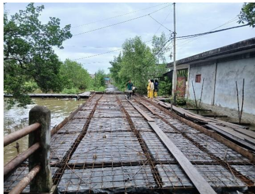
Gambar 3. 82. Perkerjaan pemasangan wiremesh
