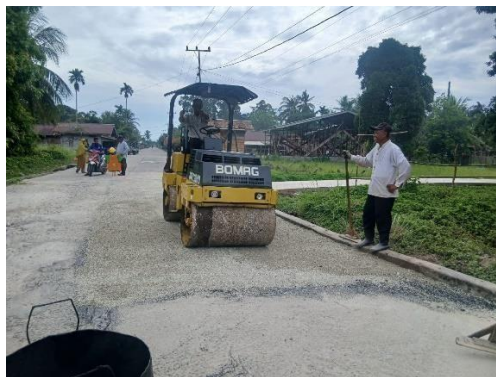
Gambar 3. 49 Pemadatan agregat kasar
