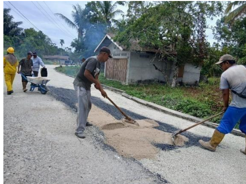
Gambar 3. 52 Penghamparan agregat halus
