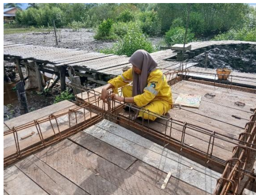
Gambar 3. 80. Pekerjaan pemasangan tulangan balok
