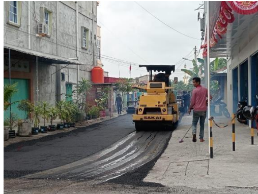
Gambar 3. 10.Pemadatan Lapisan Aspal
