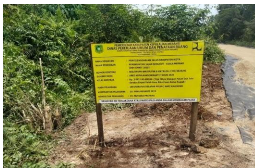
Gambar 3. 11 Pemasangan papan proyek/rambu informasi
