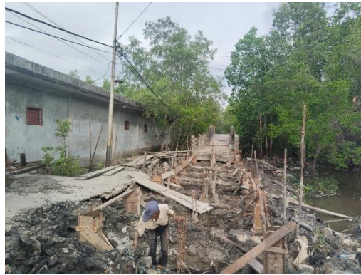
Gambar 3. 75. Pekerjaan pembuatan cetakan kolom
