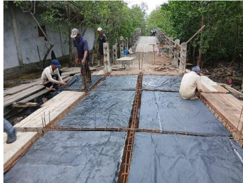
Gambar 3. 81. Perkerjaan pemasangan plastik cor
