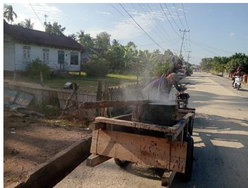
Gambar 3. 45.Pekerjaan mobilisasi material kelokasi proyek
