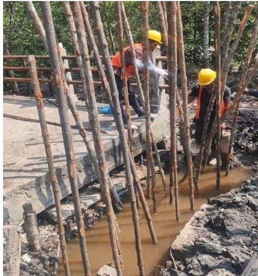
Gambar 3. 73. Perkerjaan pemasangan cerucuk
