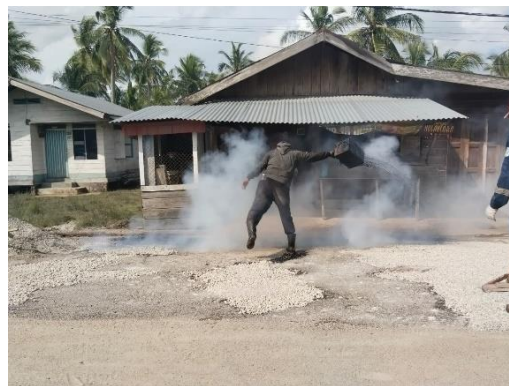
Gambar 3. 47 Penyiraman aspal pertama
