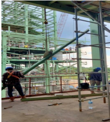
Gambar 3.18 pemasangan bracing
