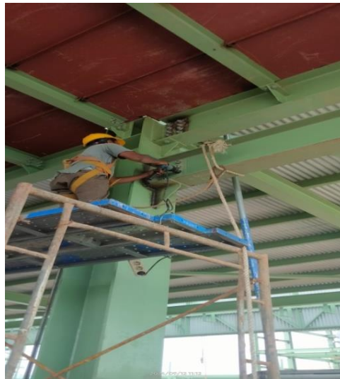
Gambar 3.8 melengkapi baut dan impact baut Boit Thigkning
