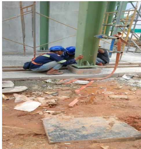
Gambar 3.5 setting elevasi bawah plat kolom
