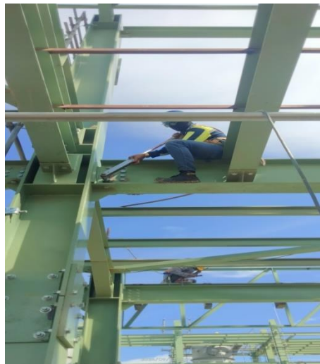
Gambar 3.10 impact baut dan torsi
