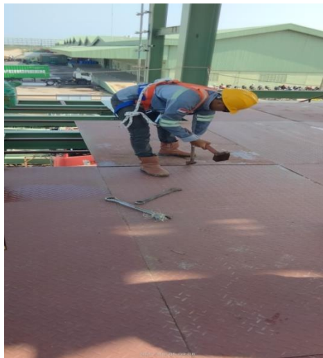
Gambar 3.14 pemasangan ceker plate
