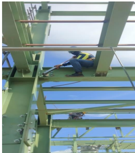
Gambar 3.10 impact baut dan torsi
