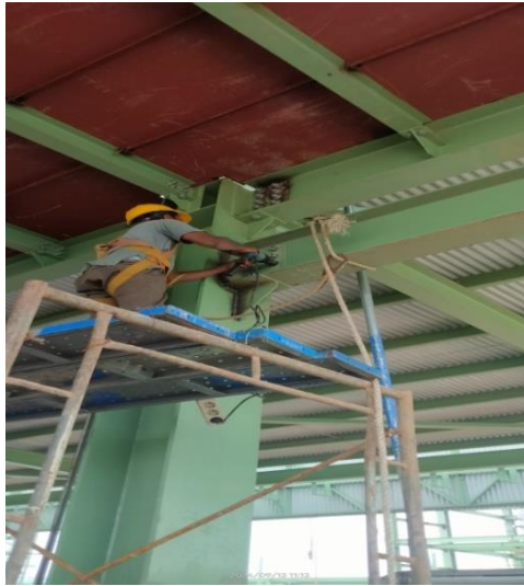
Gambar 3.8 melengkapi baut dan impact baut Boit Thigkning
