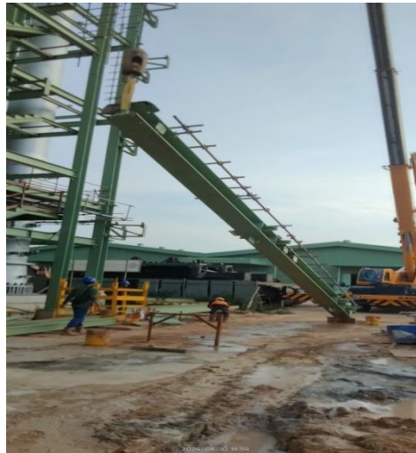
Gambar 3.6 erection kolom sambungan pertama
