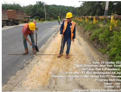
Gambar 3. 100 Opname pada area yang sudah di kupas (Sumber Dokumentasi Lapangan 2025)
