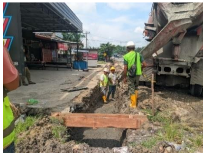
Gambar 3. 74 Pengecoran LC (Sumber Dokumentasi Lapangan 2025)
