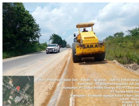
Gambar 3. 103 Pemadatan agregat Kelas S menggunakan alat vibratory roller (Sumber Dokumentasi Lapangan 2025)
