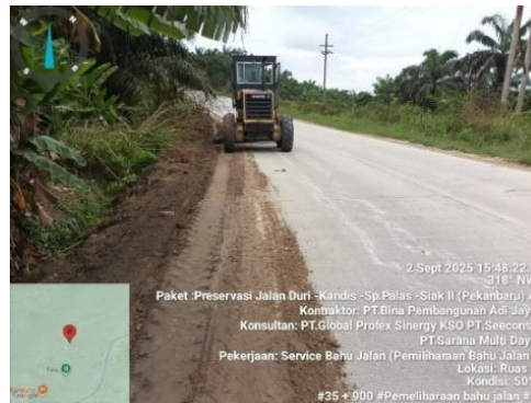
Gambar 3. 5 Pembersihan Bahu Jalan Menggunakan motor grader (Sumber Dokumentasi Lapangan 2025)
