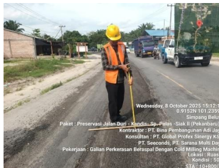
Gambar 3. 67 Mengukur Kedalaman Setelah Dikupas (Sumber Dokumentasi Lapangan 2025)
