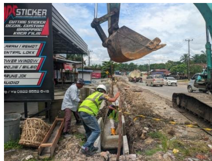
Gambar 3. 78 Pemasangan U Ditch tipe DS 3 (Sumber Dokumentasi Lapangan 2025)
