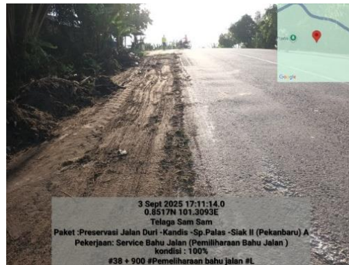
Gambar 3. 8 Tampak kondisi Bahu Jalan Setelah Bersih (Sumber Dokumentasi Lapangan 2025)
