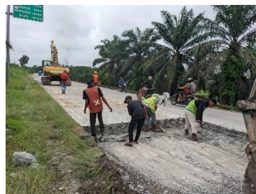
Gambar 3. 32 Pembersihan Bekas Galian Beton (Sumber Dokumentasi Lapangan 2025)
