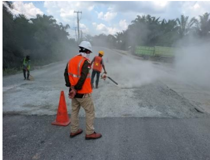
Gambar 3. 22 Compressor Permukaan Jalan (Sumber Dokumentasi Lapangan 2025)
