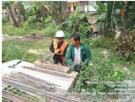
Gambar 3. 83 Memotong dan membengkokkan besi tulangan ( Sumber Dokumentasi Lapangan 2025 )
