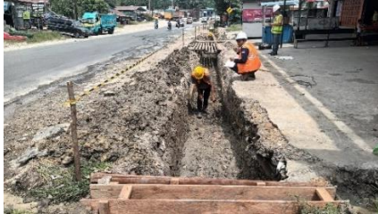
Gambar 3. 72 Membersihkan dasar galian (Sumber Dokumentasi Lapangan 2025)
