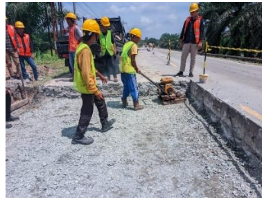
Gambar 3. 35 Pemadatan menggunakan Hand stamper (Sumber Dokumentasi Lapangan 2025)
