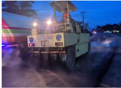
Gambar 3. 27 Pemadatan Akhir (Sumber Dokumentasi Lapangan 2025)
