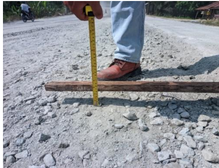
Gambar 3. 21 Opname Setelah Dikupas (Sumber Dokumentasi Lapangan 2025)
