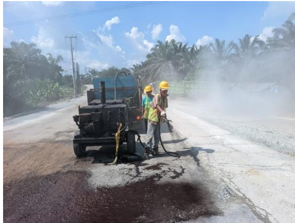
Gambar 4. 1 Penyemprotan Lapis Resap (prime coat) (Sumber Dokumentasi Lapangan 2025)
