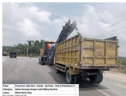
Gambar 3. 64 Galian beraspal dengan menggunakan alat cold milling machine (Sumber Dokumentasi Lapangan 2025)
