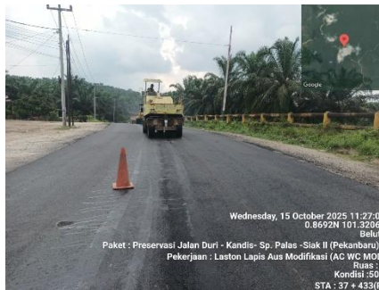
Gambar 3. 95 Pemadatan akhir aspal Menggunakan pneumatic tire roller (Sumber Dokumentasi Lapangan 2025)
