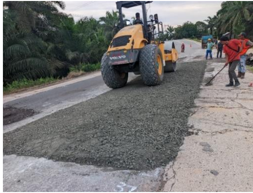
Gambar 3. 17 Pemadatan Agregat Kelas A (Sumber Dokumentasi Lapangan 2025)
