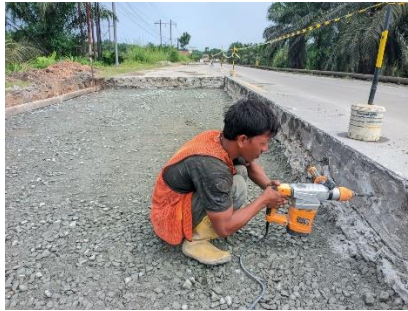
Gambar 3. 42 Pemasangan Tiebar (Sumber Dokumentasi Lapangan 2025)
