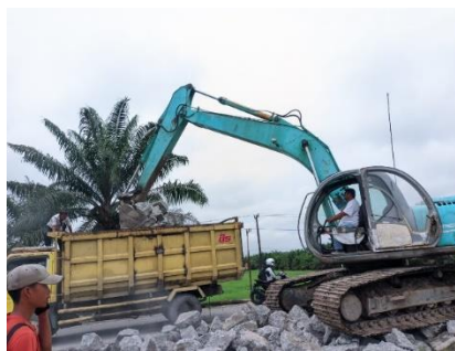
Gambar 3. 31 Pengangkutan material bongkaran beton (Sumber Dokumentasi Lapangan 2025)
