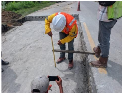
Gambar 3. 33 Opname Galian Beton (Sumber Dokumentasi Lapangan 2025)
