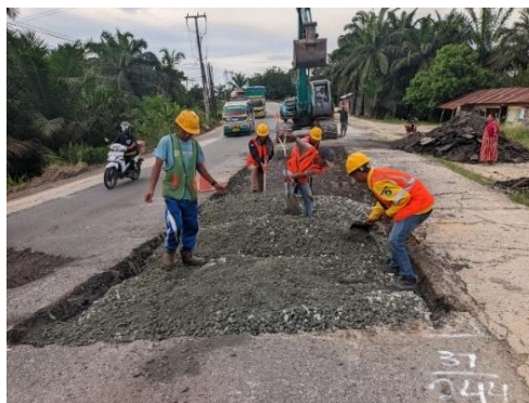
Gambar 3. 16 Meratakan Agregat Menggunakan Sekop (Sumber Dokumentasi Lapangan 2025)
