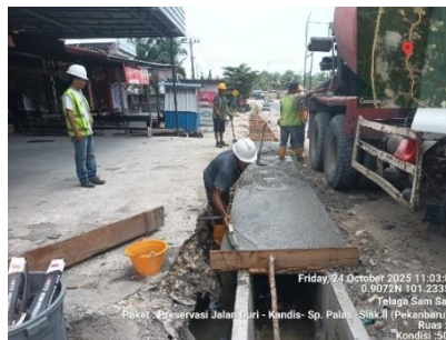
Gambar 3. 86 Meratakan Permukaan Beton (Sumber Dokumentasi Lapangan 2025)
