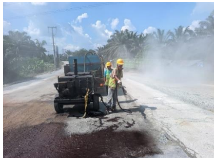
Gambar 3. 23 Penyemprotan Prime Coat (Sumber Dokumentasi Lapangan 2025)
