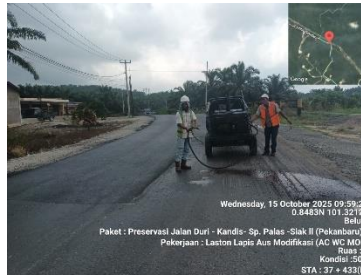
Gambar 3. 91 Penyemprotan Tack Coat (Sumber Dokumentasi Lapangan 2025)
