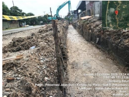
Gambar 3. 77 Memasang patok kayu (Sumber Dokumentasi Lapangan 2025)
