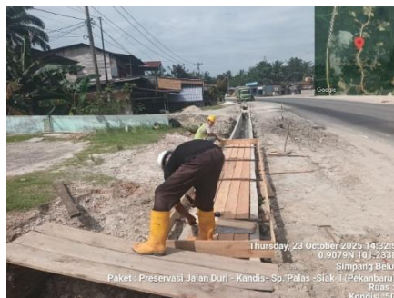
Gambar 3. 82 Pemasangan bekisting kayu (Sumber Dokumentasi Lapangan 2025)
