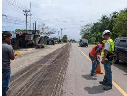
Gambar 3. 66 Pembersihan area hasil milling (Sumber Dokumentasi Lapangan 2025)
