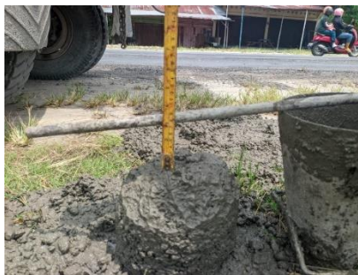
Gambar 3. 73 uji slump Test (Sumber Dokumentasi Lapangan 2025)
