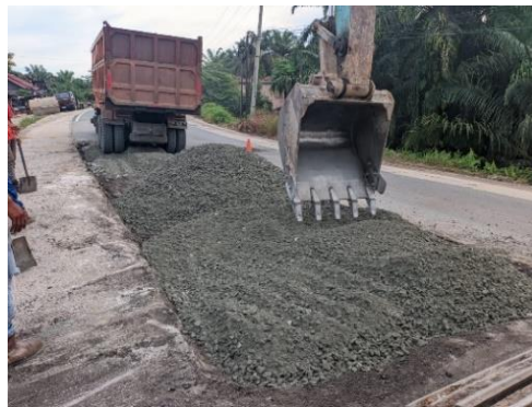
Gambar 3. 15 Meratakan Agregat Menggunakan Excavator (Sumber Dokumentasi Lapangan 2025)
