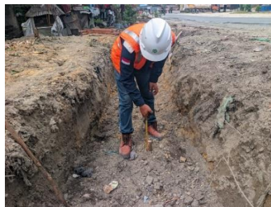
Gambar 3. 71 Pemasangan benang pada kayu (Sumber Dokumentasi Lapangan 2025)
