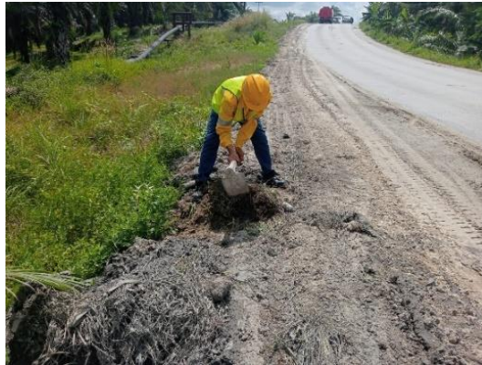
Gambar 3. 7 Pembuatan Saluran Air (Sumber Dokumentasi Lapangan 2025)
