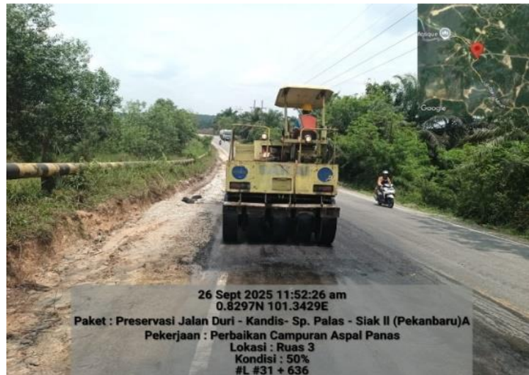
Gambar 4. 5 Proses Pemadatan Akhir Menggunakan pneumatic tired roller (Sumber Dokumentasi Lapangan 2025)
