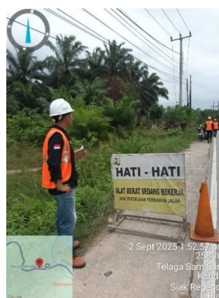
Gambar 3.97 Memasang rambu-rambu peringatan (Sumber Dokumentasi Lapangan 2025)
