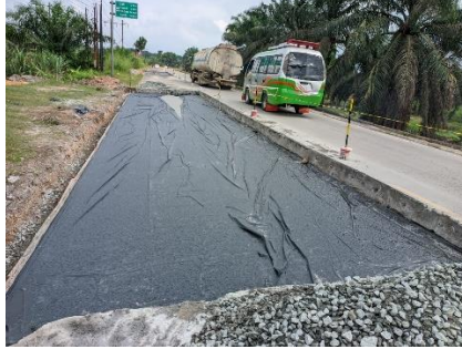
Gambar 3. 40 Pemasangan plastik beton (Sumber Dokumentasi Lapangan 2025)
