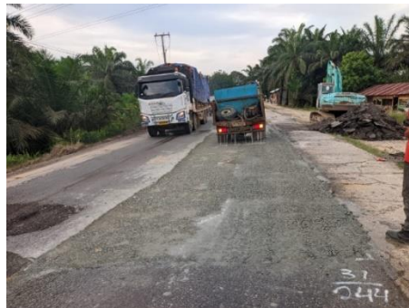
Gambar 3. 18 Penyiraman Agregat (Sumber Dokumentasi Lapangan 2025)
