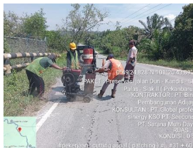
Gambar 3. 53 Pemotongan Batas Galian ( Cutting ) (Sumber Dokumentasi Lapangan 2025)
