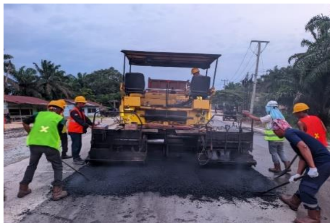
Gambar 4. 2 Penghamparan dengan Asphalt Finisher (Sumber Dokumentasi Lapangan 2025)
