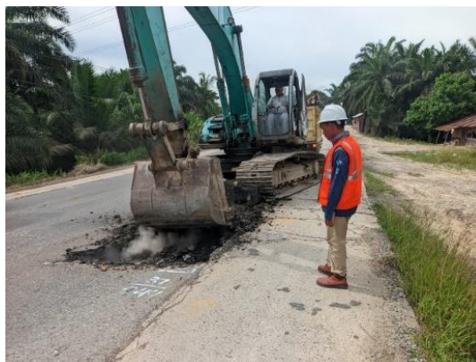
Gambar 3. 11 Membongkar lapisan aspal (Sumber Dokumentasi Lapangan 2025)
