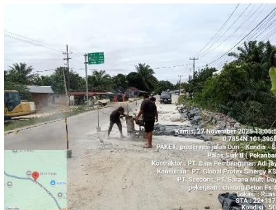
Gambar 3. 29 Cutting (Pemotongan Beton) (Sumber Dokumentasi Lapangan 2025)
