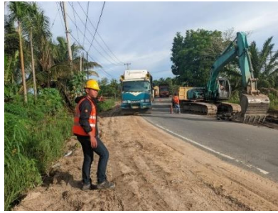
Gambar 3. 63 Menempatkan Flagman (Sumber Dokumentasi Lapangan 2025)
