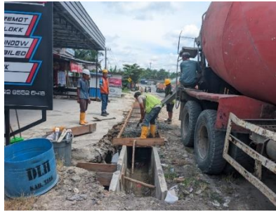
Gambar 3. 85 Pengecoran Beton Pelat Jalan Masuk (Sumber Dokumentasi Lapangan 2025)
