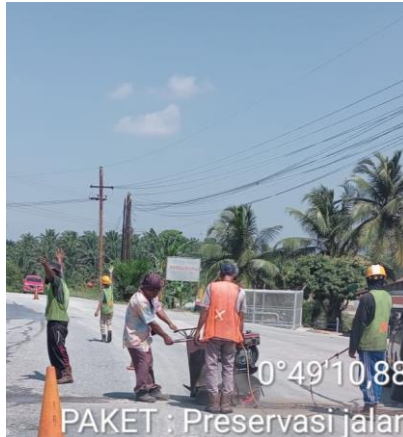
Gambar 3. 10 Cutting Aspal (Sumber Dokumentasi Lapangan 2025)
