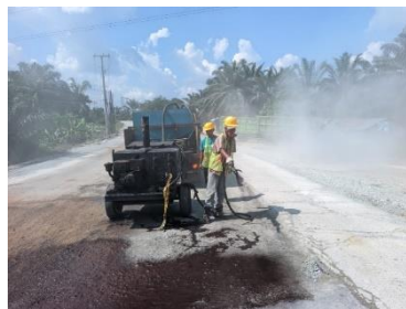
Gambar 3. 56 Penyemprotan Tack Coat (Sumber Dokumentasi Lapangan 2025)
