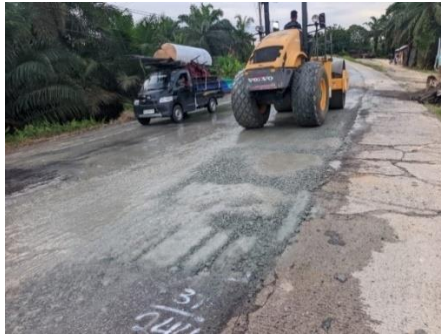
Gambar 3. 19 Pemadatan yang Kedua Agregat Kelas A (Sumber Dokumentasi Lapangan 2025)
