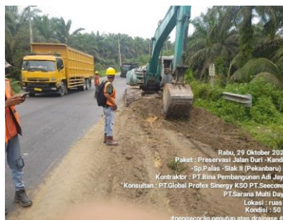
Gambar 3. 99 Memindahkan ke luar dari bahu jalan (Sumber Dokumentasi Lapangan 2025)
