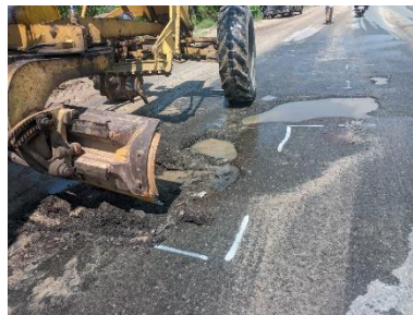
Gambar 3. 51 Memberikan tanda ( marking ) (Sumber Dokumentasi Lapangan 2025)
