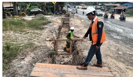
Gambar 3. 70 Pemasangan patok Kayu (Sumber Dokumentasi Lapangan 2025)
