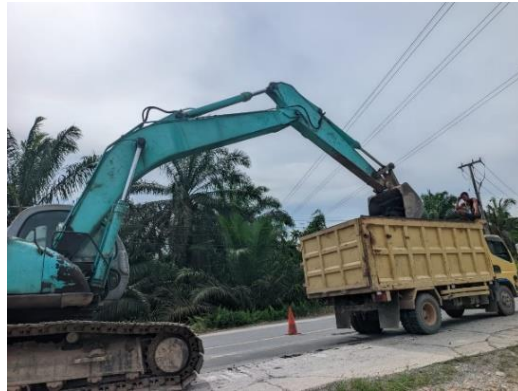
Gambar 3. 12 Mengangkut Material ke Dump Truck (Sumber Dokumentasi Lapangan 2025)
