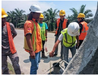
Gambar 3. 37 Slump Test LC (Sumber Dokumentasi Lapangan 2025)
