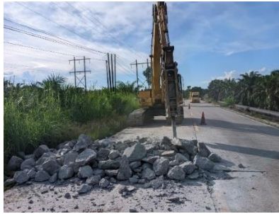
Gambar 3. 30 Pembongkaran / Galian Perkerasan Rigid (Sumber Dokumentasi Lapangan 2025)
