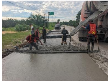
Gambar 3. 45 Meratakan Beton (Sumber Dokumentasi Lapangan 2025)
