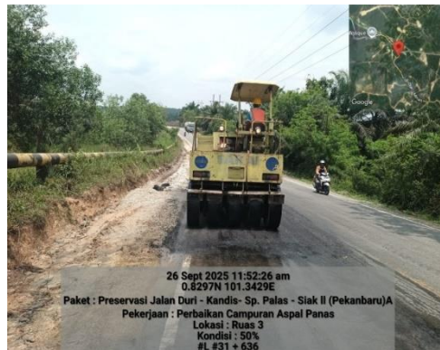
Gambar 3. 60 Pemadatan Menggunakan Roda Karet (Sumber Dokumentasi Lapangan 2025)
