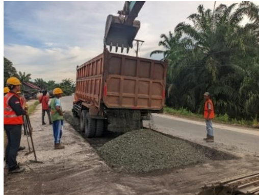
Gambar 3. 14 Penghamparan Material Agregat (Sumber Dokumentasi Lapangan 2025)
