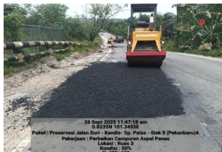
Gambar 3. 59 Pemadatan Menggunakan Roda Baja (Sumber Dokumentasi Lapangan 2025)
