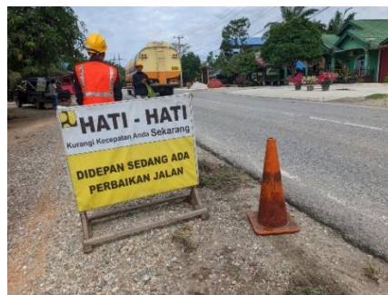
Gambar 3. 52 Menempatkan rambu-rambu peringatan (Sumber Dokumentasi Lapangan 2025)
