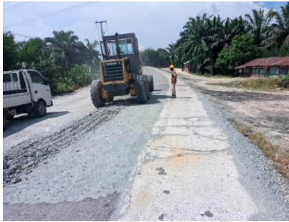
Gambar 3. 20 Pengupasan Agregat Kelas A (Sumber Dokumentasi Lapangan 2025)
