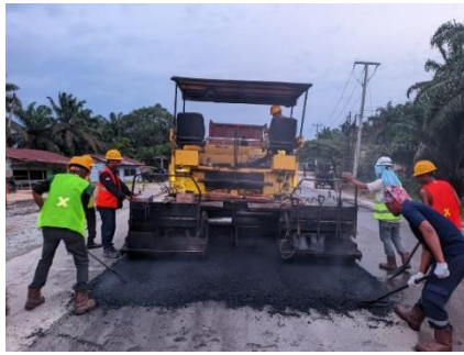
Gambar 3. 25 Penghamparan aspal dan diratakan (Sumber Dokumentasi Lapangan 2025)
