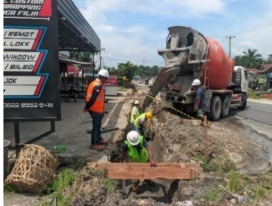
Gambar 3. 75 Meratakan LC menggunakan cangkul, raskam kayu (Sumber Dokumentasi Lapangan 2025)
