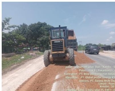
Gambar 3. 101 Penghamparan material agregat kelas S (Sumber Dokumentasi Lapangan 2025)
