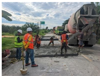
Gambar 3. 44 Penuangan beton rigid Fs 45 (Sumber Dokumentasi Lapangan 2025)
