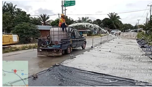
Gambar 3. 47 penyiraman beton (Sumber Dokumentasi Lapangan 2025)
