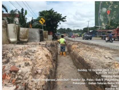
Gambar 3. 76 Membersihkan LC nya terlebih dahulu (Sumber Dokumentasi Lapangan 2025)
