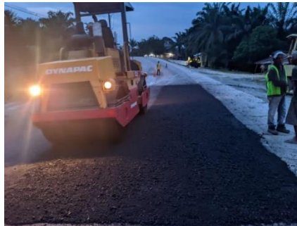
Gambar 3. 26 Pemadatan Awal (Sumber Dokumentasi Lapangan 2025)
