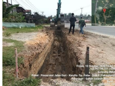
Gambar 3. 69 Galian Saluran Menggunakan Excavator (Sumber Dokumentasi Lapangan 2025)
