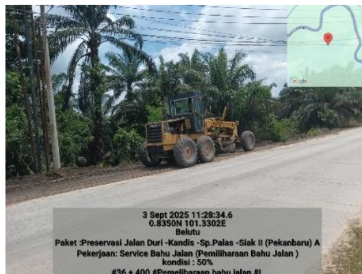
Gambar 3. 6 Pembuangan material keluar bahu Jalan (Sumber Dokumentasi Lapangan 2025)
