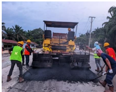
Gambar 3. 58 Penghamparan aspal dan diratakan (Sumber Dokumentasi Lapangan 2025)
