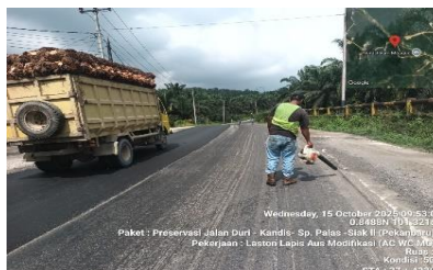
Gambar 3.90 Membersihkan Permukaan Jalan (Sumber Dokumentasi Lapangan 2025)
