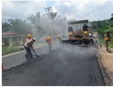
Gambar 3. 93 Meratakan Permukaan Aspal AC-WC (Sumber Dokumentasi Lapangan 2025)
