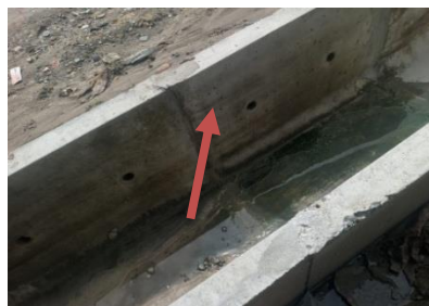
Gambar 3. 79 Penyambungan / Jointing U-Ditch . (Sumber Dokumentasi Lapangan 2025)
