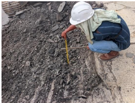
Gambar 3. 13 Opname kedalaman galian (Sumber Dokumentasi Lapangan 2025)
