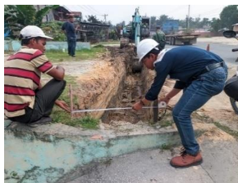
Gambar 3. 68 Pemasangan patok dan benang (Sumber Dokumentasi Lapangan 2025)
