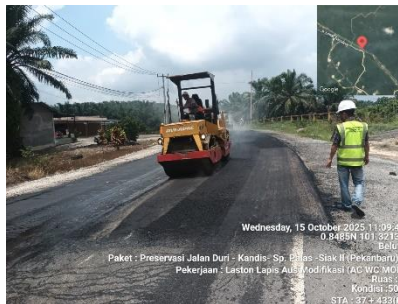
Gambar 3. 94 Pemadatan awal aspal Menggunakan Tandem Roller (Sumber Dokumentasi Lapangan 2025)
