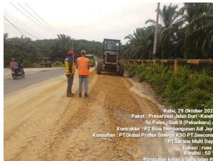
Gambar 3. 102 Meratakan agregat Kelas S (Sumber Dokumentasi Lapangan 2025)
