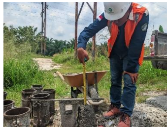
Gambar 3. 43 Slump Test Beton Fs 45 (Sumber Dokumentasi Lapangan 2025)
