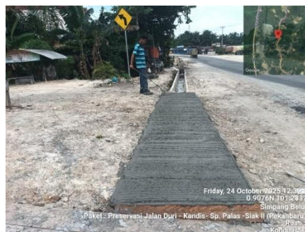
Gambar 3. 87 Menggroving plat jalan masuk (Sumber Dokumentasi Lapangan 2025)
