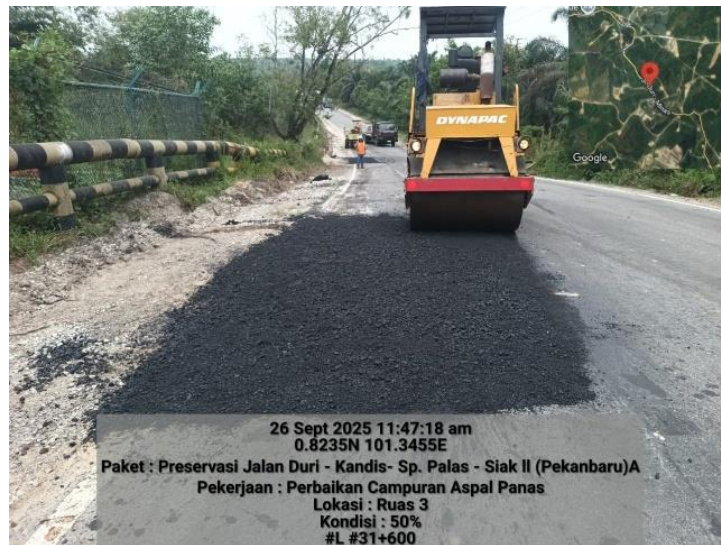
Gambar 4. 4 Proses Pemadatan Awal Menggunakan Tandem Roller (Sumber Dokumentasi Lapangan 2025)
