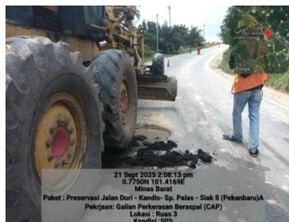
Gambar 3. 54 Pengupasan Lapisan Aspal (Sumber Dokumentasi Lapangan 2025)
