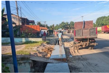
Gambar 3. 88 Perawatan Beton ( Curing ) ( Sumber Dokumentasi Lapangan 2025 )
