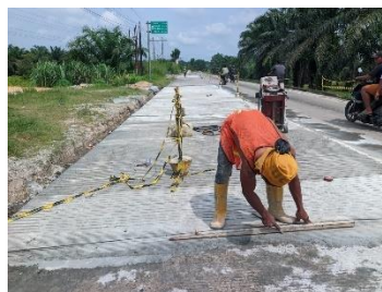
Gambar 3. 46 Menggrooving Beton (Sumber Dokumentasi Lapangan 2025)
