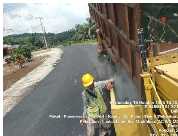
Gambar 3. 92 Menuangkan campuran aspal AC-WC ke asphalt Finisher (Sumber Dokumentasi Lapangan 2025)
