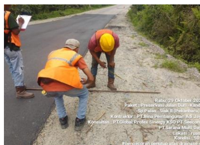
Gambar 3.96 Pengecekan kondisi lokasi bahu jalan (Sumber Dokumentasi Lapangan 2025)
