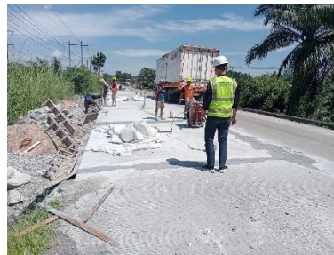
Gambar 3. 48 Cutting Beton (Sumber Dokumentasi Lapangan 2025)
