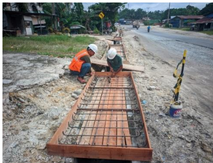
Gambar 3. 84 Pemasangan Tulangan ( Reinforcement ) ( Sumber Dokumentasi Lapangan 2025 )
