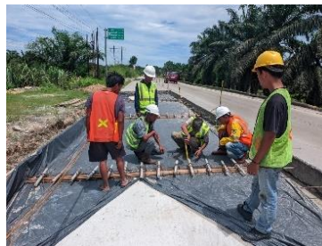
Gambar 3. 41 Pemasangan dowel bar (Sumber Dokumentasi Lapangan 2025)
