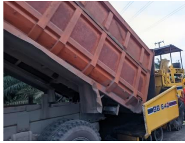
Gambar 3. 57 Menuangkan campuran aspal panas (Sumber Dokumentasi Lapangan 2025)
