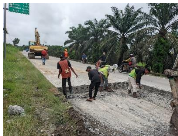
Gambar 3. 34 Opname Panjang dan Lebar Galian (Sumber Dokumentasi Lapangan 2025)
