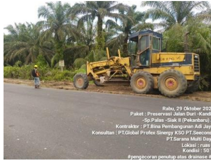
Gambar 3. 98 Membersihkan area bahu jalan ( Clearing ) (Sumber Dokumentasi Lapangan 2025)
