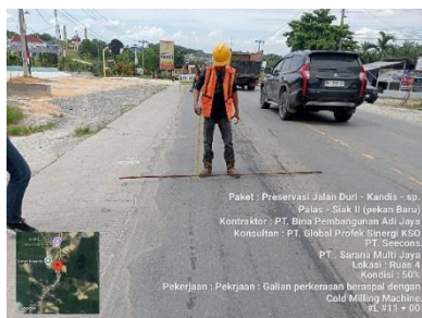
Gambar 3. 62 Menentukan kedalaman pengupasan (Sumber Dokumentasi Lapangan 2025)
