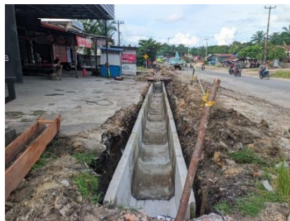
Gambar 3. 81 Pemeriksaan Saluran U-Ditch (Sumber Dokumentasi Lapangan 2025)
