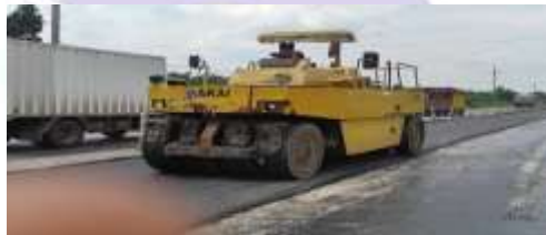
Gambar 3.16 (Pekerjaan Pemaparan Akhir)
