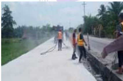
Gambar 3.10 (Pekerjaan Pembersihan Lahan)
