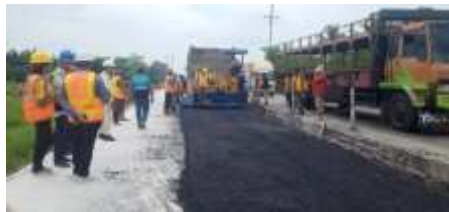
Gambar 3.13 (Pekerjaan Pemaparan AC - WC)
