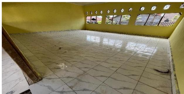
Gambar 3. 44 Pemasangan Plint Keramik
