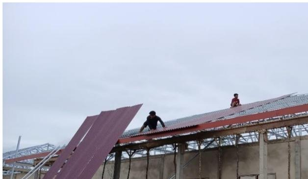
Gambar 3. 53 Pemasangan Atap Long Spandek
