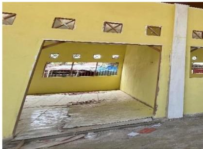
Gambar 3. 38 Pemasangan Ventilasi Pintu
