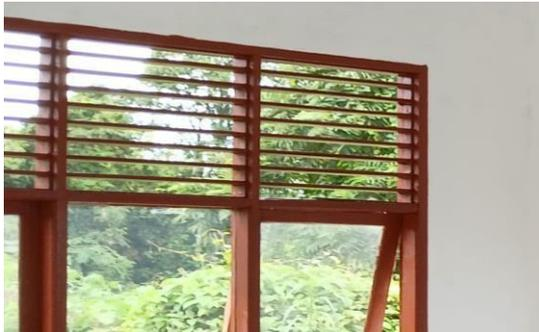
Gambar 3. 40 Pemasangan Ventilasi Pintu
