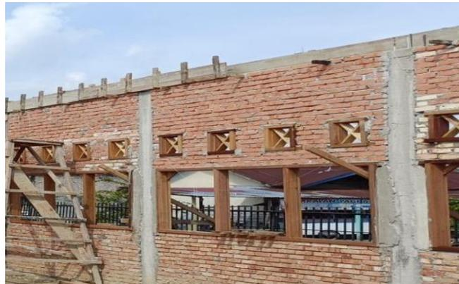
Gambar 3. 22 Pemasangan Bekisting Balok
