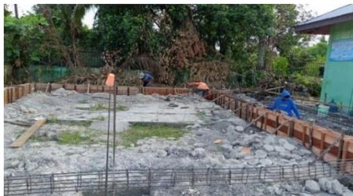
Gambar 3. 13 Pemasangan Bekisting Sloof
