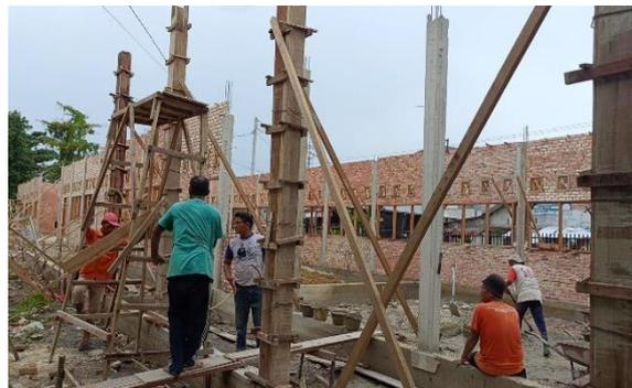
Gambar 3. 20 Pemasangan Bekisting Kolom Praktis
