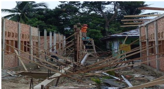
Gambar 3. 21 Pengecoran Kolom Praktis
