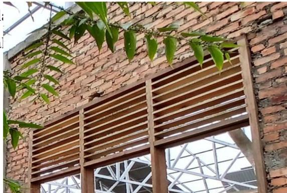
Gambar 3. 39 Pemasangan Ventilasi Pintu
