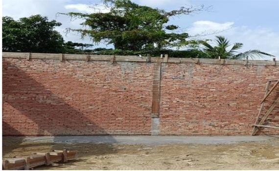
Gambar 3. 24 Pengecoran Balok
