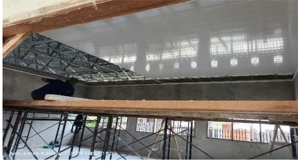
Gambar 3. 57 Pemasangan Plavon PVC
