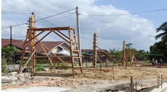
Gambar 3. 18 Pengecoran Kolom
