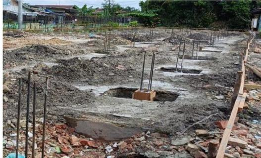
Gambar 3. 10 Pemasangan Bekisting Kolom Pedestal
