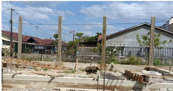
Gambar 3. 19 Pembongkaran Bekisting Kolom
