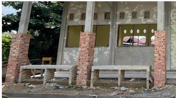
Gambar 3. 50 Pengecoran Tempat Duduk
