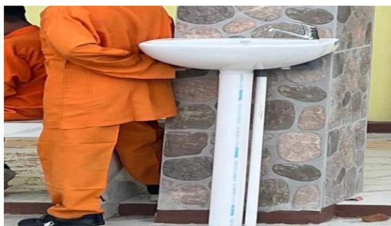
Gambar 3. 76 Pemasangan Tempat Cuci Tangan
