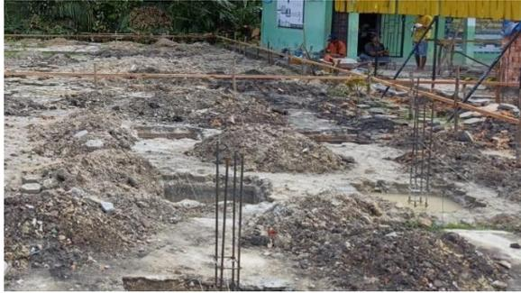
Gambar 3. 6 Pengecoran Pondasi Setempat
