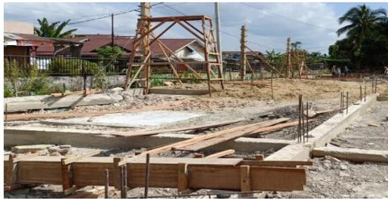
Gambar 3. 16 Pemasangan Bekisting Kolom
