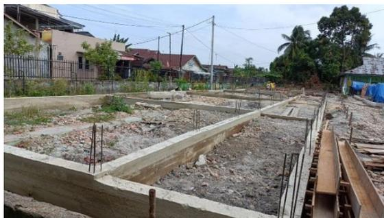
Gambar 3. 15 Pengecoran Sloof
