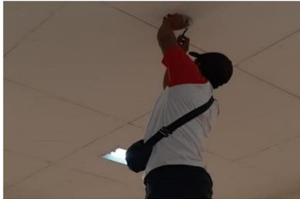
Gambar 3. 64 Pemasangan Lampu Down Light
