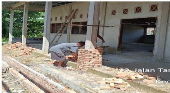
Gambar 3. 27 Pemasangan Bata Kolom
