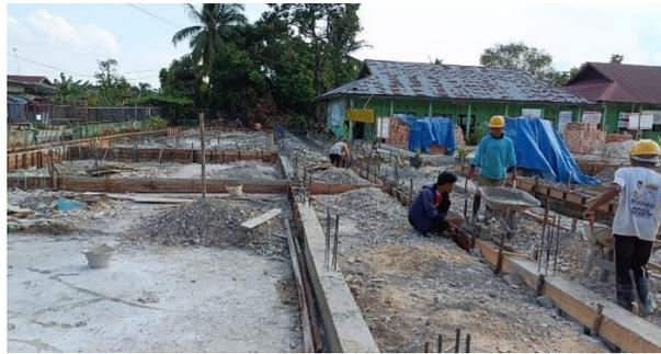
Gambar 3. 14 Pengecoran Sloof
