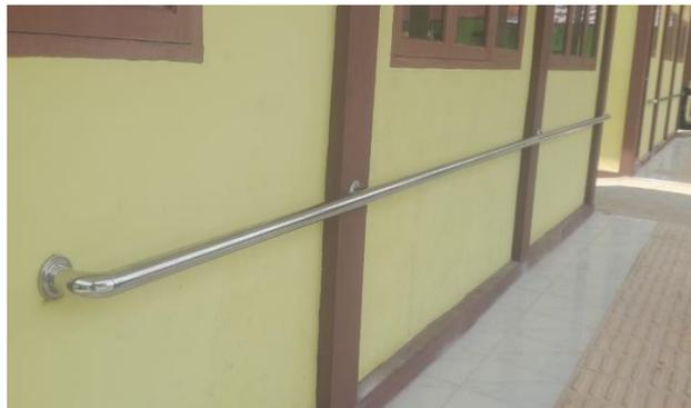
Gambar 3. 31 Pemasangan Handrail
