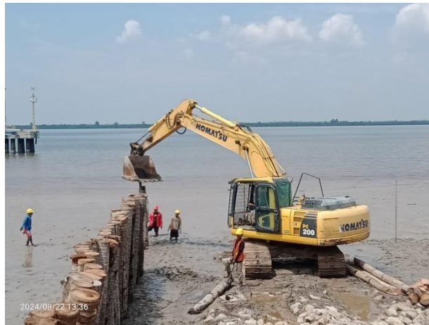
Gambar 3. 20 Pemancangan Batang Kelapa
