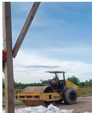
Gambar 3. 48 Vibro Roller (Sumber: Dokumentasi Pribadi, 2024)
