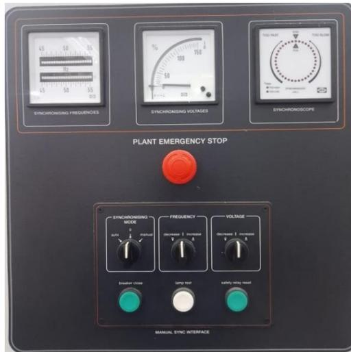
Gambar 4.7 Modul Sinkronisasi Otomatis dan Manual
