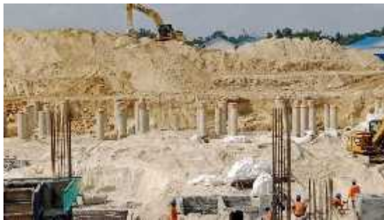
Gambar 3. 3: Pekerjaan Penggalian Tanah
