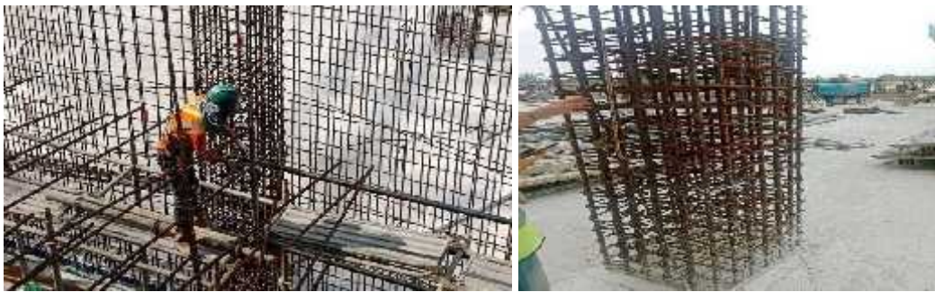
Gambar 3. 16: Pekerjaan tulangan kolom
