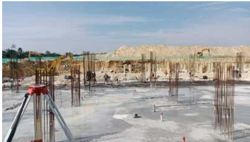
Gambar 3. 14: Persiapan Pekerjaan Kolom
