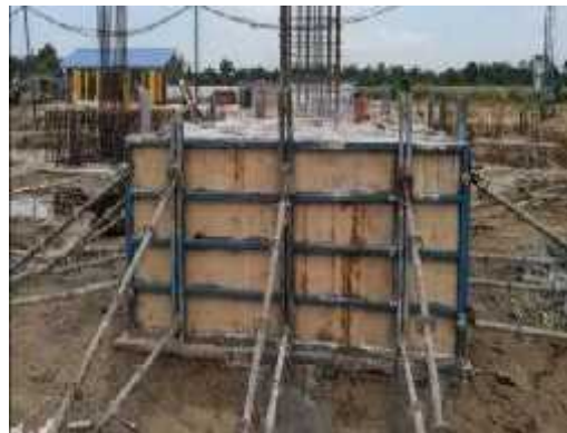
Gambar 3. 7: Pemasangan Bekisting Pile Cap
