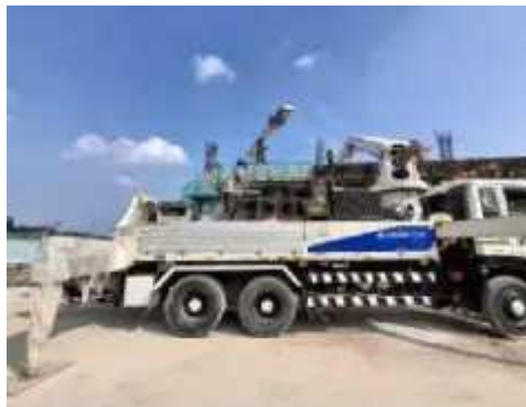
Gambar 3. 18: Pekerjaan Pengecoran Kolom
