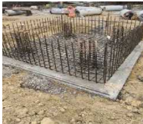
Gambar 3. 6: Pemasangan Tulangan Pile Cap (Sumber : Dokumen pribadi)
