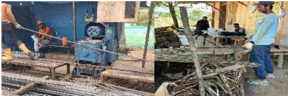
Gambar 3. 15: Pekerjaan Pemotongan dan Pembengkokan Tulangan Kolom (Sumber : Dokumen Proyek)
