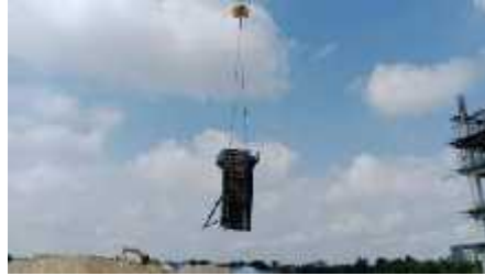
Gambar 3. 19: Pembongkaran Bekisting Kolom
