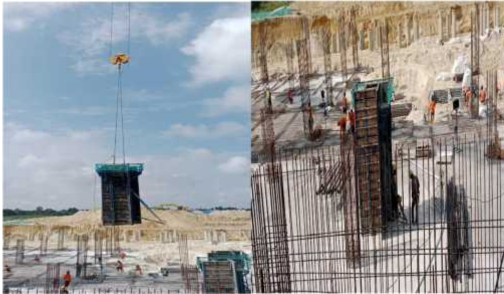
Gambar 3. 17: Pemasangan Bekisting Kolom
