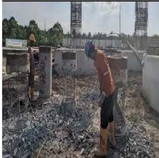
Gambar 3. 4: Pembobokan Tiang Pancang (Sumber : Dokumen pribadi)
