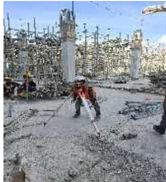
Gambar 3. 22: Marking Elevasi Pada kolom RS UPTV Riau
