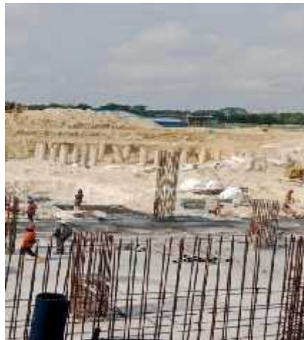
Gambar 3. 5: Pekerjaan Lantai Kerja (Sumber : Dokumen pribadi)
