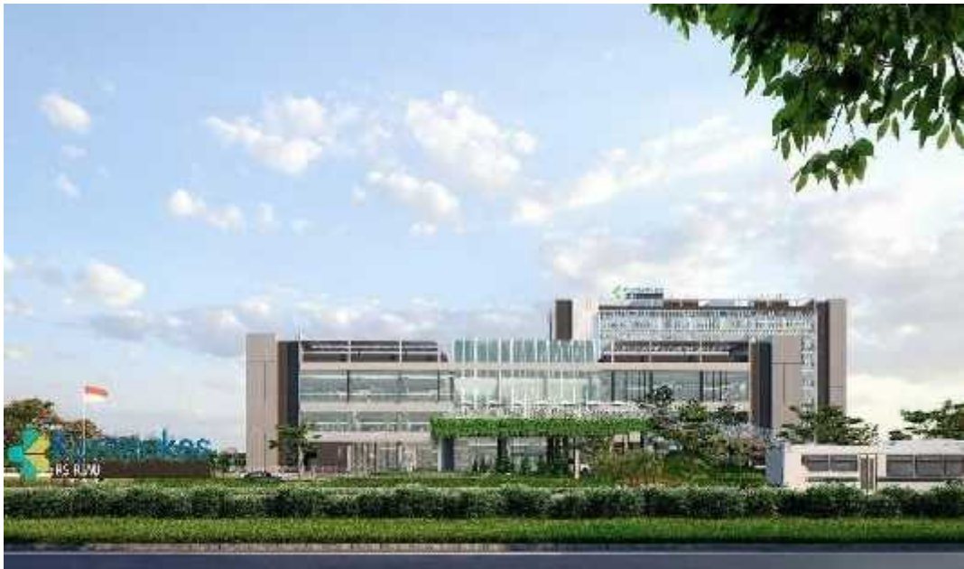
Gambar 4. 10: Tampak Depan Konstruksi Fisik Dan Bangunan Pembangunan Rumah Sakit Upt Vertikal Riau
