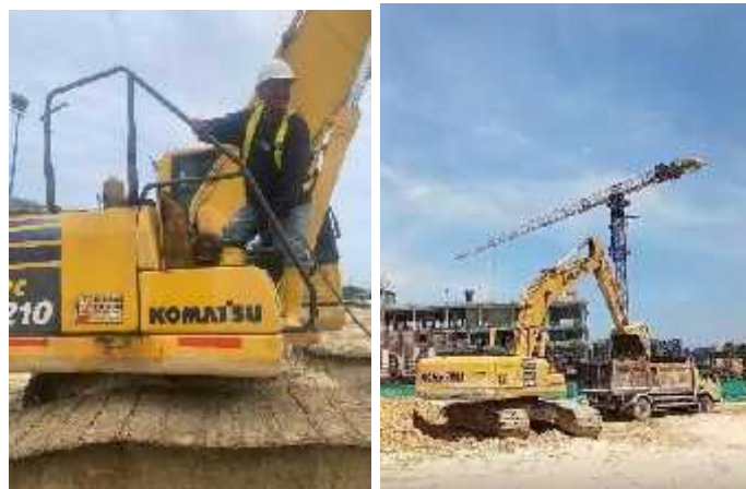
Gambar 2. 48: Excavator (Komatsu PC210)
