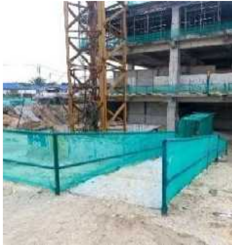
Gambar 2. 68: Pemasangan Safety Line, Rilling, Life Line, dan Safety (Sumbe : Dokumen Pribadi)
