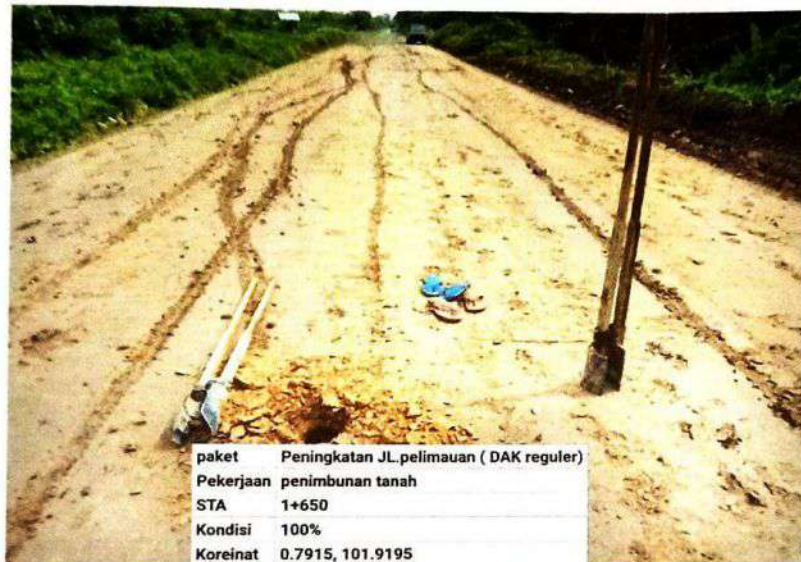
Gambar 3.2. Pengecekan ketebalan timbunan
