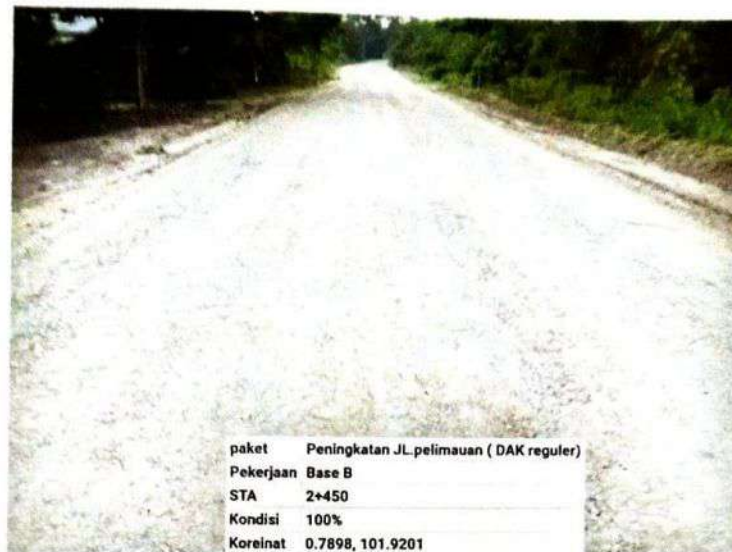
Gambar 3.4. Lapis pondasi agregat kelas B
