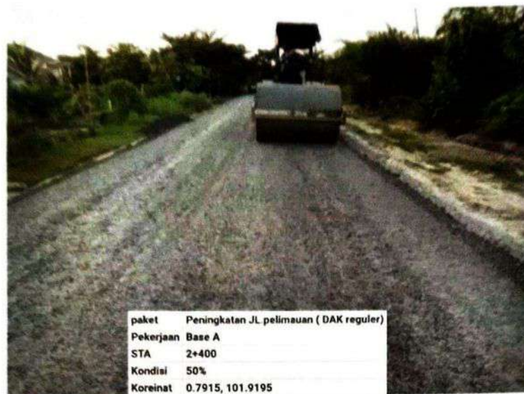
Gambar 3.3. Lapis pondasi agregat kelas A
